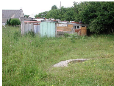
Vue de situation à proximité du bunker - abri de type 501 (état en 2003) Phot. Guillaume Lécueillier IVR53_20062904914NUCA
