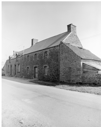
Maison 1 au bourg : vue générale
