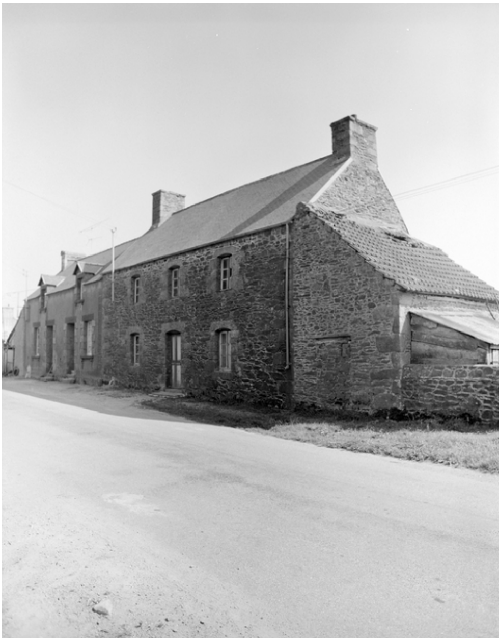
Maison 1 au bourg : vue générale
