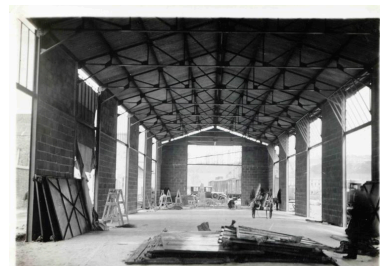
Vue intérieure du hangar situé sur le quai de la Santé : wagons en arrière plan (09/1934) Phot. Etat IVR53_20232906096NUCB
