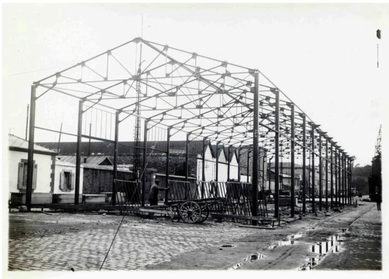
Charpente métallique du hangar (31/08/1934)
