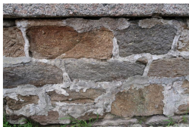
Détail maçonnerie Phot. Erwana L'Haridon IVR53_20202905225NUCA
