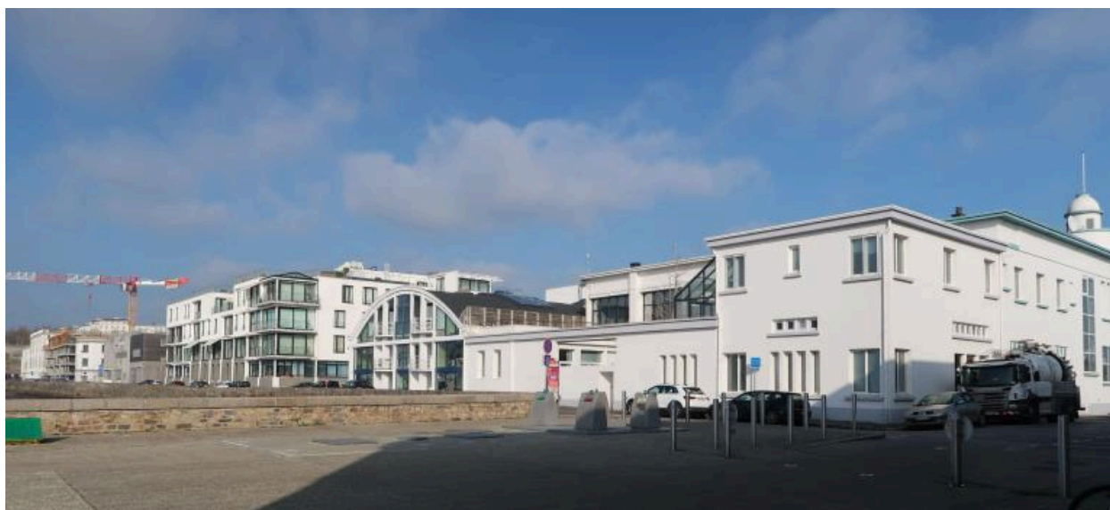
Alignement du bâti, jetée Ouest, côté ouest
