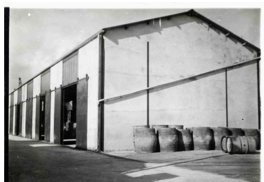
Elévation sud et ouest du hangar construit en 1934 (10/1934) Phot. Etat IVR53_20232906097NUCB
