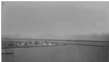
Vue de la jetée ouest et digue sud (J. Duclos, 1873) Autr. Jules Duclos IVR53_20202905271NUCB
