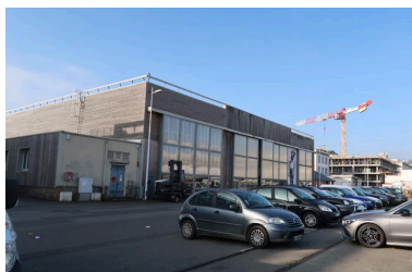
Le chantier du Guip (quai Malbert) Phot. Erwana L'Haridon IVR53_20212905745NUCA
