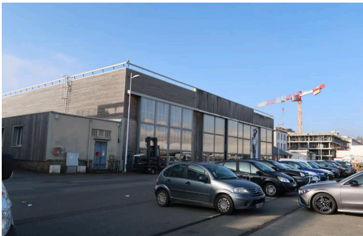
Le chantier du Guip (quai Malbert)
