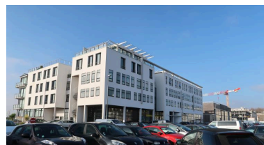
Immeubles de bureaux et de logements (quai Malbert) Phot. Erwana L'Haridon IVR53_20212905746NUCA
