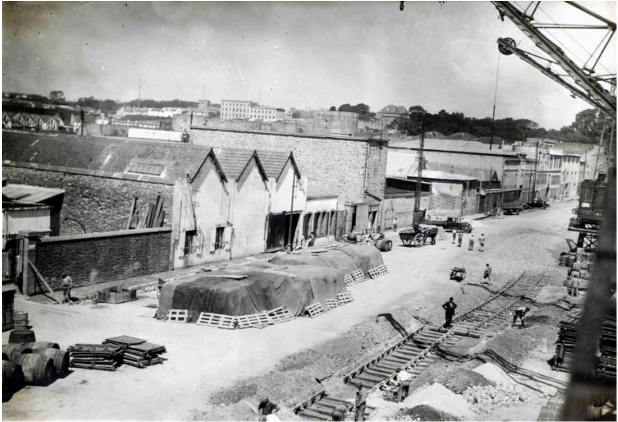
Ripage (déplacement) des voies ferrées pour construire un hangar de stockage (juillet 1934)
