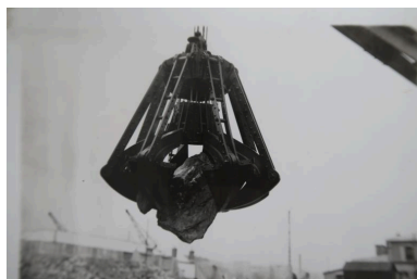
Polype de dragage du "Pierre Chollet" (8/06/1934) Repro. Erwana L'Haridon IVR53_20212905917NUCB
