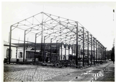
Charpente métallique du hangar (31/08/1934) Phot. Etat IVR53_20232906095NUCB
