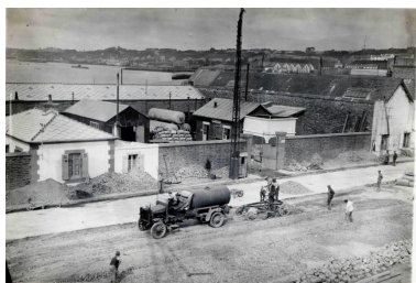
Aménagement de la route pour implantation d'un hangar à proximité du site des Phares et Balises (juillet 1934) Phot. Etat IVR53_20232906094NUCB
