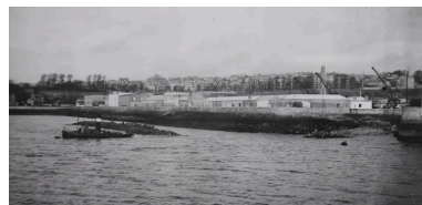
Travaux de remblais pour l'extension du parc des Phares et Balises, novembre 1932 Repro. Erwana L'Haridon IVR53_20212905905NUCB
