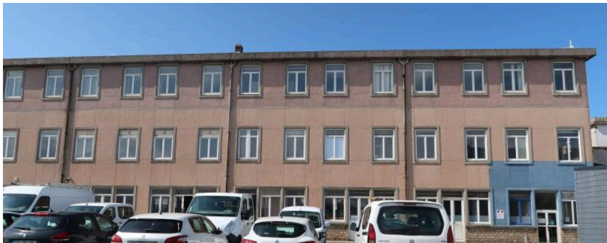
Bâtiment des Phares et Balises
