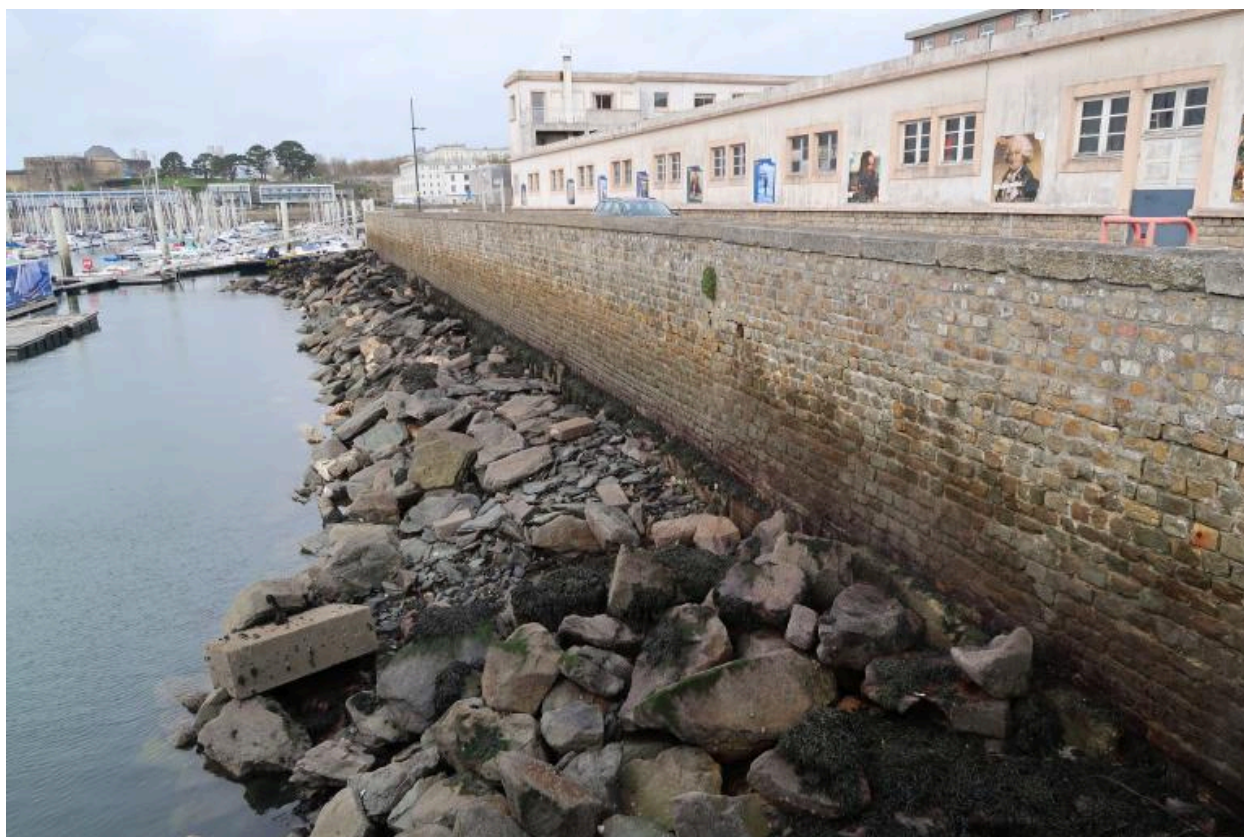
Jetée ouest, maçonnerie du terre-plein (1936)
