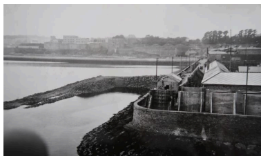
Mise en œuvre des cordons du futur terre-plein (25 mai 1933) Repro. Erwana L'Haridon IVR53_20212905907NUCB
