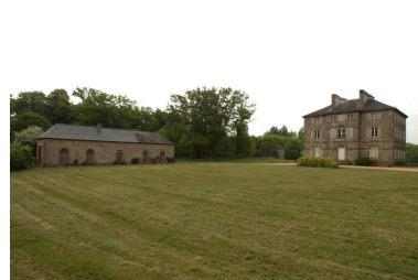
Château, façade nord et aile de communs Phot. Norbert Lambart IVR53_20102202796NUCA
