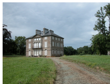
Château, vue générale sud Phot. Véronique Orain IVR53_20092210760NUCA
