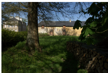
La Ferme du château Phot. Norbert Lambart IVR53_20102202756NUCA
