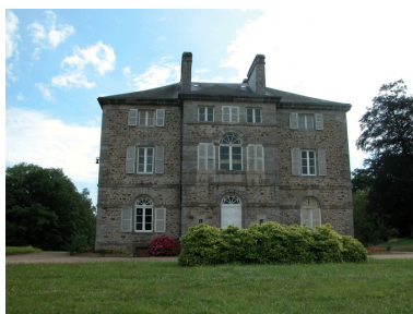
Château, façade nord Phot. Véronique Orain IVR53_20092210841NUCA
