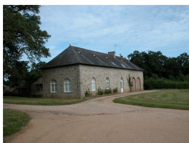
Communs, aile ouest Phot. Véronique Orain IVR53_20092210783NUCA
