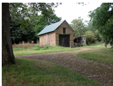
Ferme située à l'ouest, la grange Phot. Véronique Orain IVR53_20092210798NUCA
