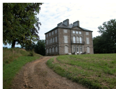
Château, vue générale sud Phot. Véronique Orain IVR53_20092210759NUCA
