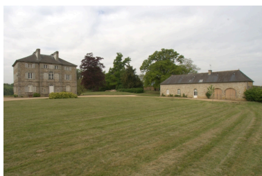
Château, façade nord et aile de communs Phot. Norbert Lambart IVR53_20102202795NUCA
