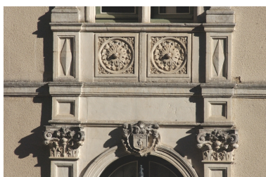
Façade sud : détail de l'allège au- dessus de la porte d'entrée (armoiries) Phot. Norbert Lambart IVR53_20033501742NUCA
