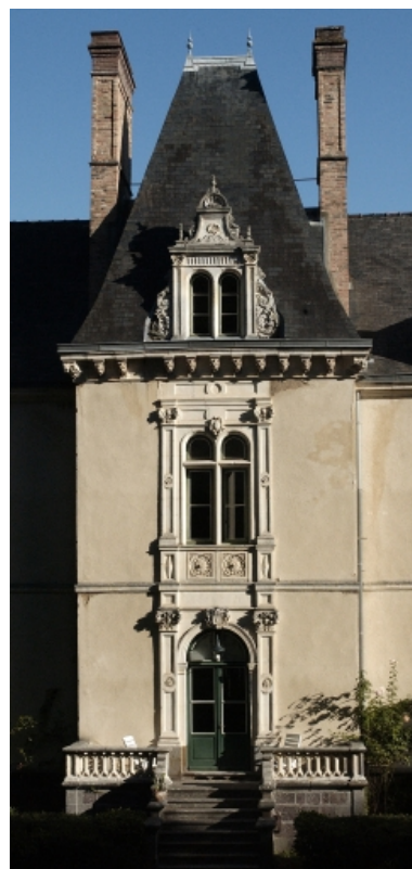
Façade sud : détail du corps d'entrée Phot. Norbert Lambart IVR53_20033501735NUCA
