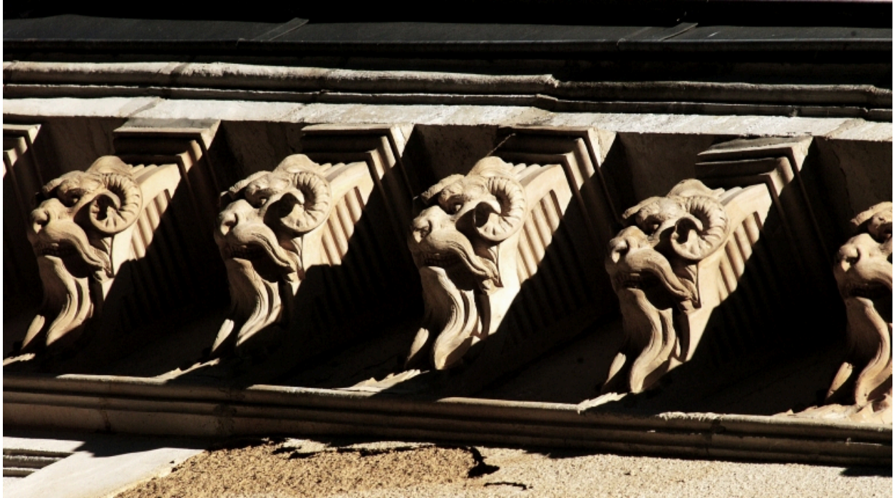
Façade sud : détail de la corniche
