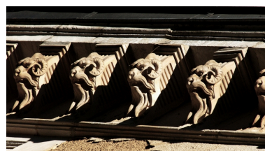
Façade sud : détail de la corniche Phot. Norbert Lambart IVR53_20033501741NUCA
