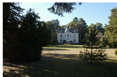
Vue de situation depuis le nord Phot. Norbert Lambart IVR53_20033501733NUCA
