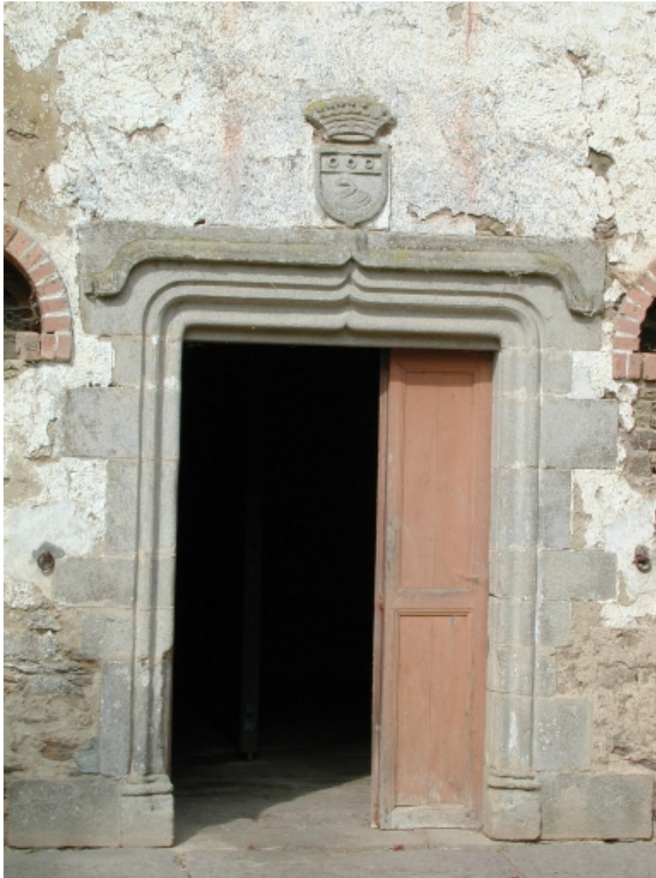
Les communs, détail de la façade est : l'encadrement de la porte est un remploi de l'ancienne chapelle
