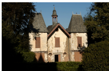
Les communs : écuries, remise à voitures et logement du plafrenier Phot. Norbert Lambart IVR53_20033514642NUCA
