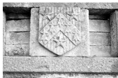
Blason porte d'entrée en 1971 Phot. Barguil IVR53_19713500722Z
