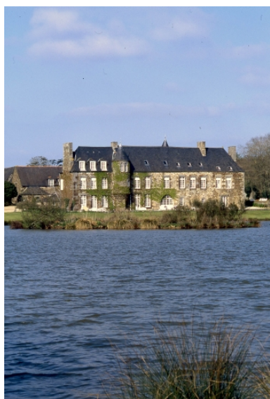
Vue générale sud en 1994 Phot. Claude Quillivic IVR53_19943502786ZA
