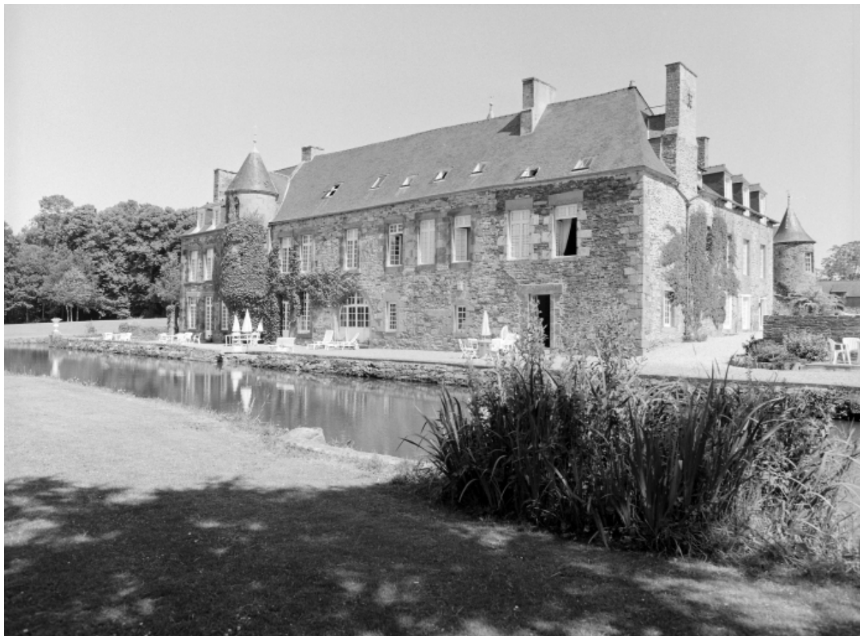
Vue générale sud est
