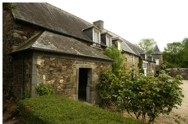
Communs ; vue générale sud ouest Phot. Norbert Lambart IVR53_20063500973NUCA
