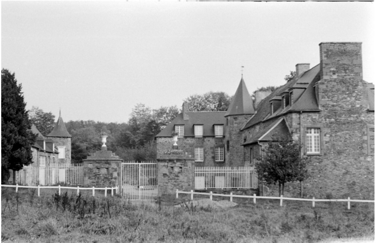
Vue générale ouest
