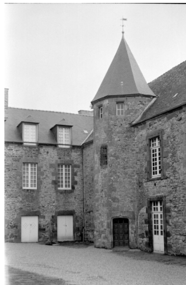
Tour d'escalier ; vue générale nord ouest Phot. Barguil IVR53_19713500721Z
