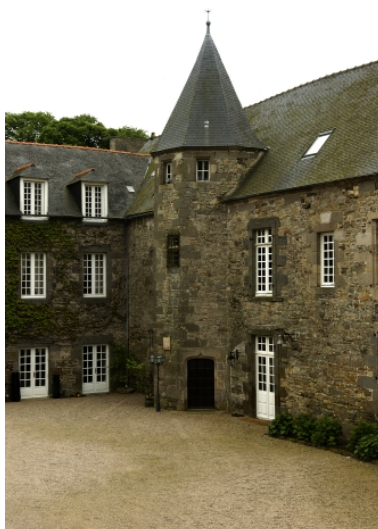
Tour d'escalier ; vue générale nord ouest Phot. Norbert Lambart IVR53_20063500974NUCA
