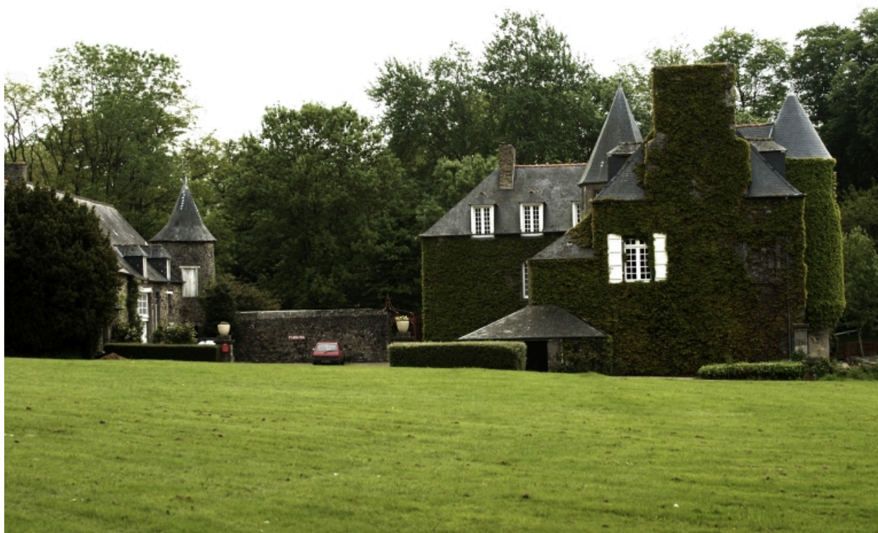
Vue générale ouest
