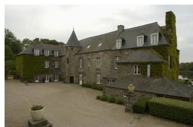
Cour ; vue générale nord ouest Phot. Norbert Lambart IVR53_20063500972NUCA
