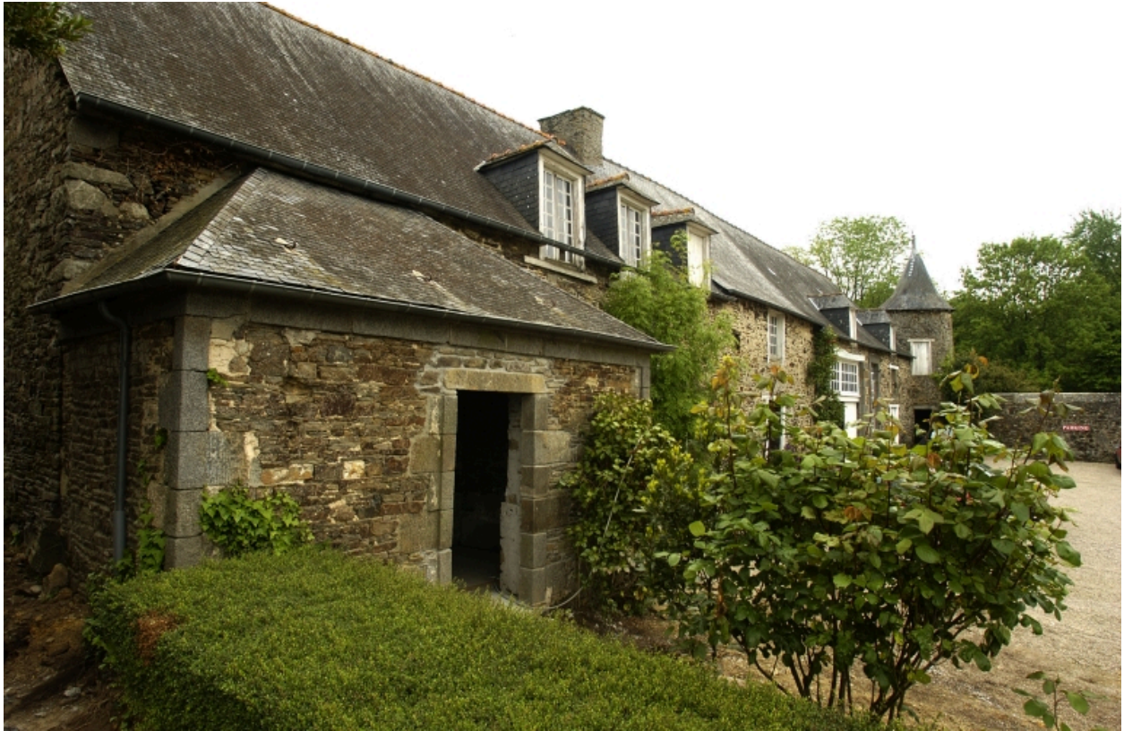
Communs ; vue générale sud ouest
