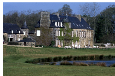
Vue générale sud ouest Phot. Claude Quillivic IVR53_19943502787ZA
