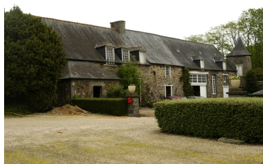
Communs ; vue générale sud ouest Phot. Norbert Lambart IVR53_20063500976NUCA
