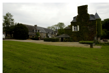
Vue générale sud ouest Phot. Norbert Lambart IVR53_20063500975NUCA
