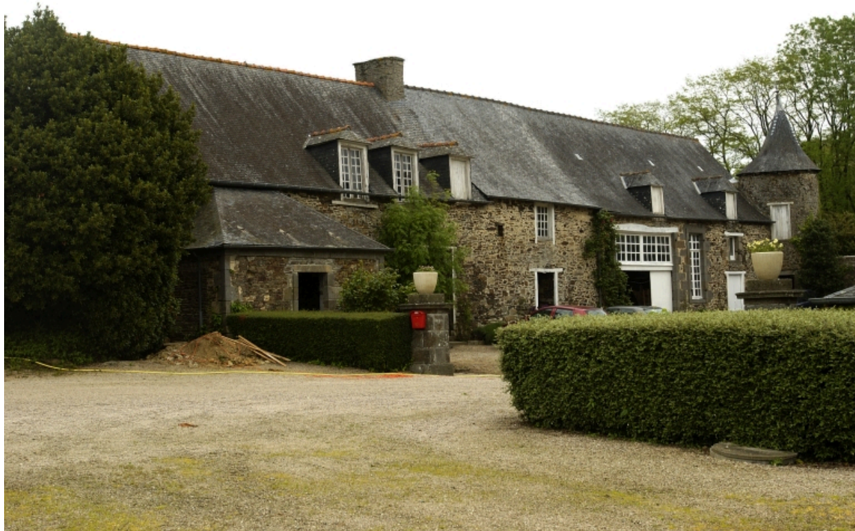
Communs ; vue générale sud ouest
