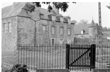
Vue générale sud est Phot. Barguil IVR53_19713500720Z
