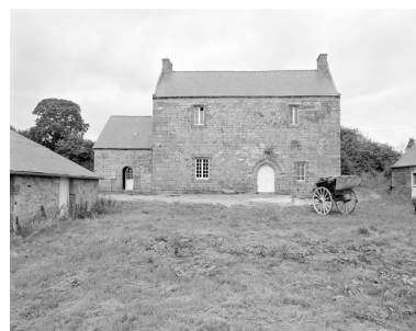
Elévation sud : vue générale Phot. Service régional de l'Inventaire de Bretagne IVR53_19822200266X
