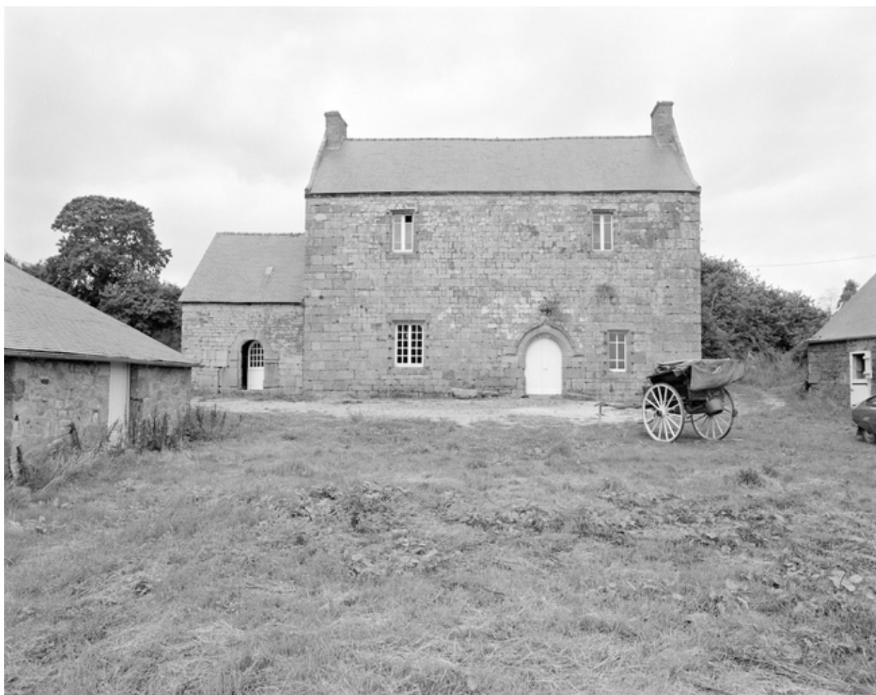
Elévation sud : vue générale
