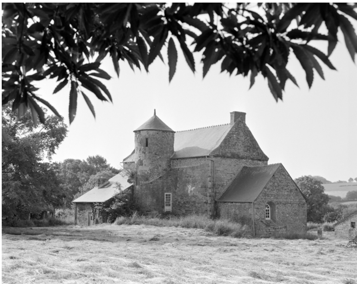
Elévation nord : vue générale
