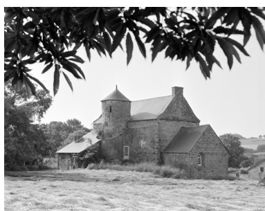
Elévation nord : vue générale Phot. Service régional de l'Inventaire de Bretagne IVR53_19822200265X
