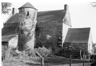
Elévation nord Phot. Brulon IVR53_19662200568Z
