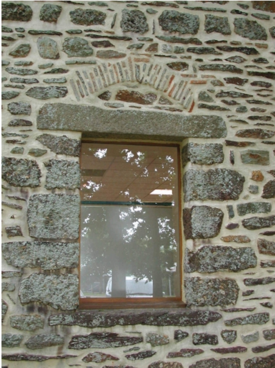
Détail sur la fenêtre du mur sud-est des anciennes remises
