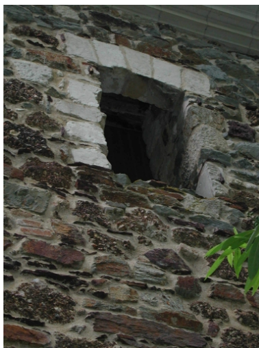
Détail sur l'accès à la chambre des cloches Phot. Isabelle Barbedor IVR53_20023516046NUCA
