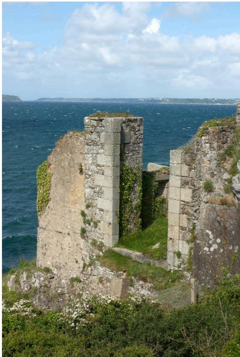
Vue de l'extrémité de la branche tombante sud : accès d'origine du fort du Corbeau au 18<sup>e</sup> siècle avec porte et pont-levis permettant de franchir le fossé sec obtenu par déroctage de la falaise. A gauche de la porte, la maçonnerie a conservé son enduit
