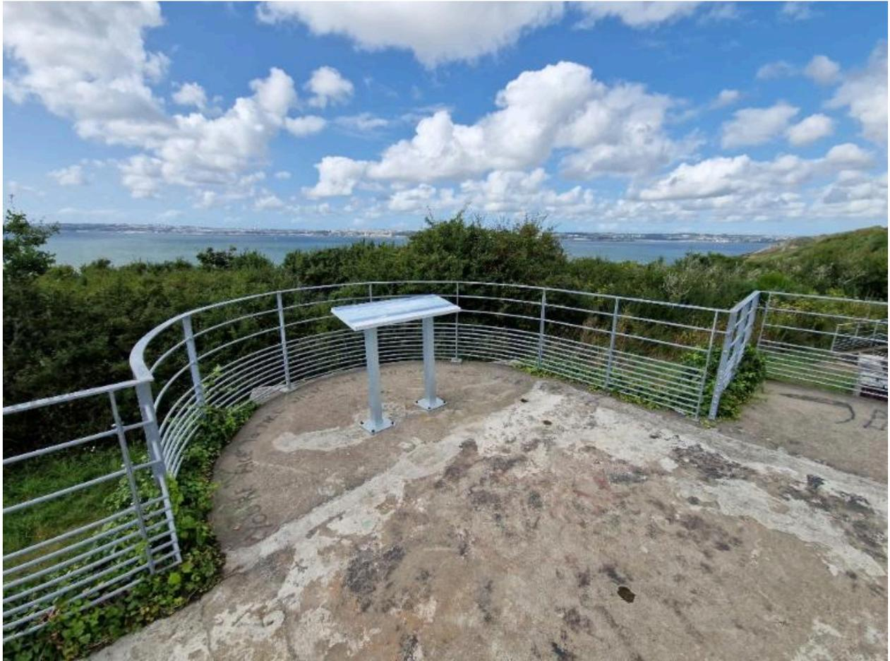
Vue du belvédère aménagé sur la dalle de couverture du poste de commandement de groupe d'artillerie avec son garde-corps en acier galvanisé (état en 2024). La chambre de veille a été déconstruite
