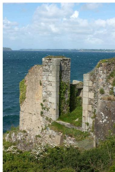
Vue de l'extrémité de la branche tombante sud : accès d'origine du fort du Corbeau au 18e siècle avec porte et pont-levis permettant de franchir le fossé sec obtenu par déroctage de la falaise. A gauche de la porte, la maçonnerie a conservé son enduit
