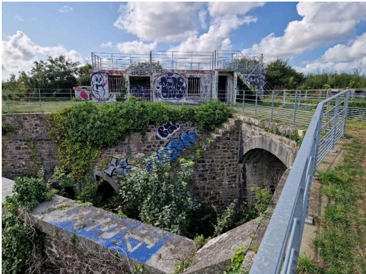
Vue des deux ponts d'accès à la redoute et du poste de commandement de groupe d'artillerie avec leurs garde-corps en acier galvanisé (état en 2024). Des escaliers permettent d'accéder dans la cour située en contrebas
