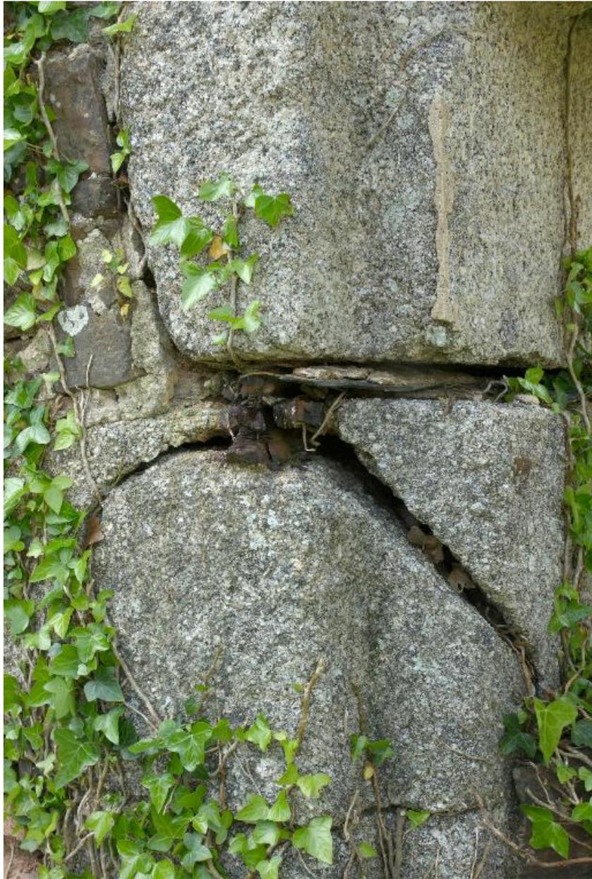
Vue de détail d'un gond qui en s'oxydant a fracturé une pierre de taille en granite (état en 2009)
