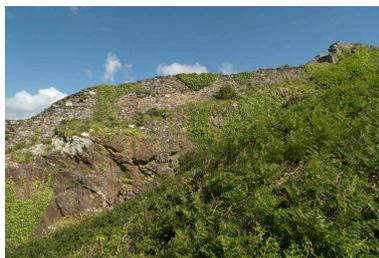
Vue de détail de la branche tombante du retranchement sud : le mur en maçonnerie repose sur le rocher de la falaise qui a été escarpée (état en 2009)
