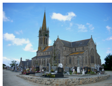
Plourin-Ploudalmézeau, église paroissiale : vue générale sud-est Phot. Gwénaél Fauchille IVR53_20082906208NUCA
