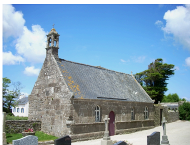
Plourin-Ploudalmézeau, église paroissiale : ossuaire, vue générale sud-est Phot. Gwénaél Fauchille IVR53_20082906210NUCA
