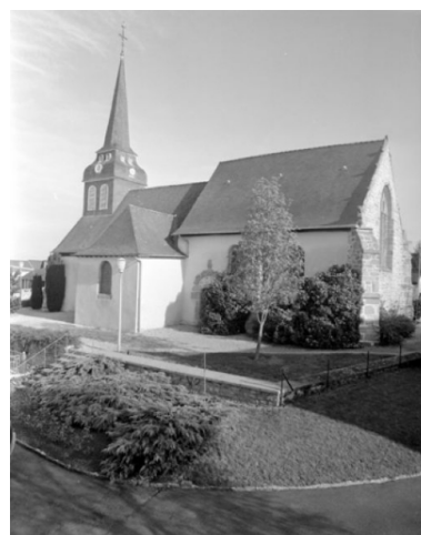
Elévation sud-est : vue générale Phot. Guy Artur, Phot. Norbert Lambart IVR53_19943500768X
