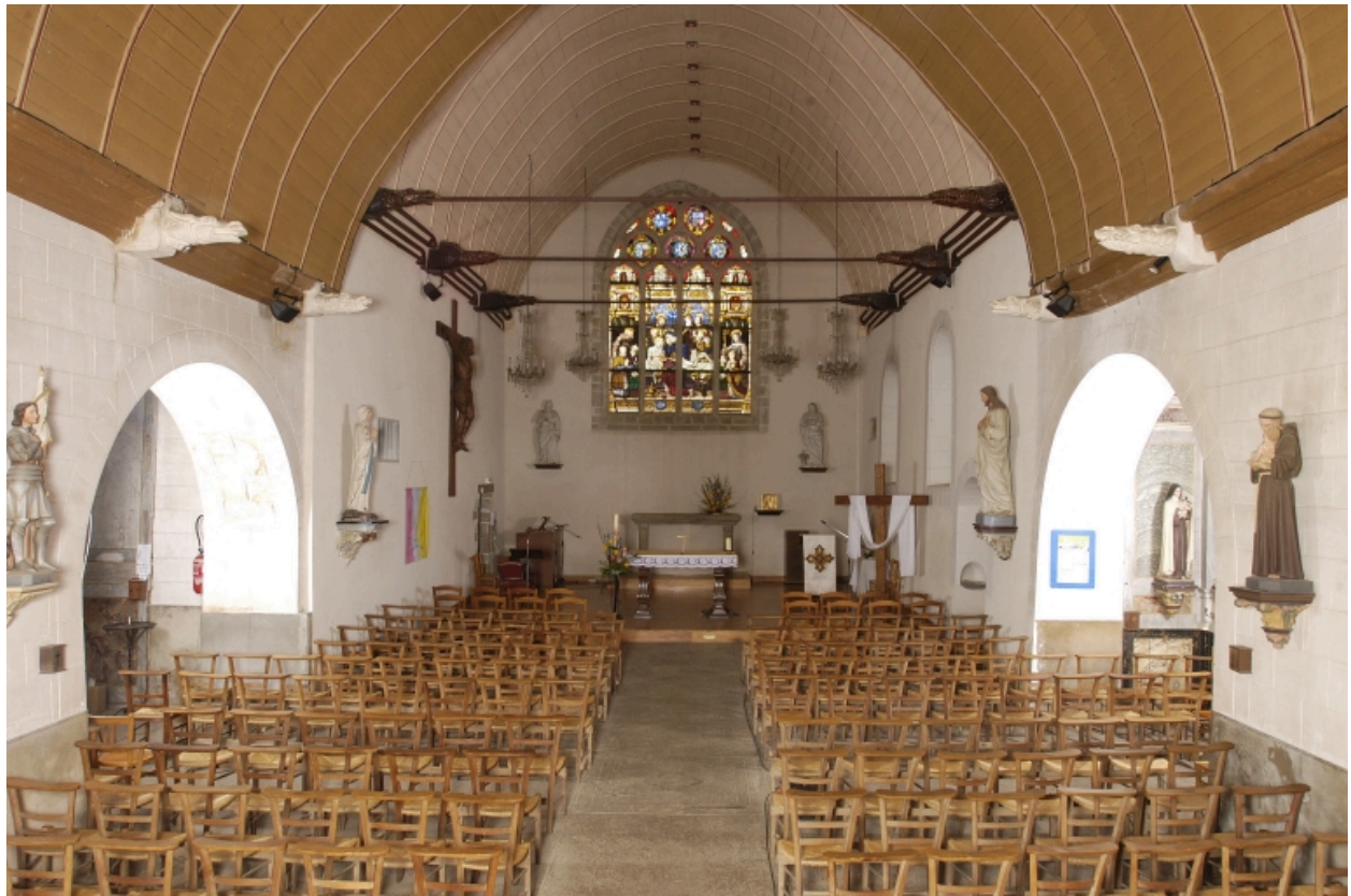
Vue intérieure prise de la nef vers le chœur
