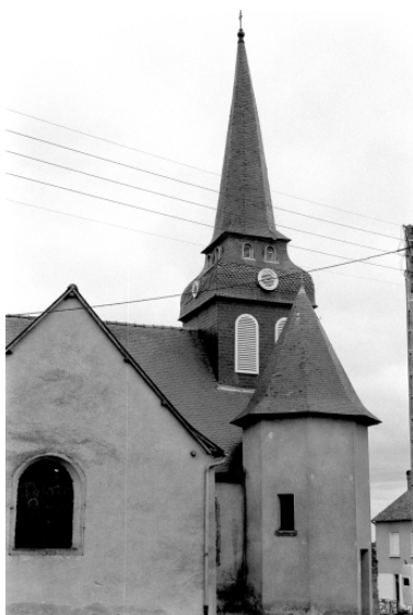
Vue générale du clocher Phot. N. Toudic IVR53_19753500865X
