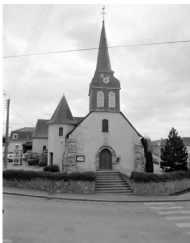
Elévation ouest : vue générale Phot. Guy Artur, Phot. Norbert Lambart IVR53_19943500832X
