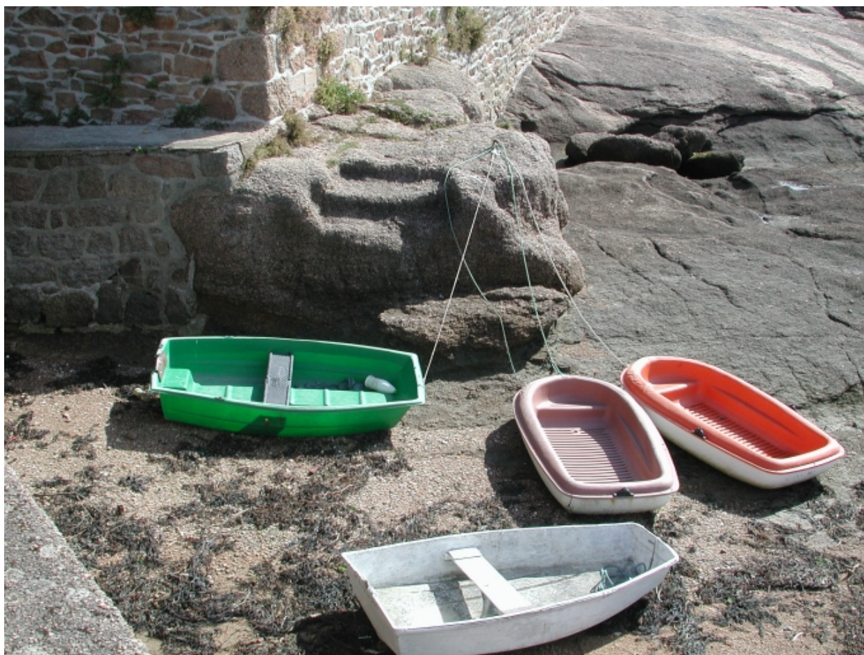
Les petits ouvrages de Porz ar Ch'anojou (le port des petits canots) : l'escalier taillé dans le roc et le parapet qui mène à la cale Padel
