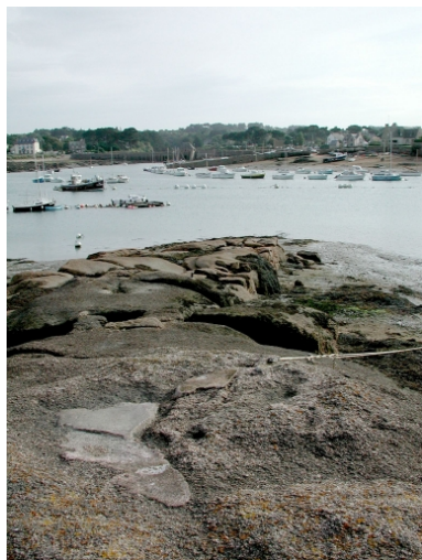
Vue de la cale Padel depuis son enrochement et son enracinement à la côte Phot. Guy Prigent IVR53_20062207701NUCA
