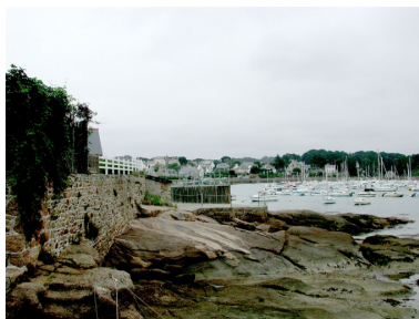
Emplacement de l'ancien établissement du mareyeur Padel et début de la cale Phot. Guy Prigent IVR53_20062207704NUCA
