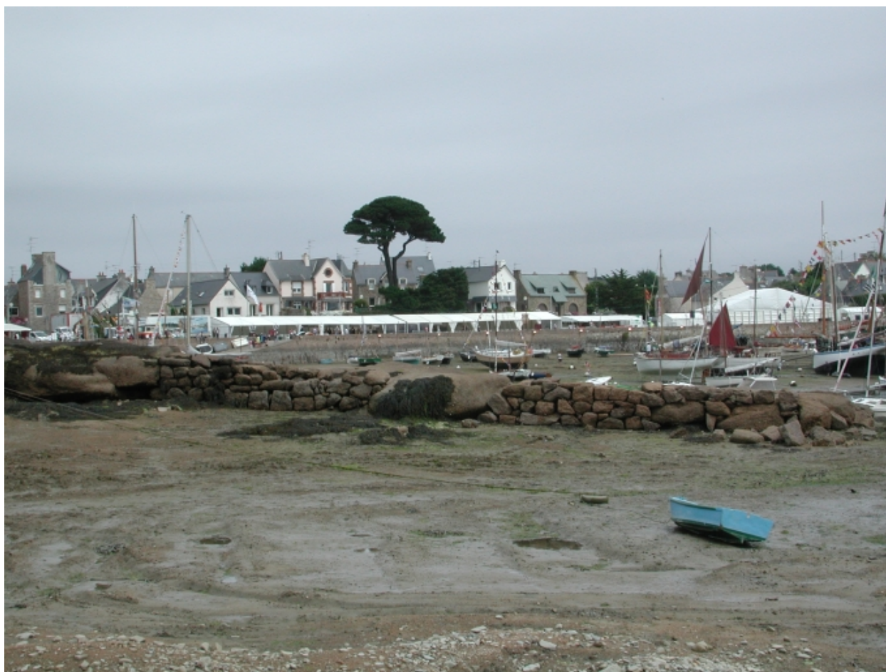
Vue latérale de la cale Padel, qui protège avec sa pointe la plage du port
