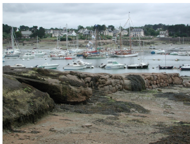
Vue de la cale Padel à marée basse avec ses gros blocs de granit posés à sec Phot. Guy Prigent IVR53_20062207702NUCA
