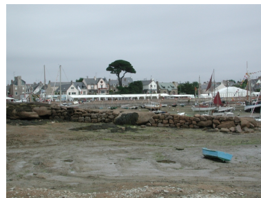
Vue latérale de la cale Padel, qui protège avec sa pointe la plage du port Phot. Guy Prigent IVR53_20062207703NUCA
