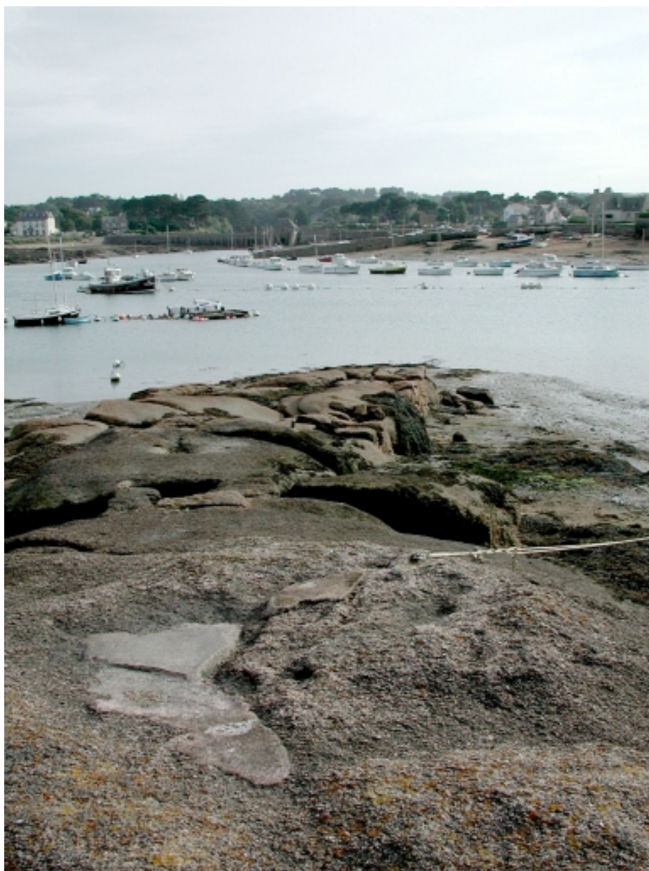
Vue de la cale Padel depuis son enrochement et son enracinement à la côte
