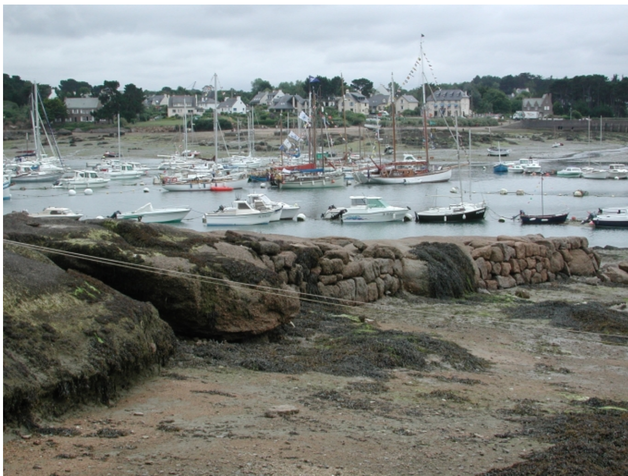
Vue de la cale Padel à marée basse avec ses gros blocs de granit posés à sec
