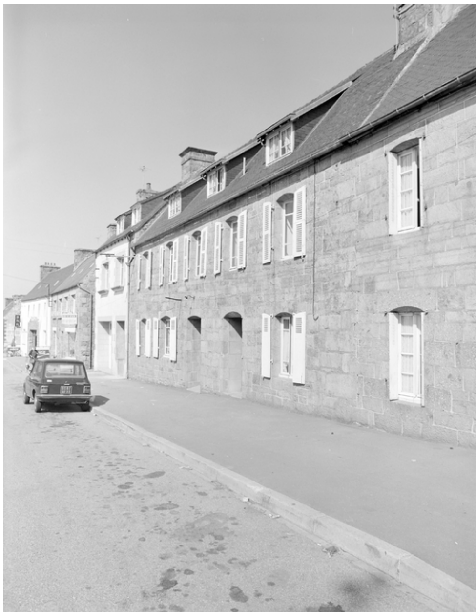
Maison 5 au bourg : vue générale sud
