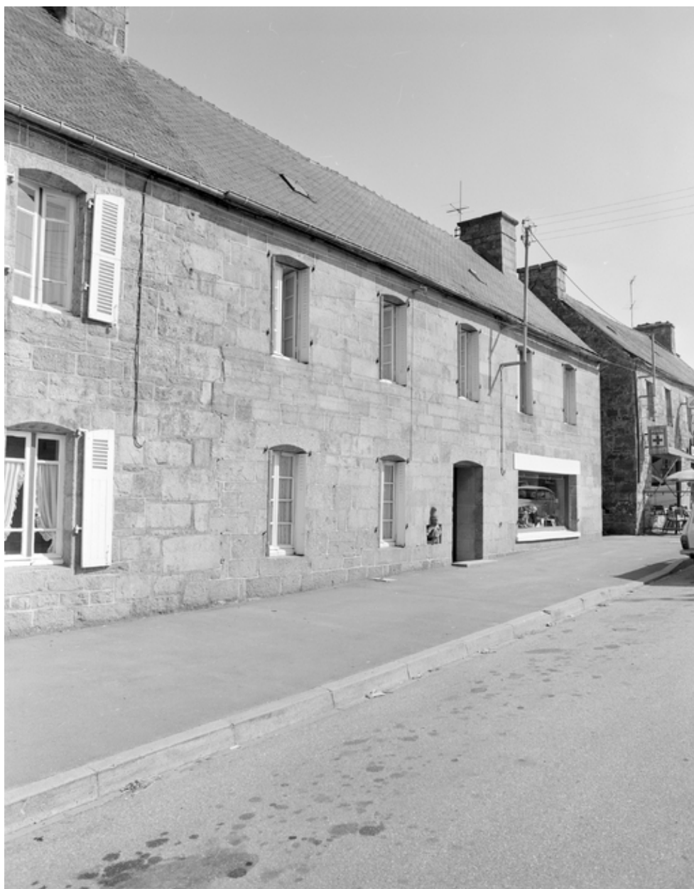
Maison 6 au bourg : vue générale sud
