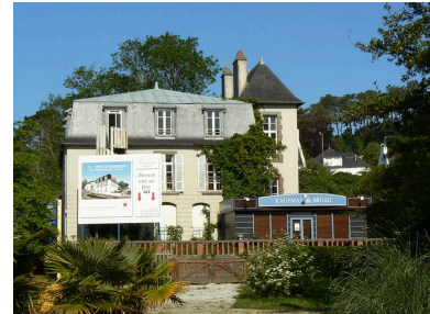
Façade ex-Grand Hôtel de Morgat Phot. Johan Vincent IVR53_20072908756NUCA
