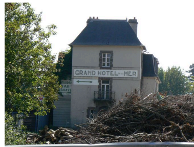
Vue latérale de l'ex-Grand Hôtel de Morgat Phot. Julien Amghar IVR53_20072908754NUCA
