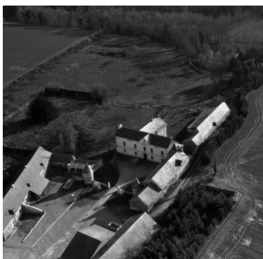
Vue aérienne nord
