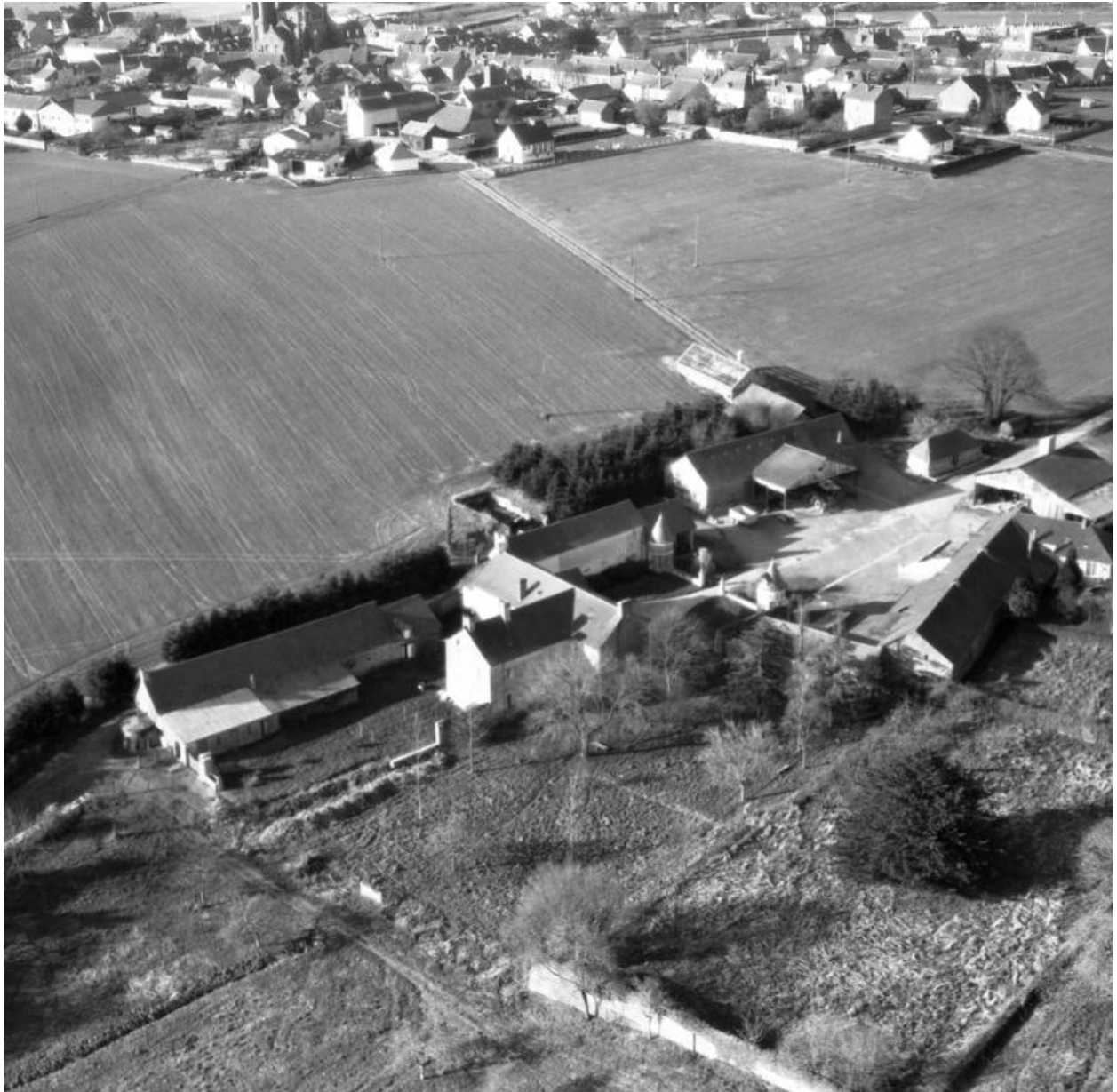
Vue aérienne sud-ouest
