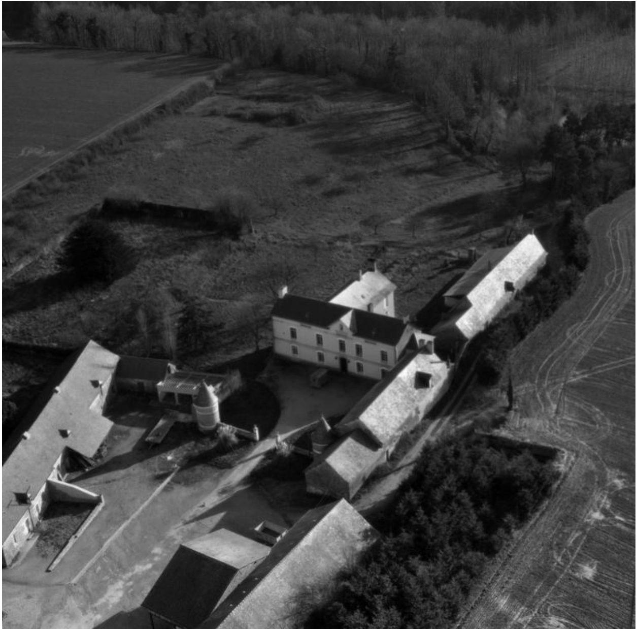
Vue aérienne nord
