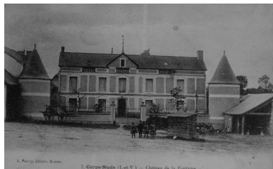
Vue générale au début du 20e siècle.
