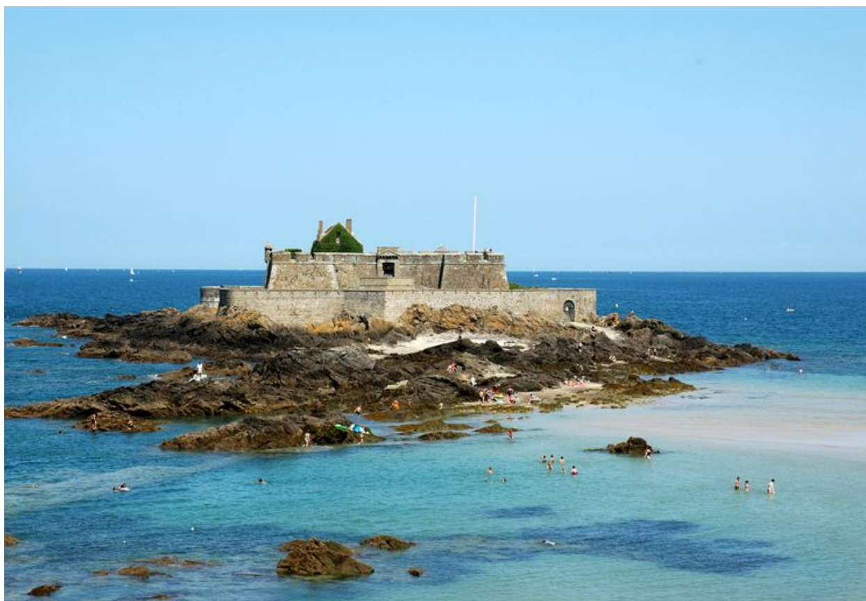
Vue générale du fort National à marée basse
