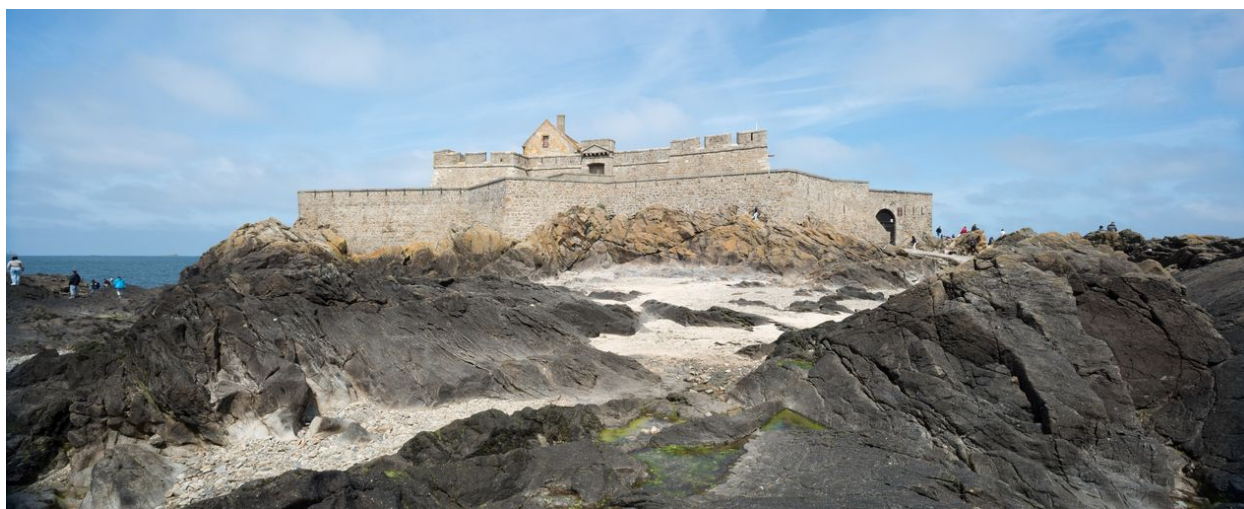
Vue panoramique depuis le sud-est à marée basse
