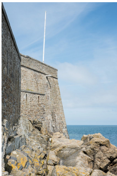
Vue de détail d'une élévation, est du fort Phot. Charlotte Barraud IVR53_20223500386NUCA
