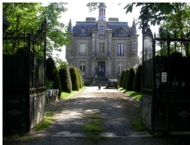
Vue générale ouest Phot. Stéphanie Ménard IVR53_20053507808NUCA
