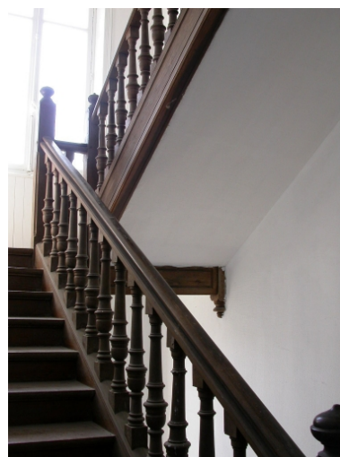
L'escalier à balustrés Phot. Stéphanie Ménard IVR53_20053507815NUCA
