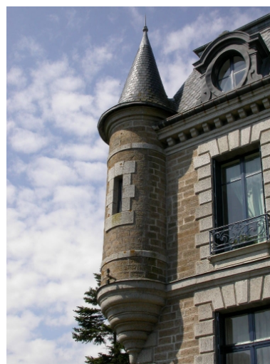
Détail de l'une des échauguettes Phot. Stéphanie Ménard IVR53_20053507812NUCA
