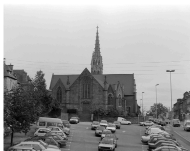
Élévation ouest, en 1994 Phot. Guy Artur, Phot. Norbert Lambart IVR53_19943502397X
