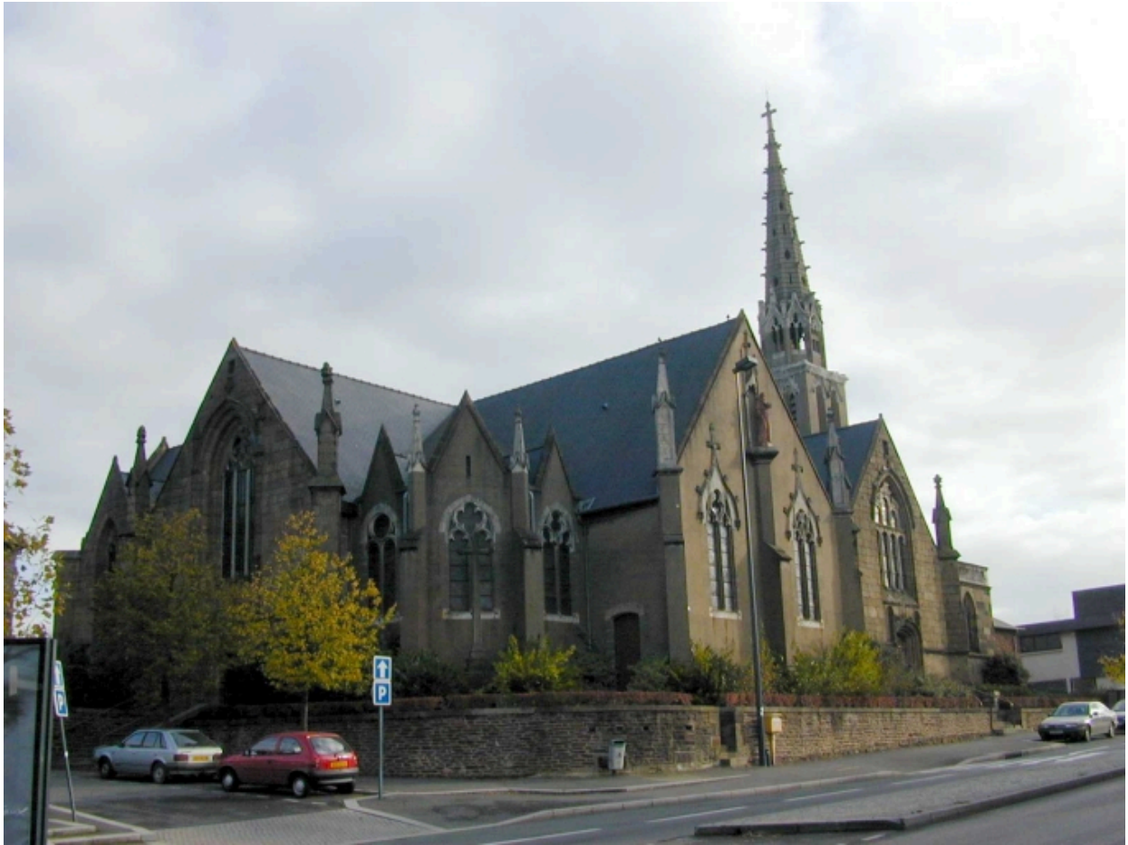
Vue depuis la rue Saint-Hélier
