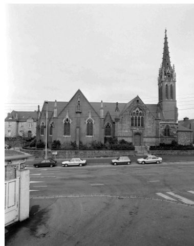
Élévation sud, en 1994 Phot. Guy Artur, Phot. Norbert Lambart IVR53_19943502398X
