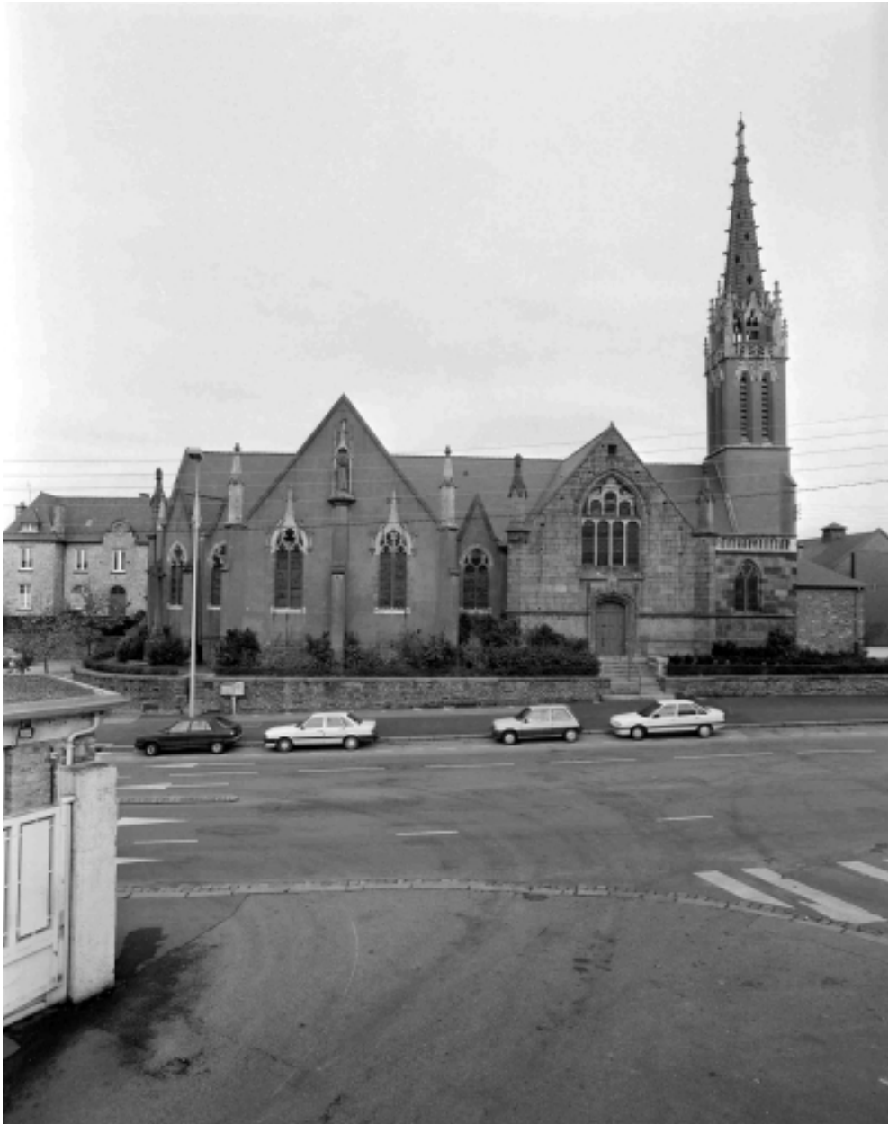
Elévation sud, en 1994
