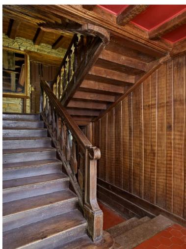
Logis. Vestibule d'entrée. Escalier construit entre le mur de refend et une cloison en menuiserie
