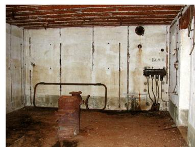
Bunker - abri pour deux groupes de type 502 (B 69/1) de Kervaoter : vue de la chambre de troupe de droite avec son boîtier de connexion téléphonique surmonté du numéro "B 69/1", son poêle de forteresse, un châssis tubulaire de couchette posé contre le mur et son câblage... (état en 2003)
