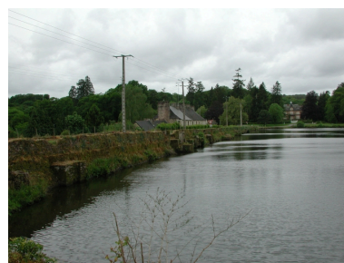
Vue de situation est Phot. Claude Quillivic IVR53_20023512743NUCA
