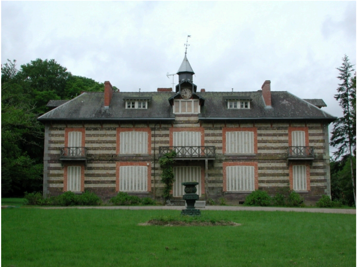
Vue générale est
