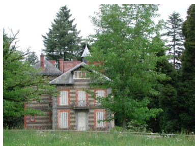
Vue générale sud Phot. Claude Quillivic IVR53_20023512821NUCA
