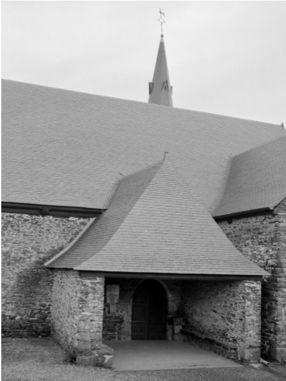
Elévation Sud, porte : vue générale
