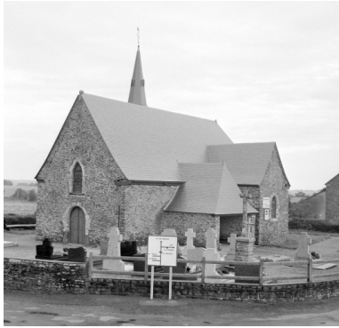
Elévation Sud-Ouest : vue générale Phot. Guy Artur, Phot. Norbert Lambart IVR53_19943501773X
