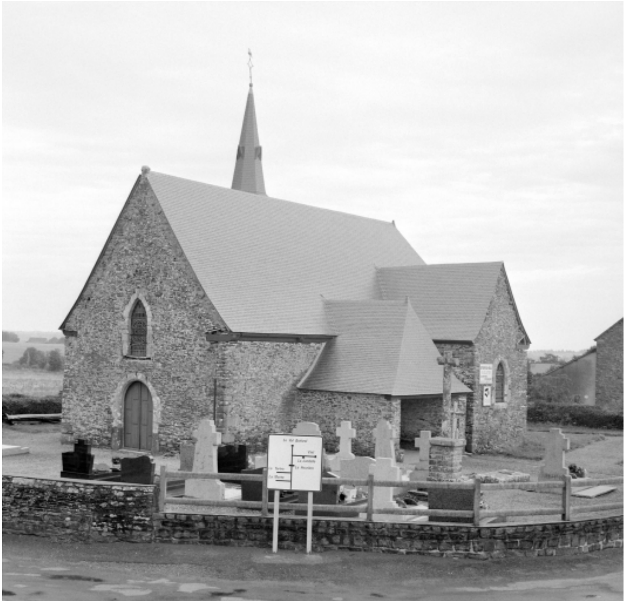
Elévation Sud-Ouest : vue générale
