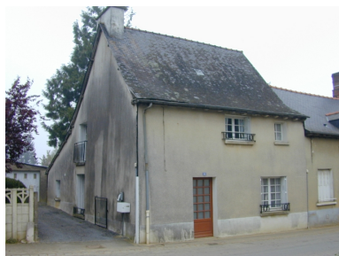
Vue générale sud-ouest Phot. Xavier Gilbert IVR53_20013508517NUCA
