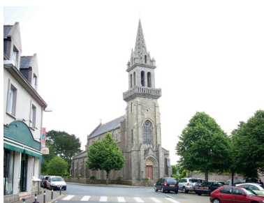
Bohars, église paroissiale : vue générale nord-ouest Phot. Gwénaél Fauchille IVR53_20082906382NUCA
