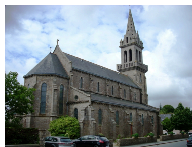
Bohars, église paroissiale : vue générale nord-est Phot. Gwénaél Fauchille IVR53_20082906383NUCA
