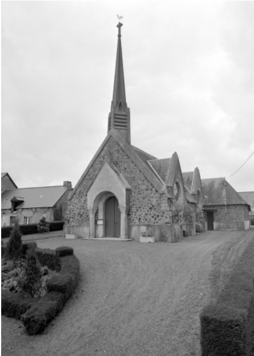
Elévation Sud : vue générale
