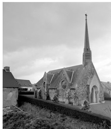
Elévation Ouest : vue générale
