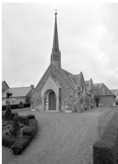
Elévation Sud : vue générale
