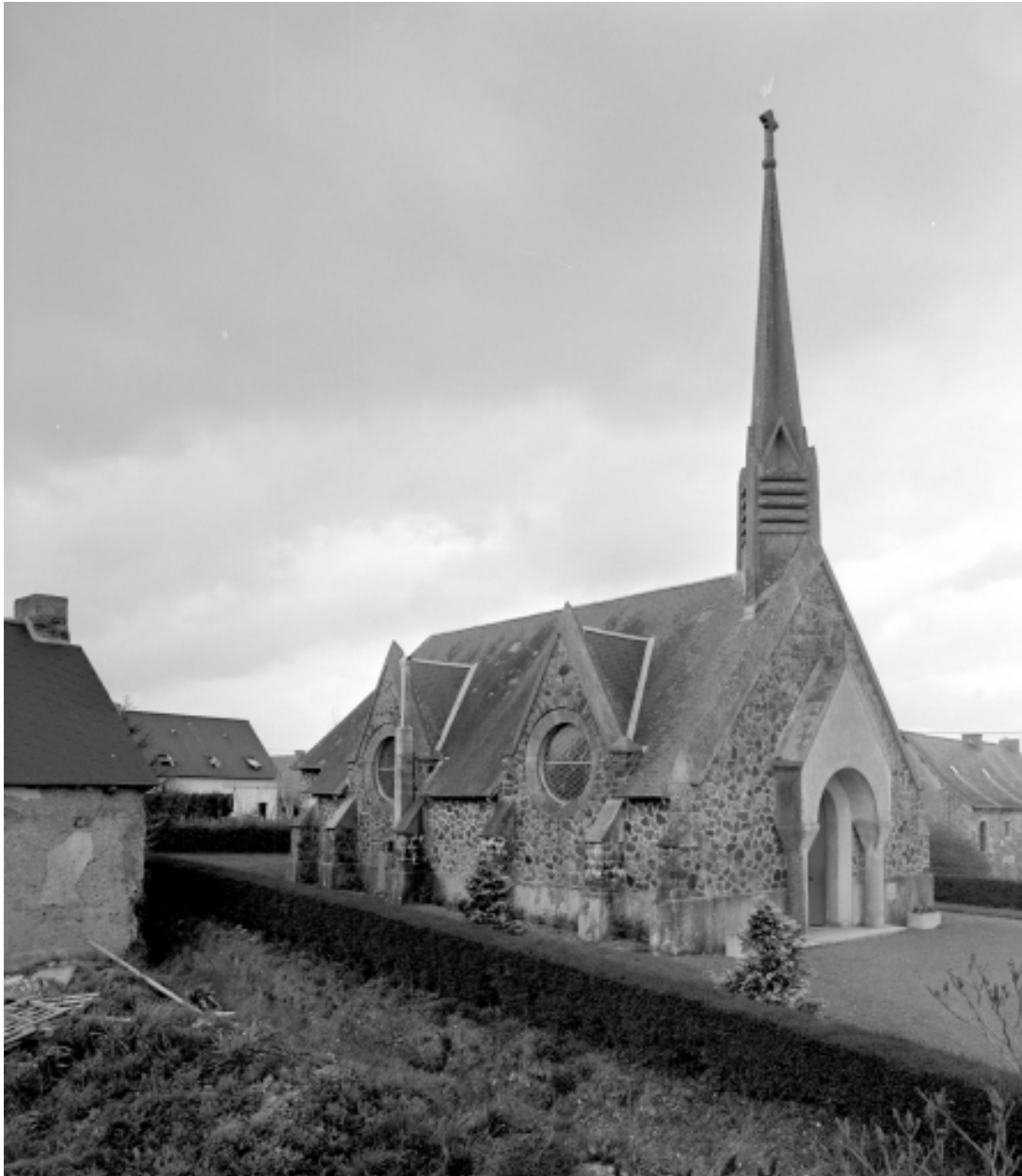
Elévation Ouest : vue générale
