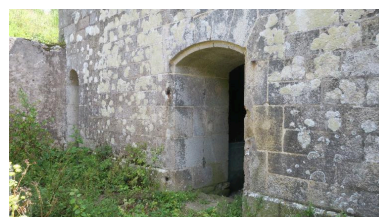
Hoedic, fort central, magasin à poudre, porte. Phot. Lionel Duigou IVR53_20175606480NUCA
