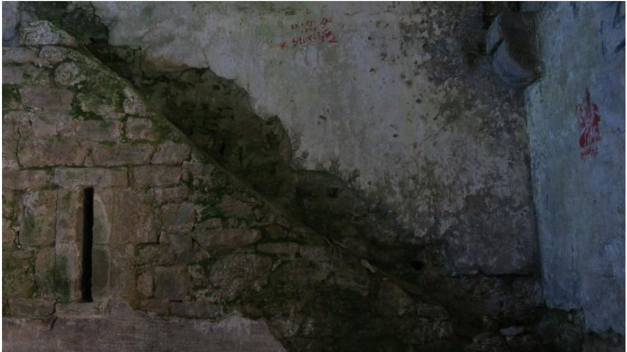
Hoedic, fort central, magasin à poudre, chambre de stockage, emplacement de l'escalier.
