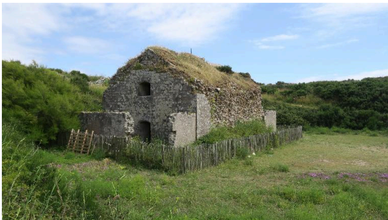
Hœdic, fort central, magasin à poudre, vue générale depuis le nord.
