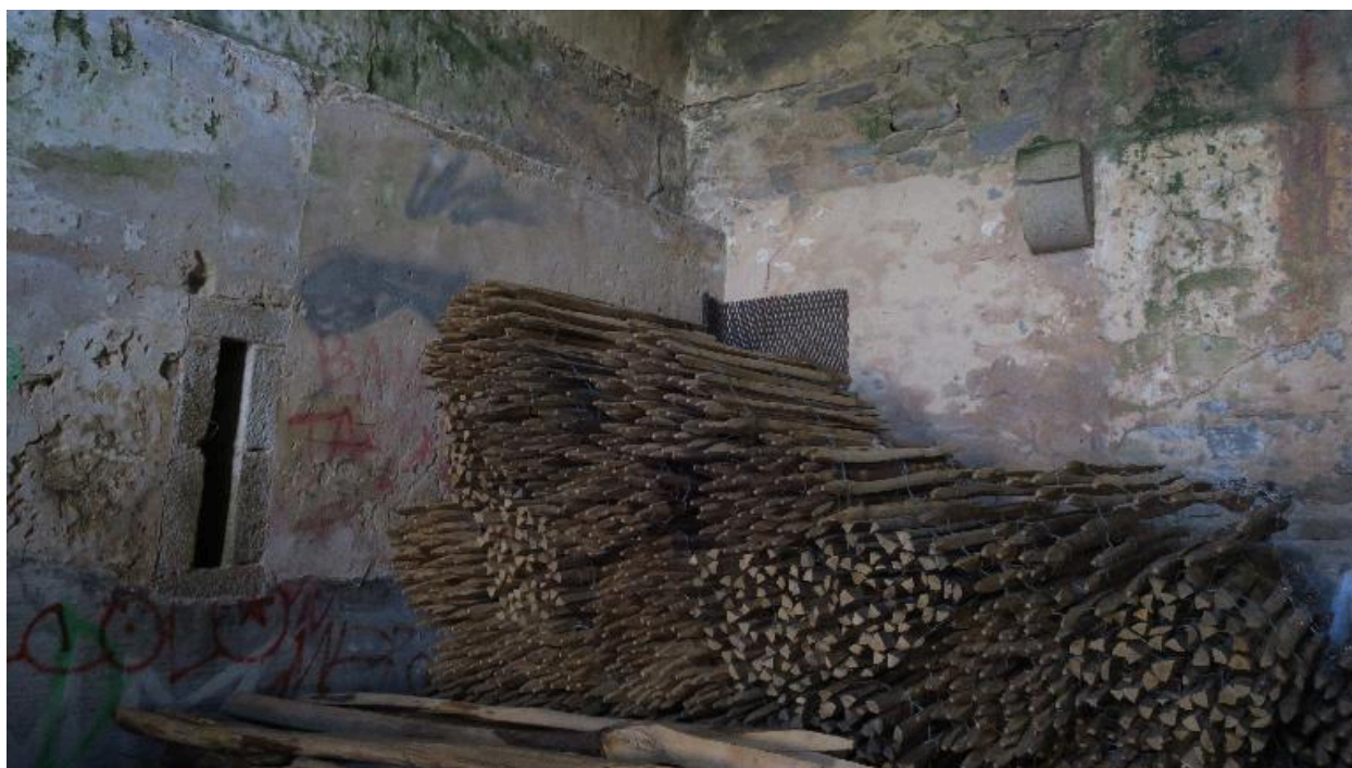
Hoedic, fort central, magasin à poudre, chambre de stockage.
