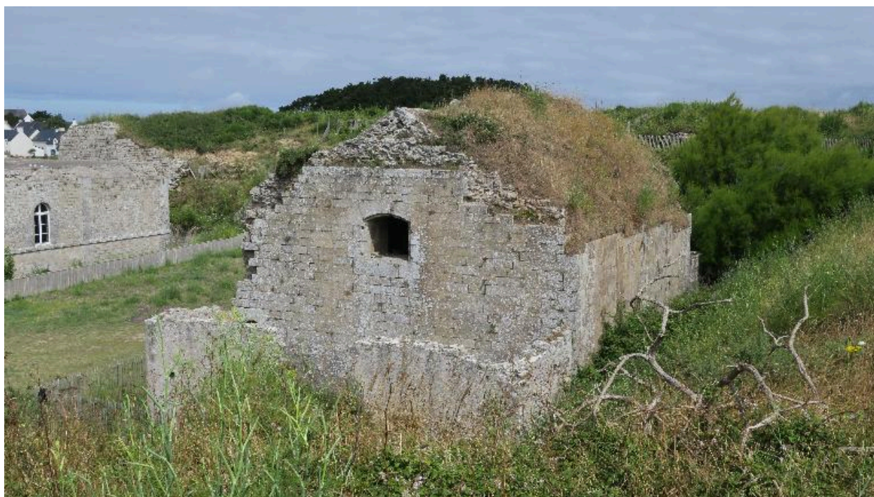
Hoedic, fort central, magasin à poudre, vue générale depuis le sud.
