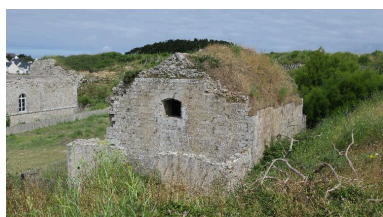
Hoedic, fort central, magasin à poudre, vue générale depuis le sud. Phot. Lionel Duigou IVR53_20175606478NUCA
