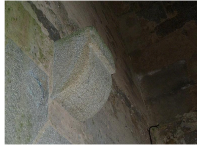
Hoedic, fort central, magasin à poudre, chambre de stockage, détail d'un corbeau du plancher de l'étage. Phot. Patrick Jadé IVR53_20175606486NUCA
