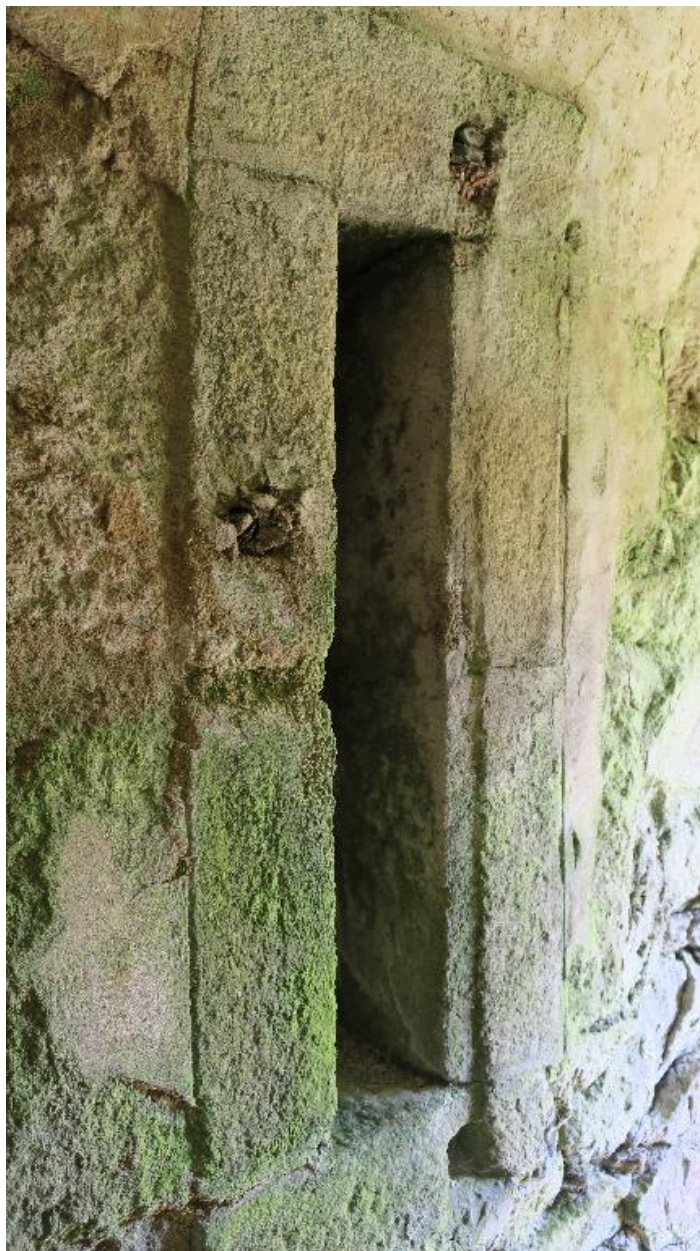
Hoedic, fort central, magasin à poudre, détail d'un évent d'aération dans une gaine latérale.
