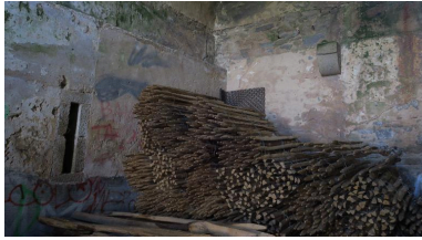
Hoedic, fort central, magasin à poudre, chambre de stockage. Phot. Lionel Duigou IVR53_20175606484NUCA
