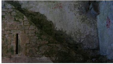
Hoedic, fort central, magasin à poudre, chambre de stockage, emplacement de l'escalier. Phot. Lionel Duigou IVR53_20175606485NUCA
