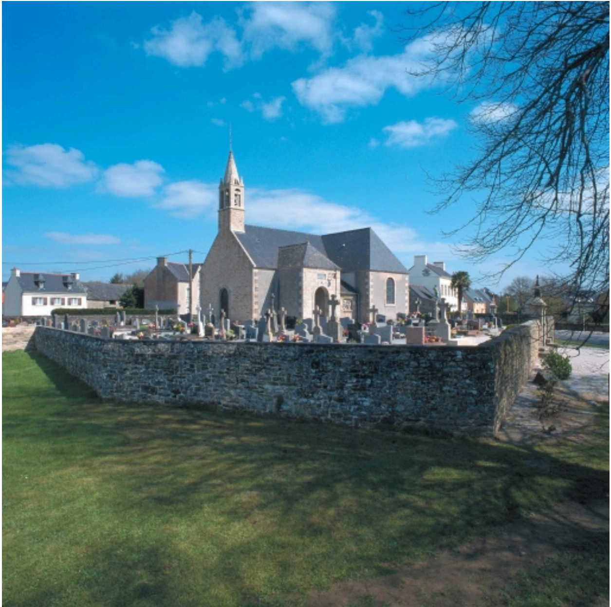
Baye, église paroissiale Saint-Pierre-aux-Liens : vue générale sud ouest, état en 2003
