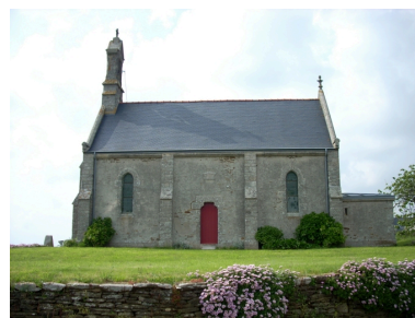
Tréguennec, chapelle Saint-Alour : élévation sud Phot. Gwénaél Fauchille IVR53_20082905916NUCA
