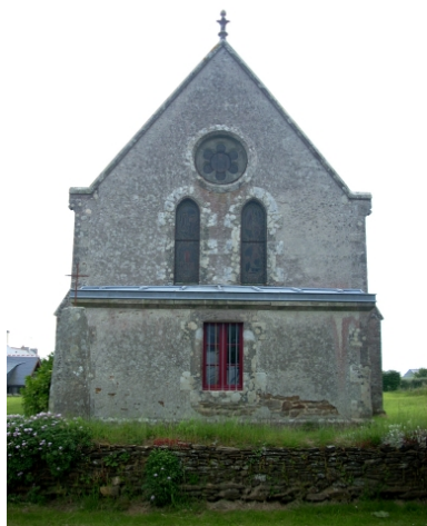
Tréguennec, chapelle Saint-Alour : élévation est Phot. Gwénaél Fauchille IVR53_20082905917NUCA
