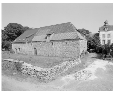
Communs est, vue nord-ouest. Phot. Guy Artur, Phot. Norbert Lambart IVR53_19945600930X
