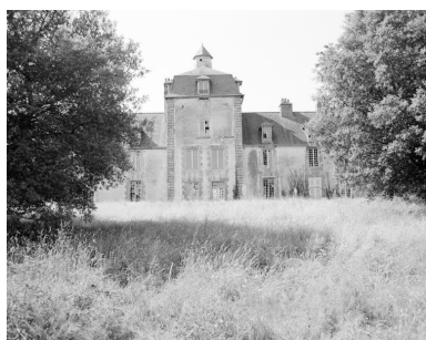
Elévation sud, partie centrale, vue prise de l'ouest. Phot. Guy Artur, Phot. Norbert Lambart IVR53_19945601019X
