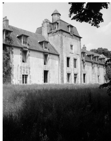
Elévation sud, partie centrale, vue prise de l'ouest. Phot. Guy Artur, Phot. Norbert Lambart IVR53_19925600937X
