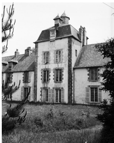
Elévation nord, pavillon central, vue prise de l'ouest. Phot. Guy Artur, Phot. Norbert Lambart IVR53_19925600935X
