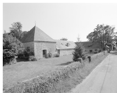
Communs ouest, vue nord-est. Phot. Guy Artur, Phot. Norbert Lambart IVR53_19945600931X
