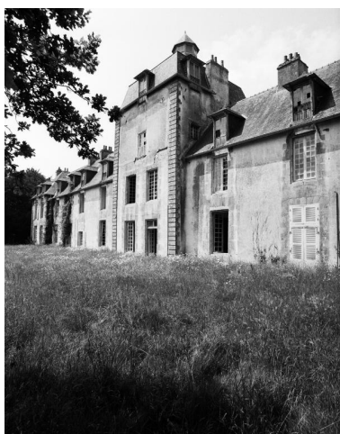
Elévation sud, partie centrale, vue prise de l'est. Phot. Guy Artur, Phot. Norbert Lambart IVR53_19925600938X
