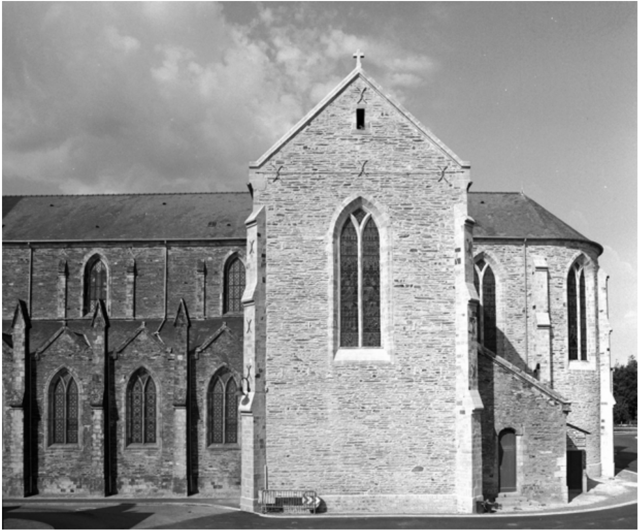
Le transept, croisillon droit : vue générale est
