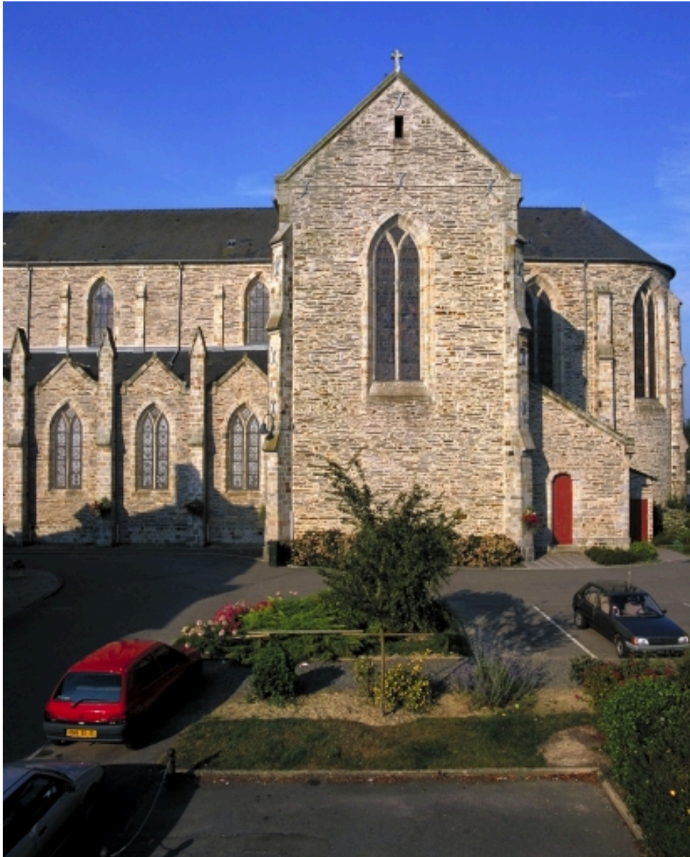
Le transept, croisillon droit : vue générale est
