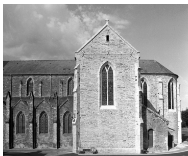
Le transept, croisillon droit : vue générale est Phot. Guy Artur, Phot. Norbert Lambart IVR53_19943501762X
