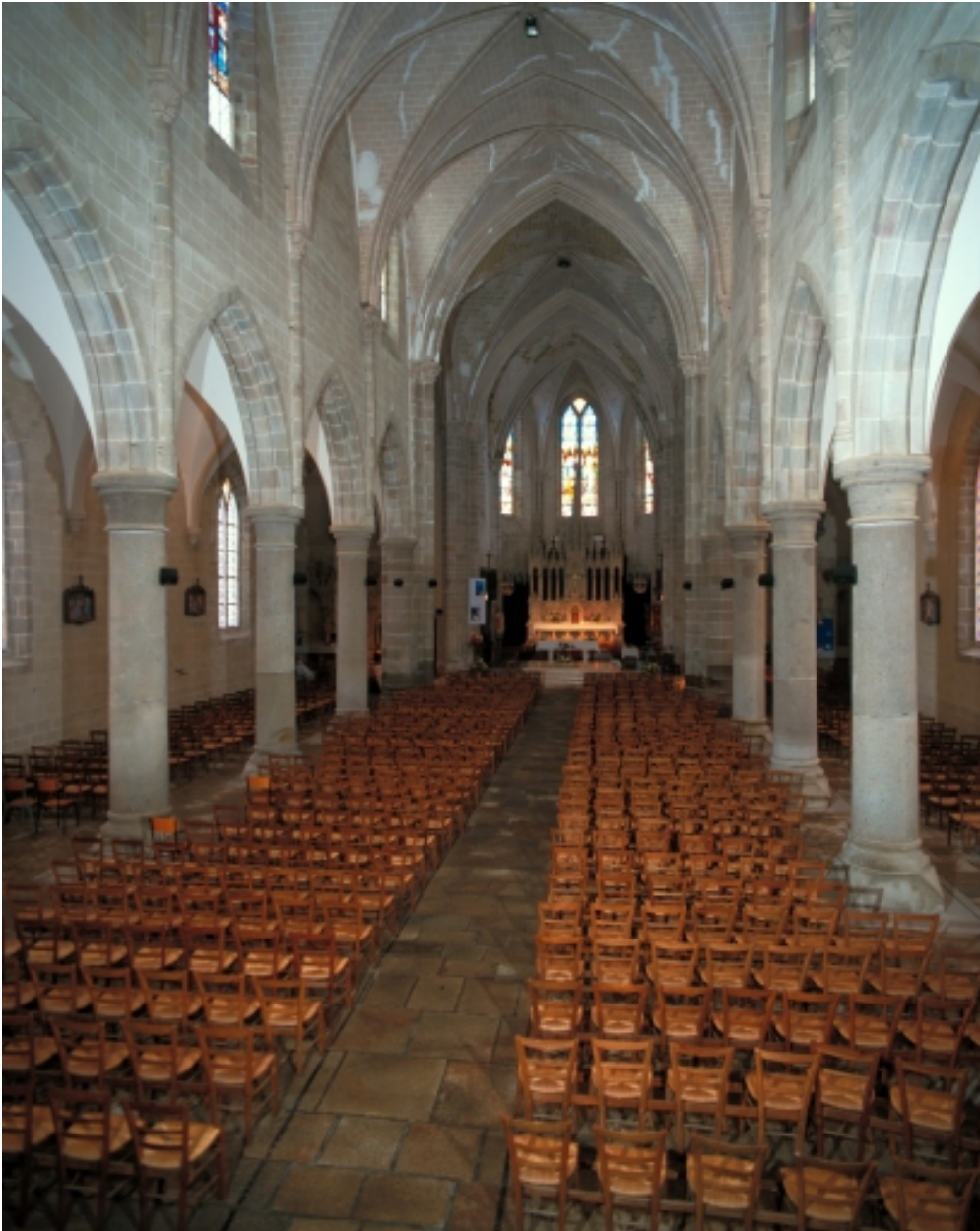
Vue intérieure prise du chœur vers la nef
