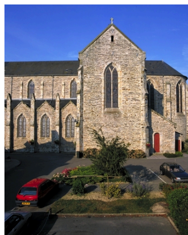
Le transept, croisillon droit : vue générale est Phot. Guy Artur, Phot. Norbert Lambart IVR53_20003502543XA
