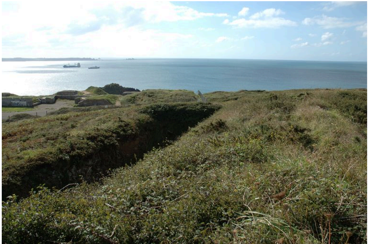
Vue de la batterie depuis le réduit de Toulbroc'h (état en 2007)
