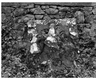
Vestiges de la chapelle, détail d'une pierre armoriée Phot. Guy Artur, Phot. Norbert Lambart IVR53_19842900939X
