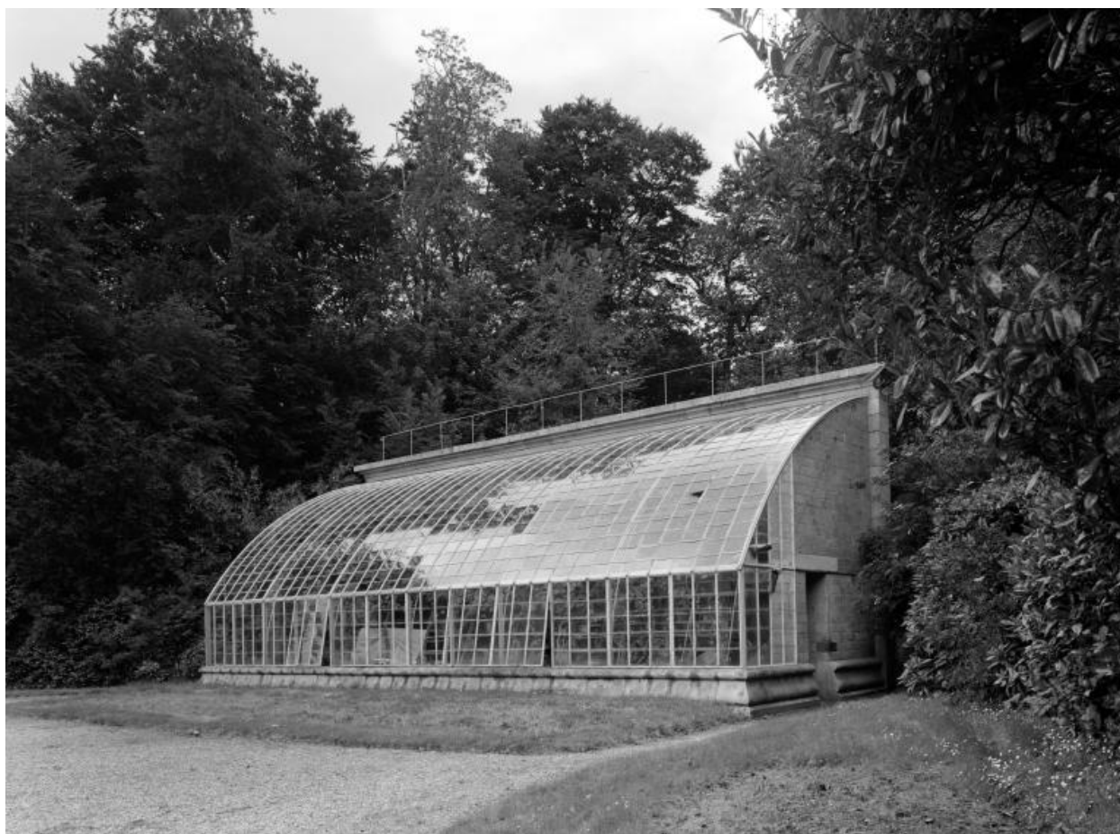
Serre, élévation sud, vue générale
