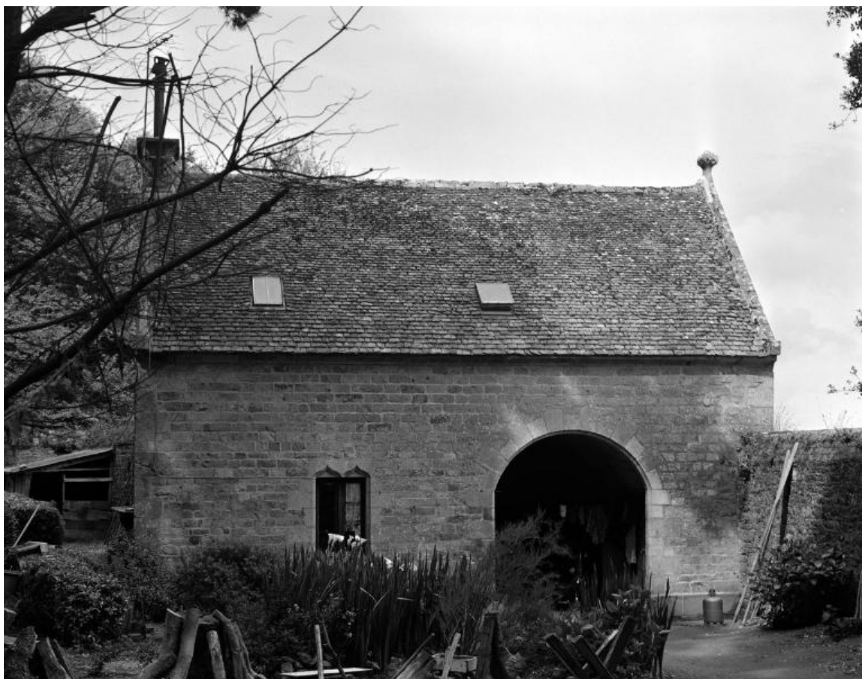
Maison de garde, élévation sud, vue générale
