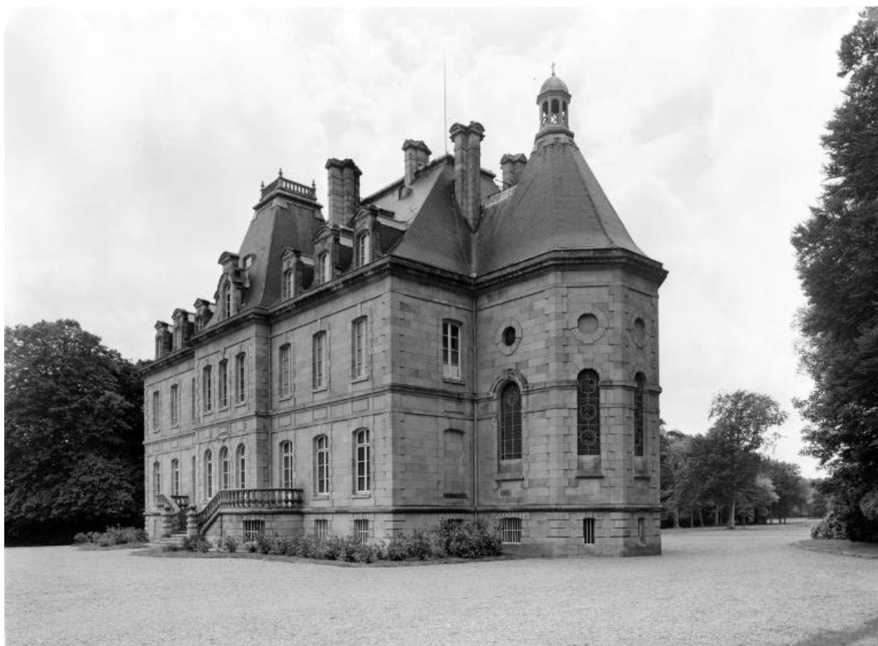
Logis et chapelle domestique, élévation est et nord, vue générale
