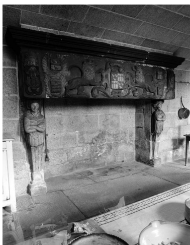
Intérieur, cuisine, cheminée 1627 au sous-sol, vue générale de trois-quarts Phot. Guy Artur, Phot. Norbert Lambart IVR53_19862900484X
