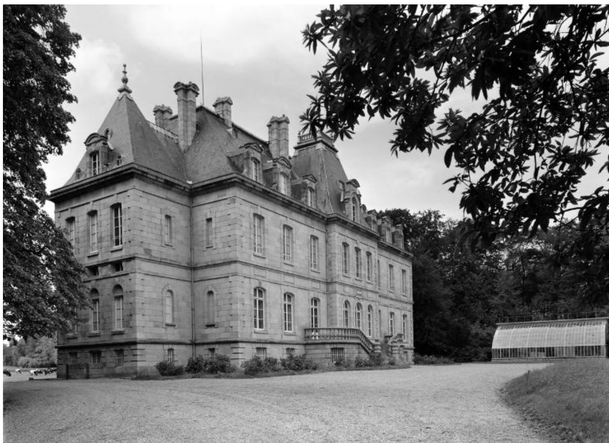
Logis, élévation sud-est et serre, vue générale
