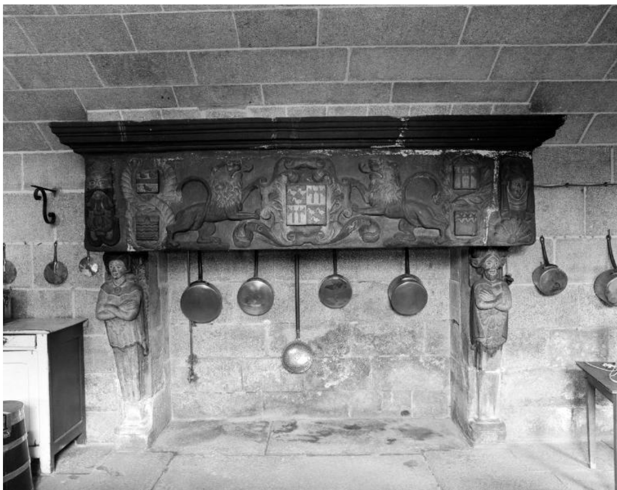
Intérieur, cuisine, cheminée 1627 au sous-sol, vue générale de face
