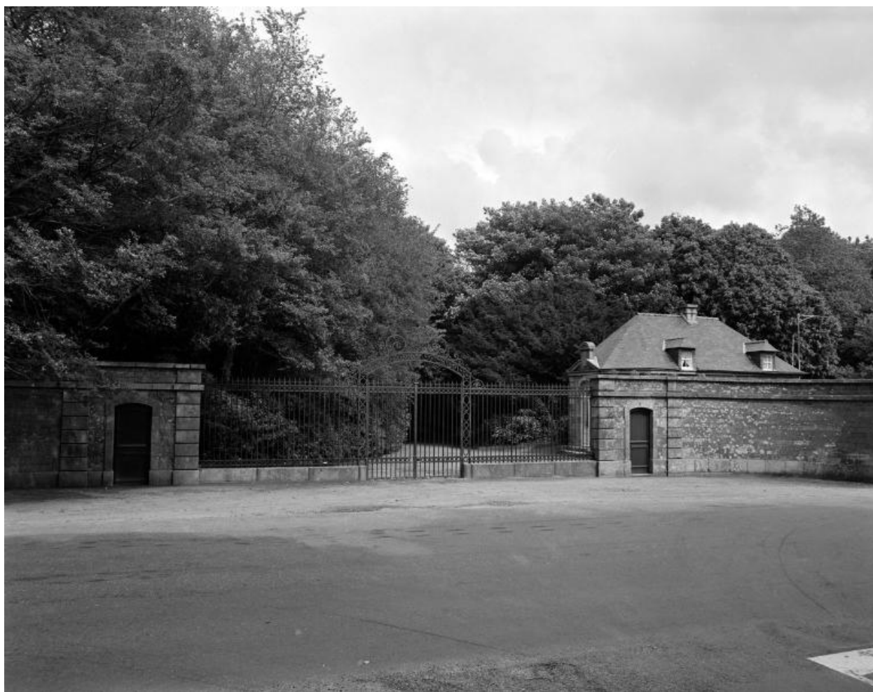
Entrée ouest, vue générale du portail et maison de garde
