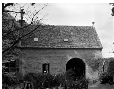
Maison de garde, élévation sud, vue générale Phot. Guy Artur, Phot. Norbert Lambart IVR53_19842900926X
