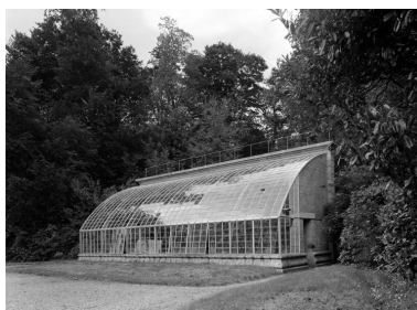
Serre, élévation sud, vue générale Phot. Guy Artur, Phot. Norbert Lambart IVR53_19842900932V
