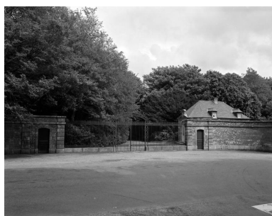
Entrée ouest, vue générale du portail et maison de garde Phot. Guy Artur, Phot. Norbert Lambart IVR53_19842900928X
