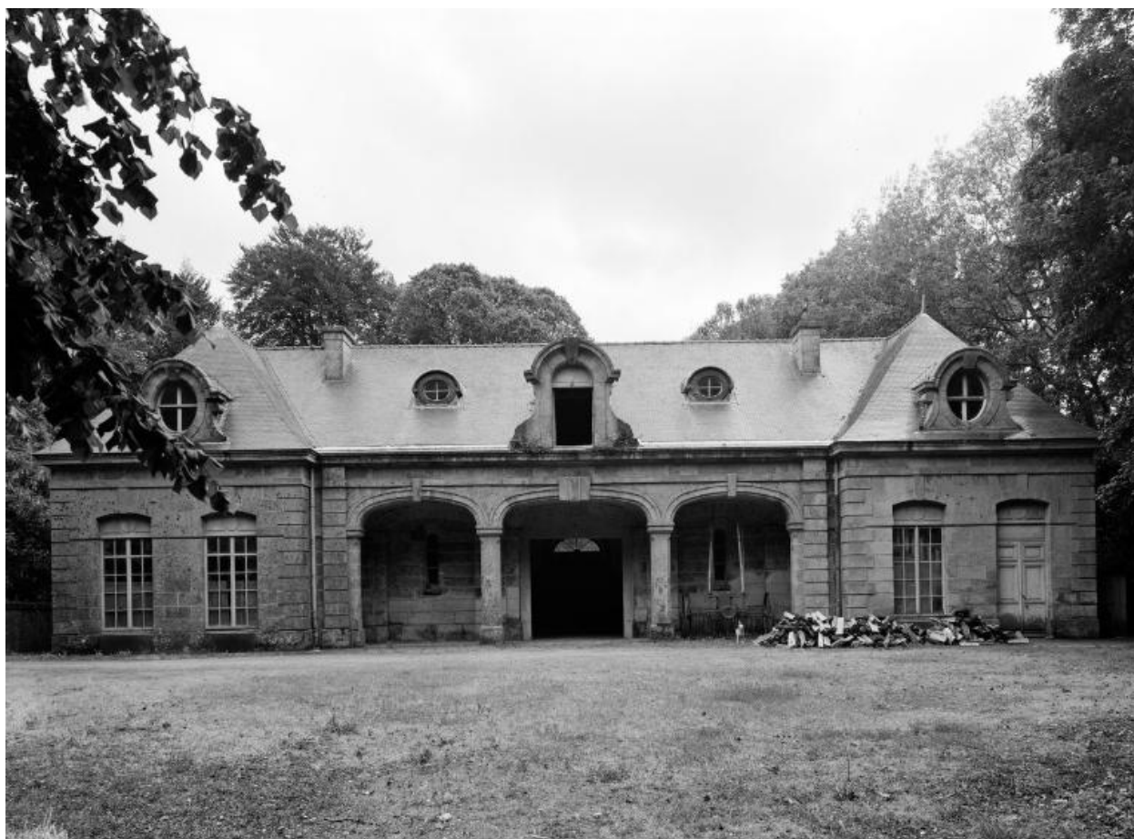
Ecuries, élévation Nord, vue générale
