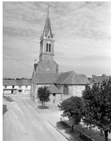
Elévation est : vue générale Phot. Guy Artur, Phot. Norbert Lambart IVR53_19943501398X
