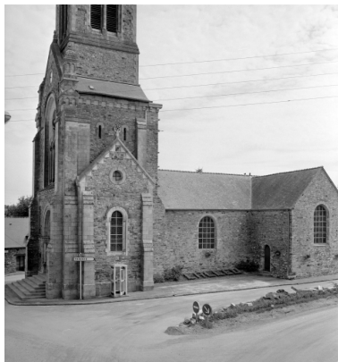
Elévation sud-ouest : vue générale Phot. Guy Artur, Phot. Norbert Lambart IVR53_19943501397X
