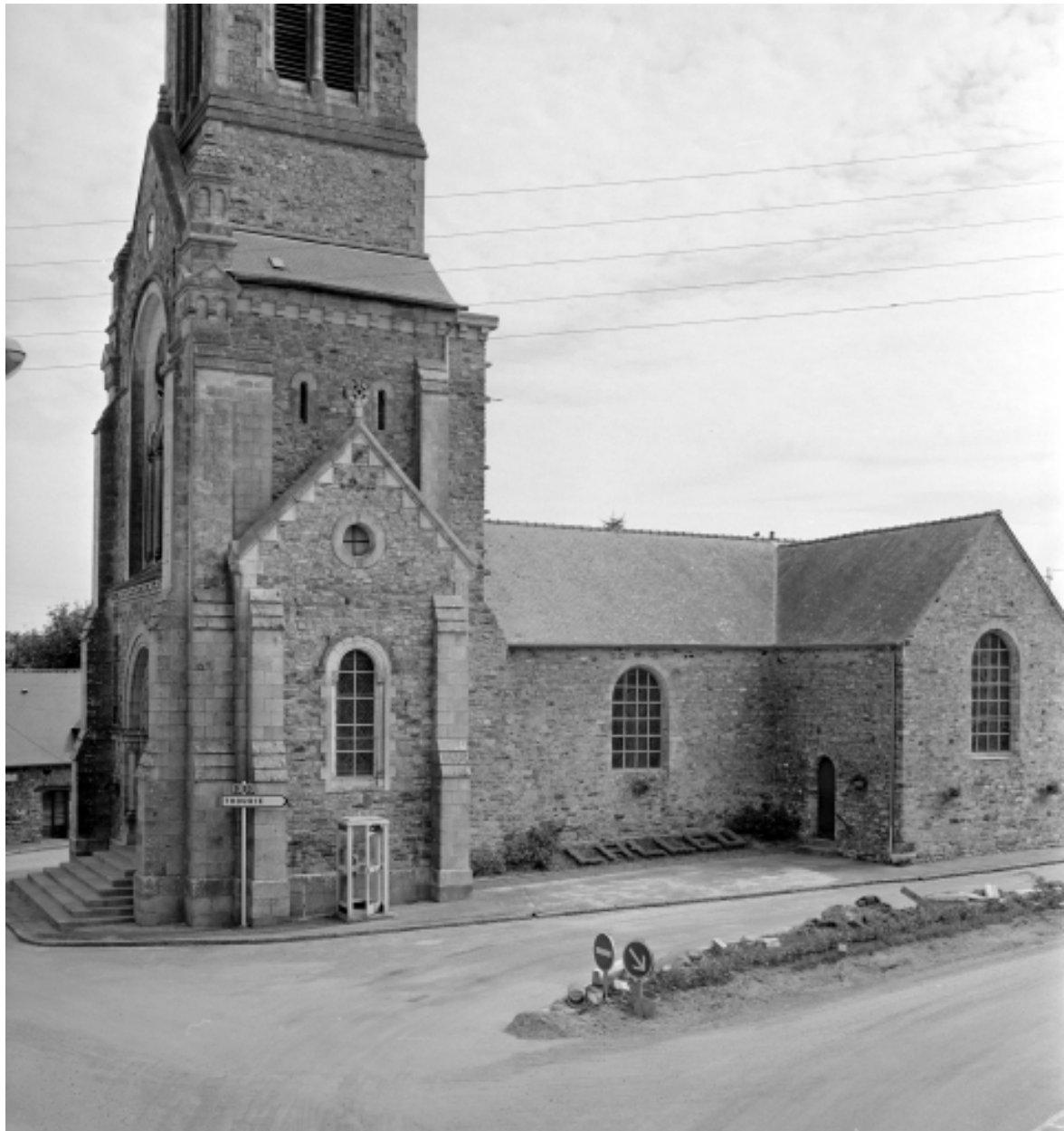
Elévation sud-ouest : vue générale
