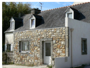
Quartier de pêcheurs à Morgat Phot. Julien Amghar IVR53_20072908619NUCA
