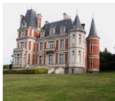
Vue générale (élévation sud) Phot. Patrick Pichouron IVR53_20072209961NUCA
