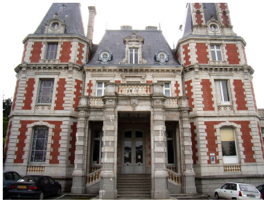
Vue générale (élévation antérieure) Phot. Patrick Pichouron IVR53_20072210076NUCA
