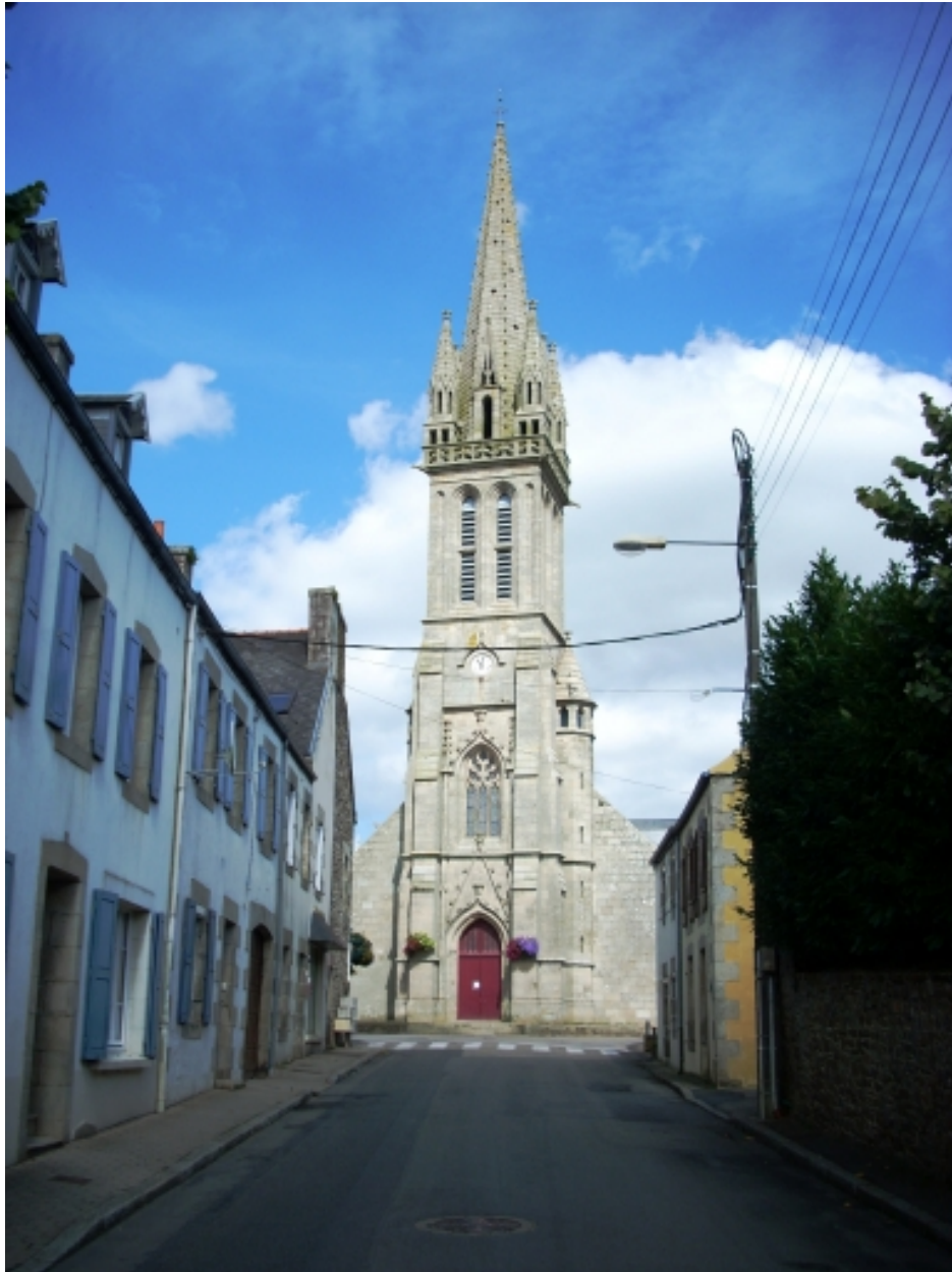
Plouigneau, église paroissiale Saint-Ignace : vue générale ouest
