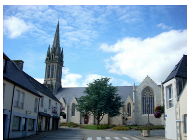
Plouigneau, église paroissiale Saint-Ignace : vue générale sud Phot. Gwénaél Fauchille IVR53_20082906637NUCA
