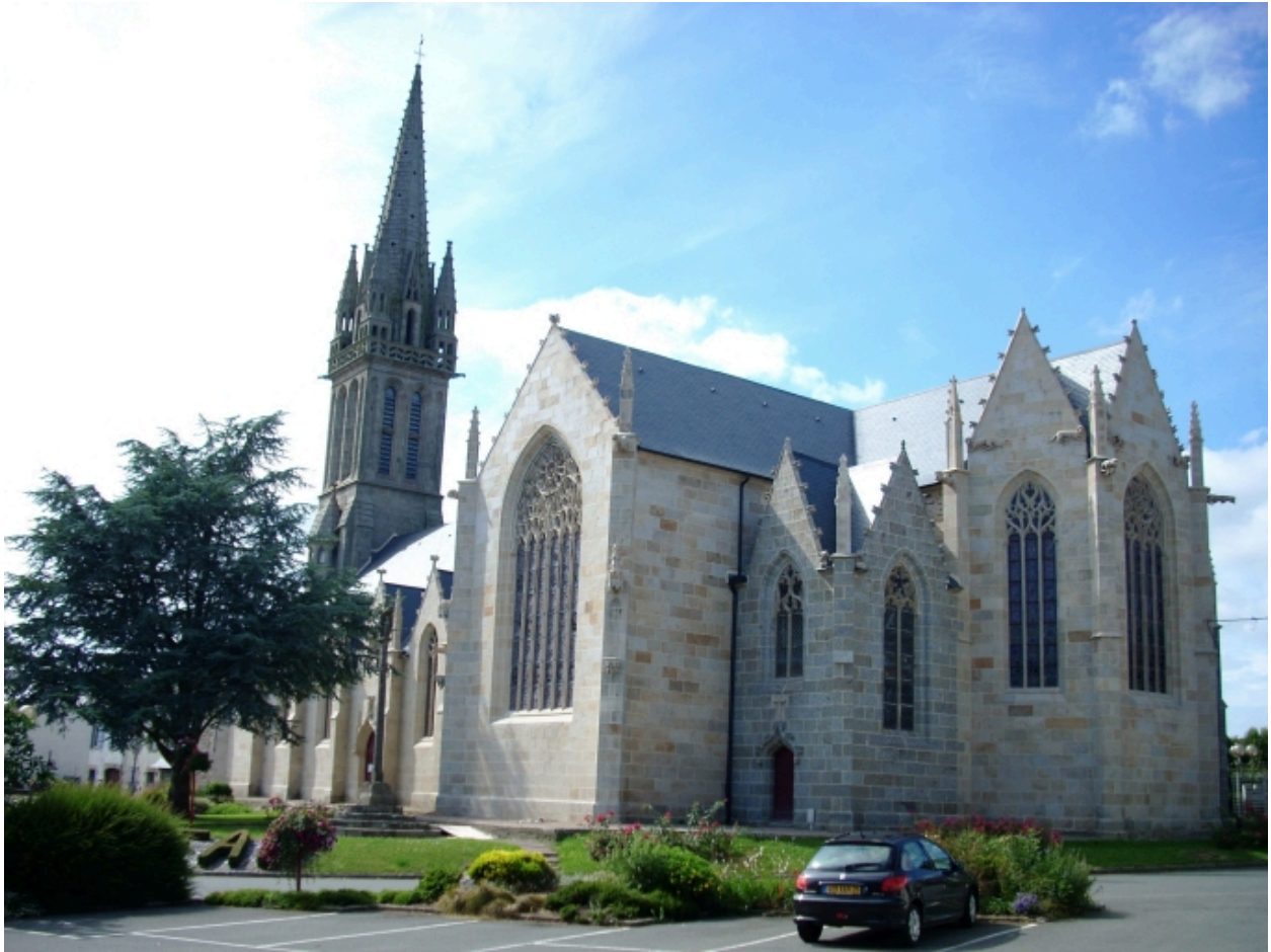
Plouigneau, église paroissiale Saint-Ignace : vue générale sud-est
