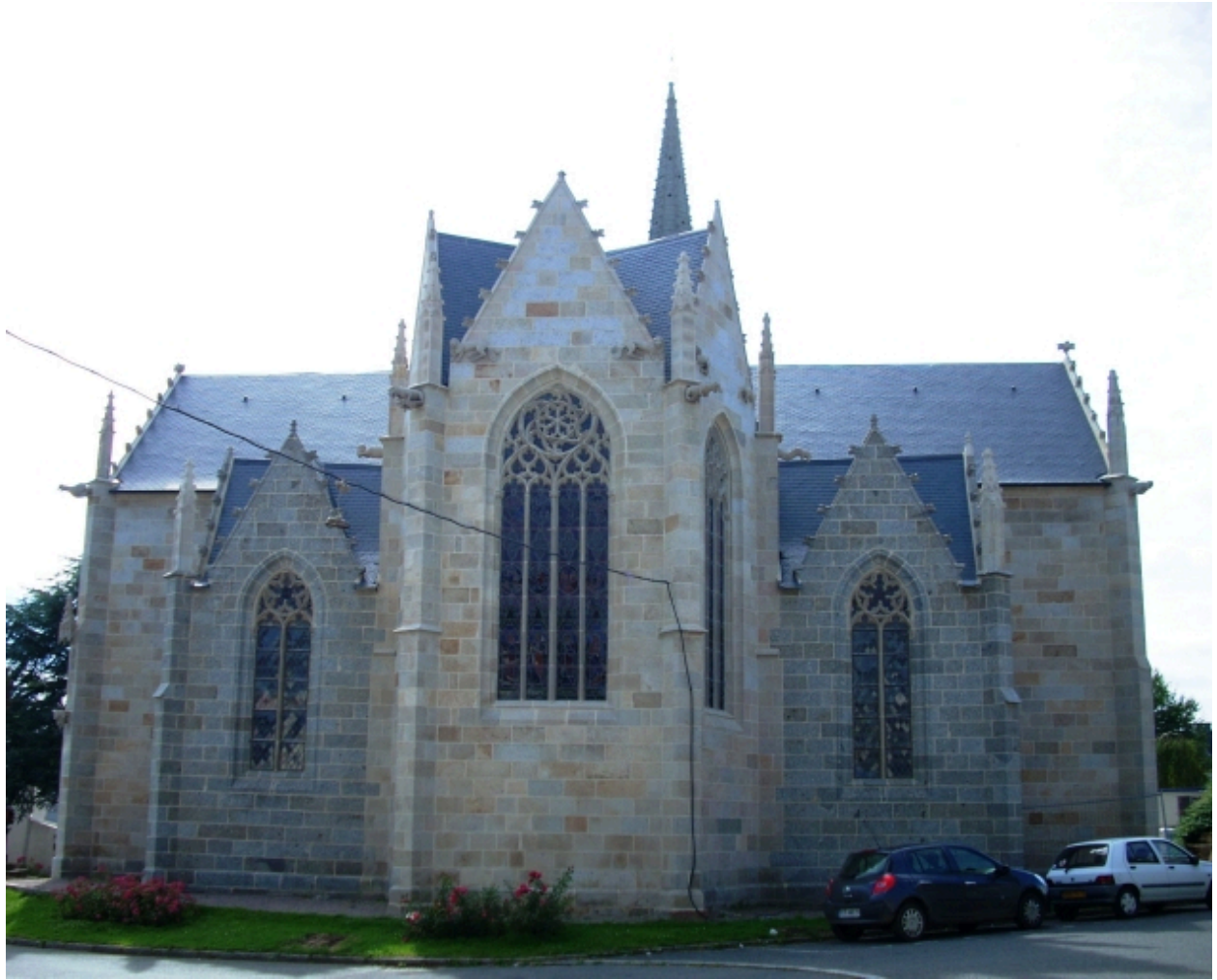
Plouigneau, église paroissiale Saint-Ignace : vue générale est
