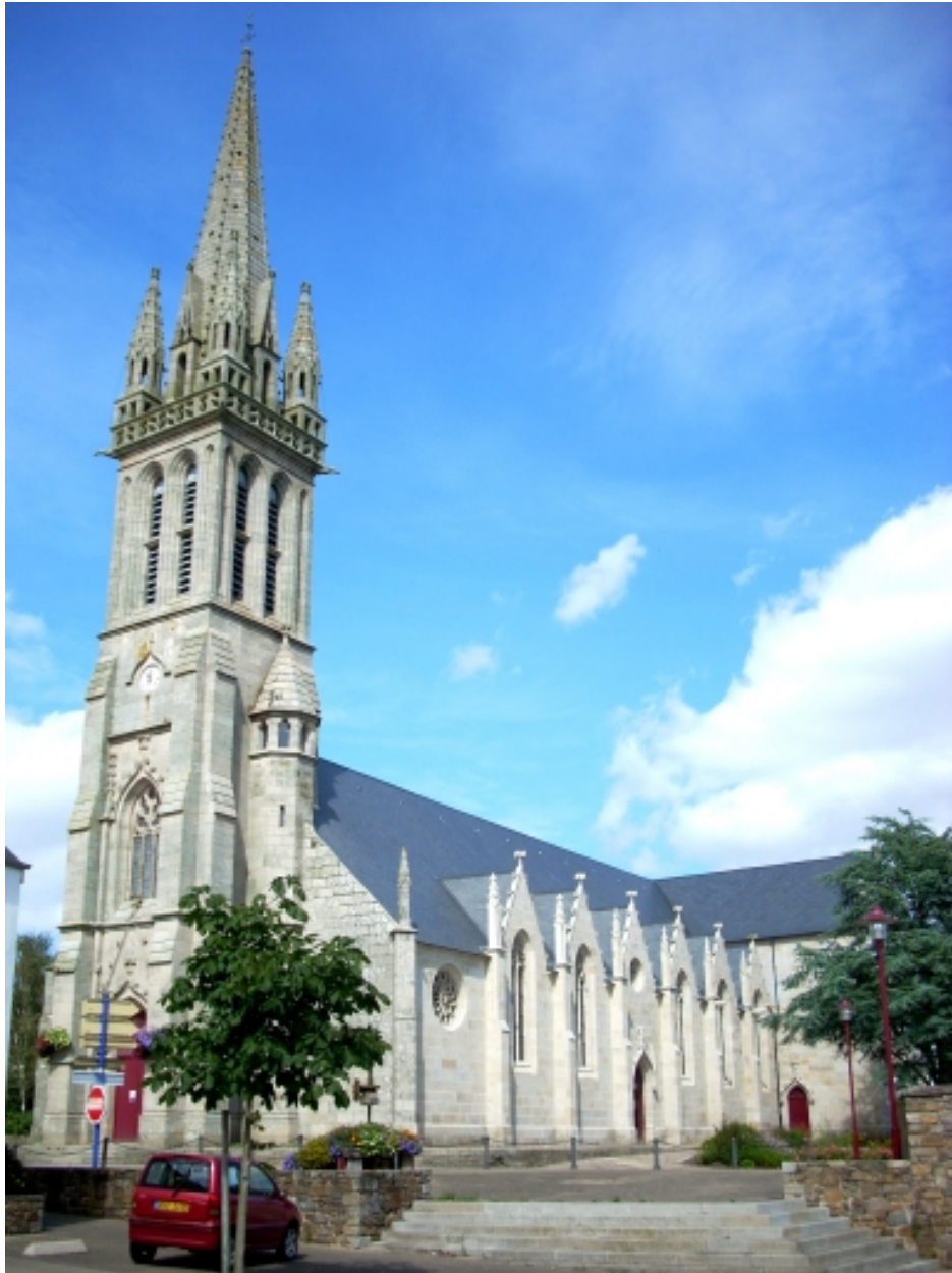
Plouigneau, église paroissiale Saint-Ignace : vue générale sud-ouest
