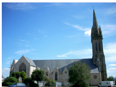
Plouigneau, église paroissiale Saint-Ignace : élévation nord Phot. Gwénaél Fauchille IVR53_20082906634NUCA
