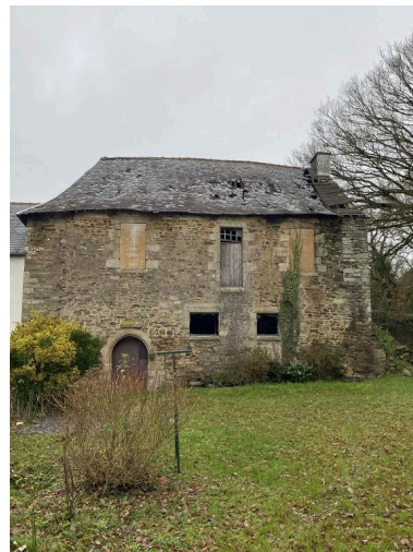
Élévation sud, vue générale Phot. Baptiste Oligo IVR53_20265610672NUCA
