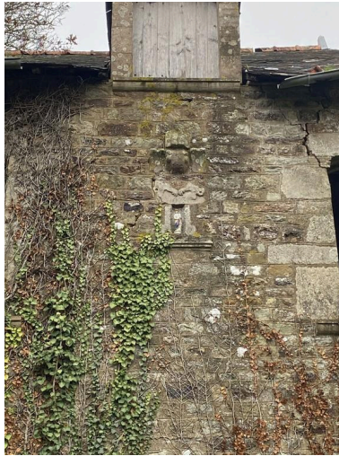
Niche, élévation ouest, détail Phot. Baptiste Oligo IVR53_20265610676NUCA
