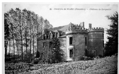
Vue générale Phot. Elise Lauranceau IVR53_20042905548NUCB
