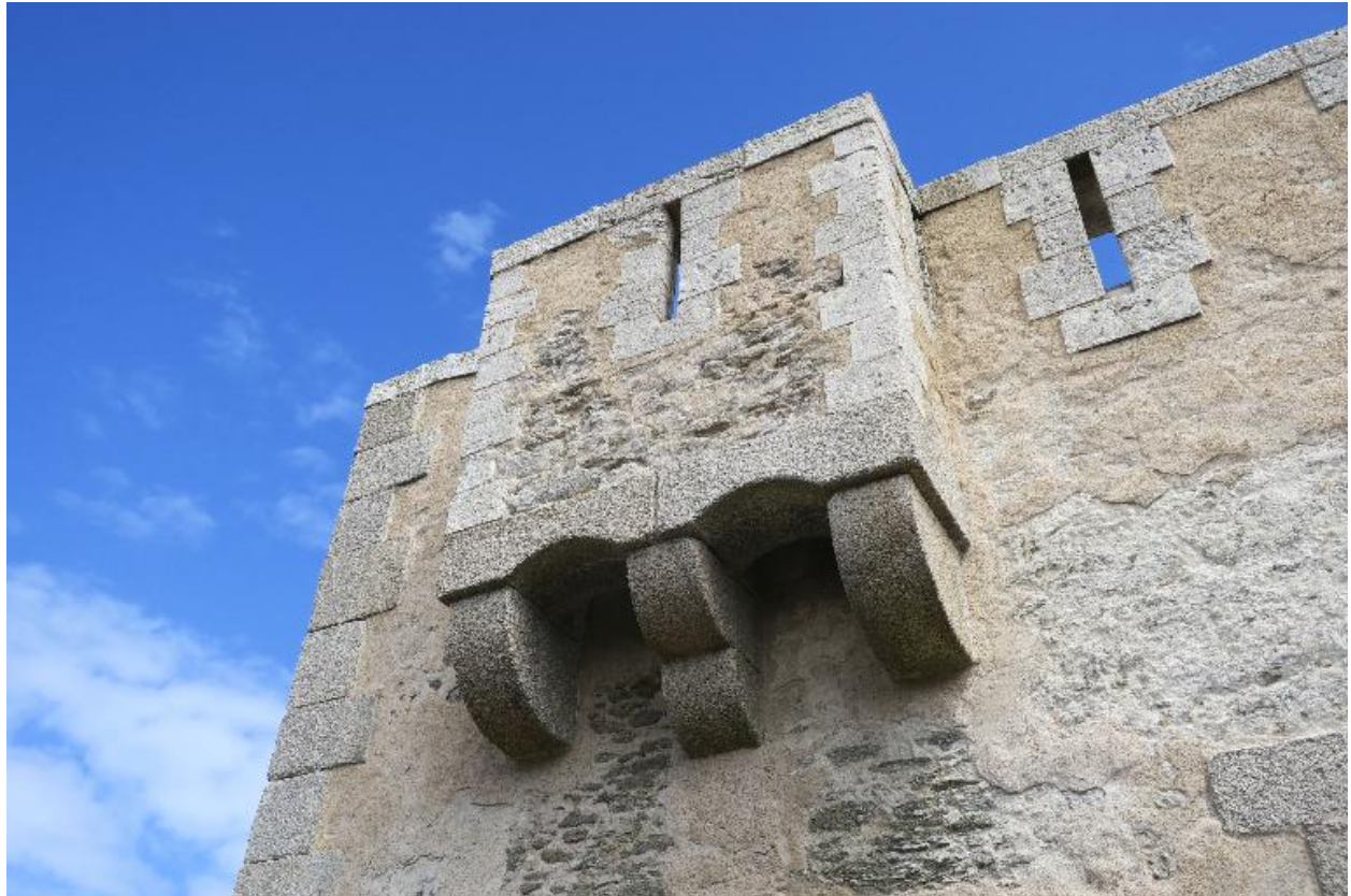
Sauzon, poste garde-côtes de la pointe des Poulains, corps de garde crénelé dit Fort Sarah Bernhardt, bretèche.
