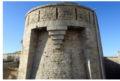
Saint-Pierre-Quiberon, fort de Penhièvre, créneaux de tir et mâchicoulis. Phot. Lionel Duigou IVR53_20175606653NUCA
