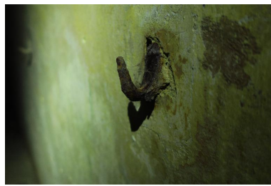
Locmaria, batterie de La Ferrière, corps de garde crénelé, crochet de hamac. Phot. Patrick Jadé IVR53_20175607287NUCA
