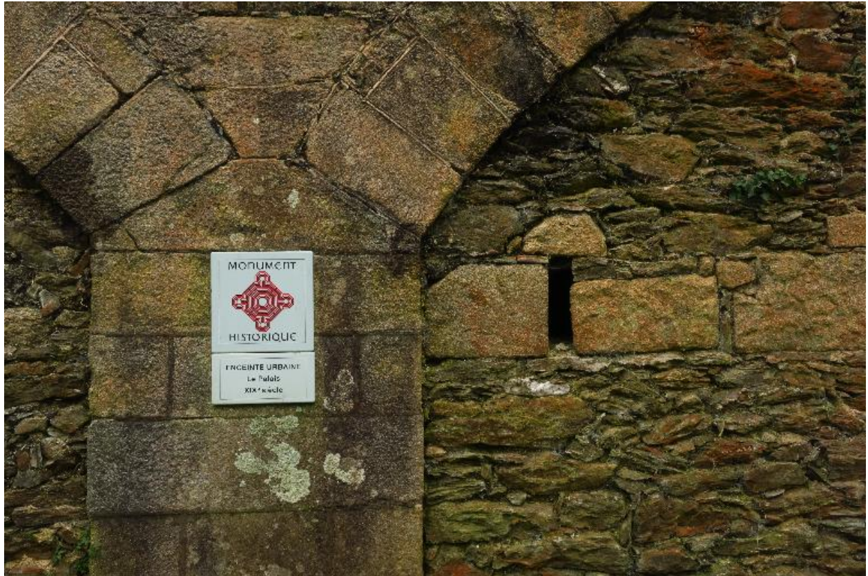
Le Palais, enceinte urbaine, galerie de contrescarpe, signalétique Monuments Historiques.
