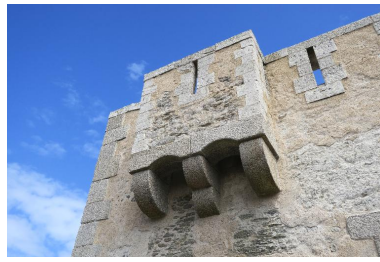
Sauzon, poste garde-côtes de la pointe des Poulains, corps de garde crénelé dit Fort Sarah Bernhardt, bretèche. Phot. Patrick Jadé IVR53_20175607989NUCA
