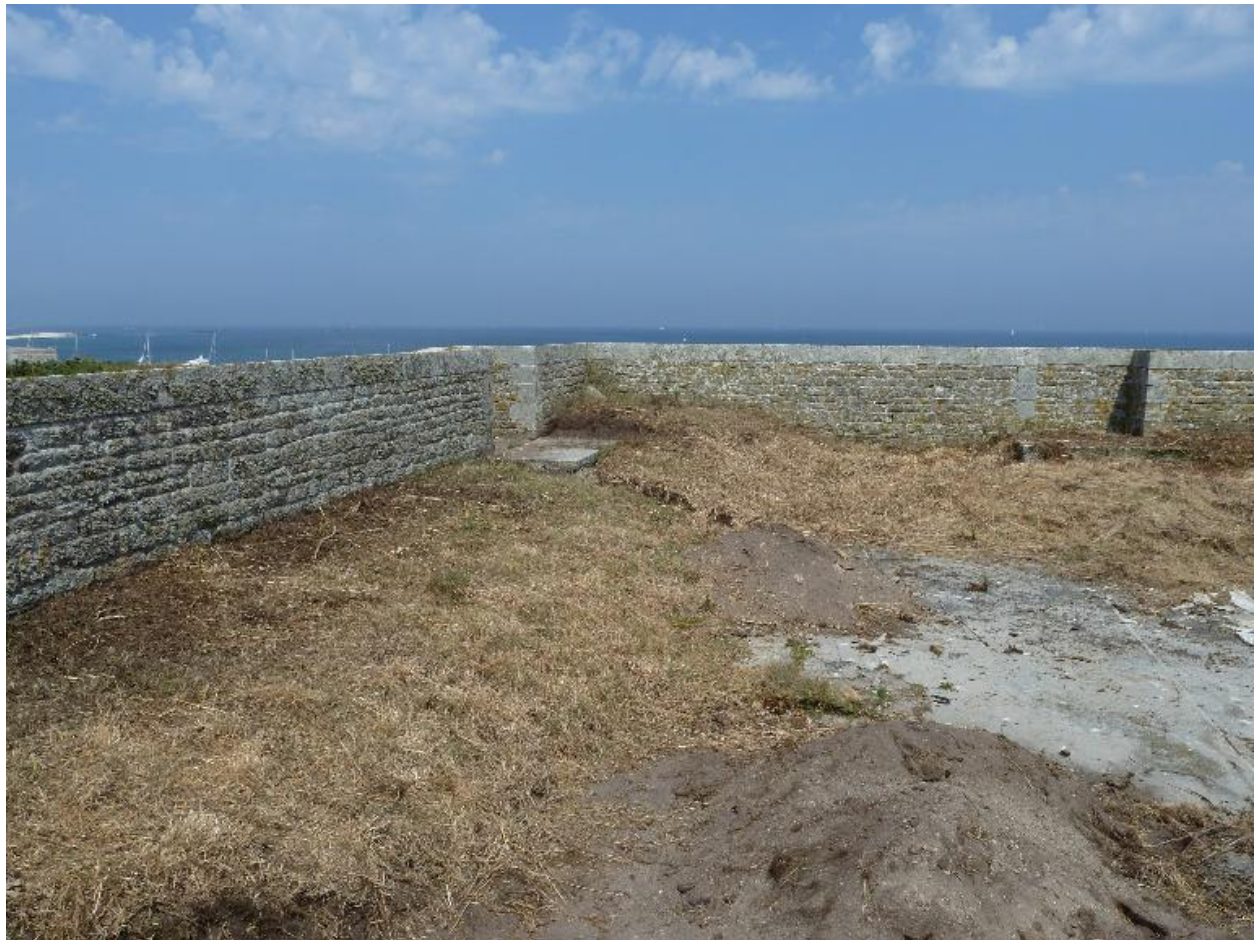
Archipel des Glénan, batterie de Penfret, corps de garde crénelé, banquettes en terre du parapet avant leur destruction.
