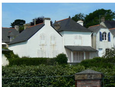
Vue générale de la villa Ker Skrill, côté mer Phot. Johan Vincent IVR53_20072908681NUCA
