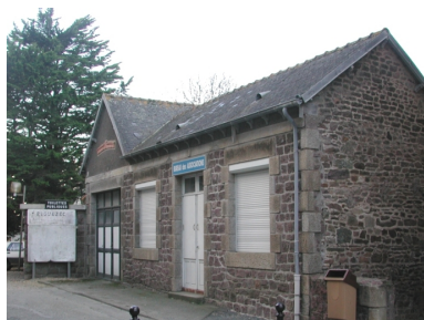
Vue générale actuelle (maison des associations) Phot. Guy Prigent IVR53_20022215770NUCA
