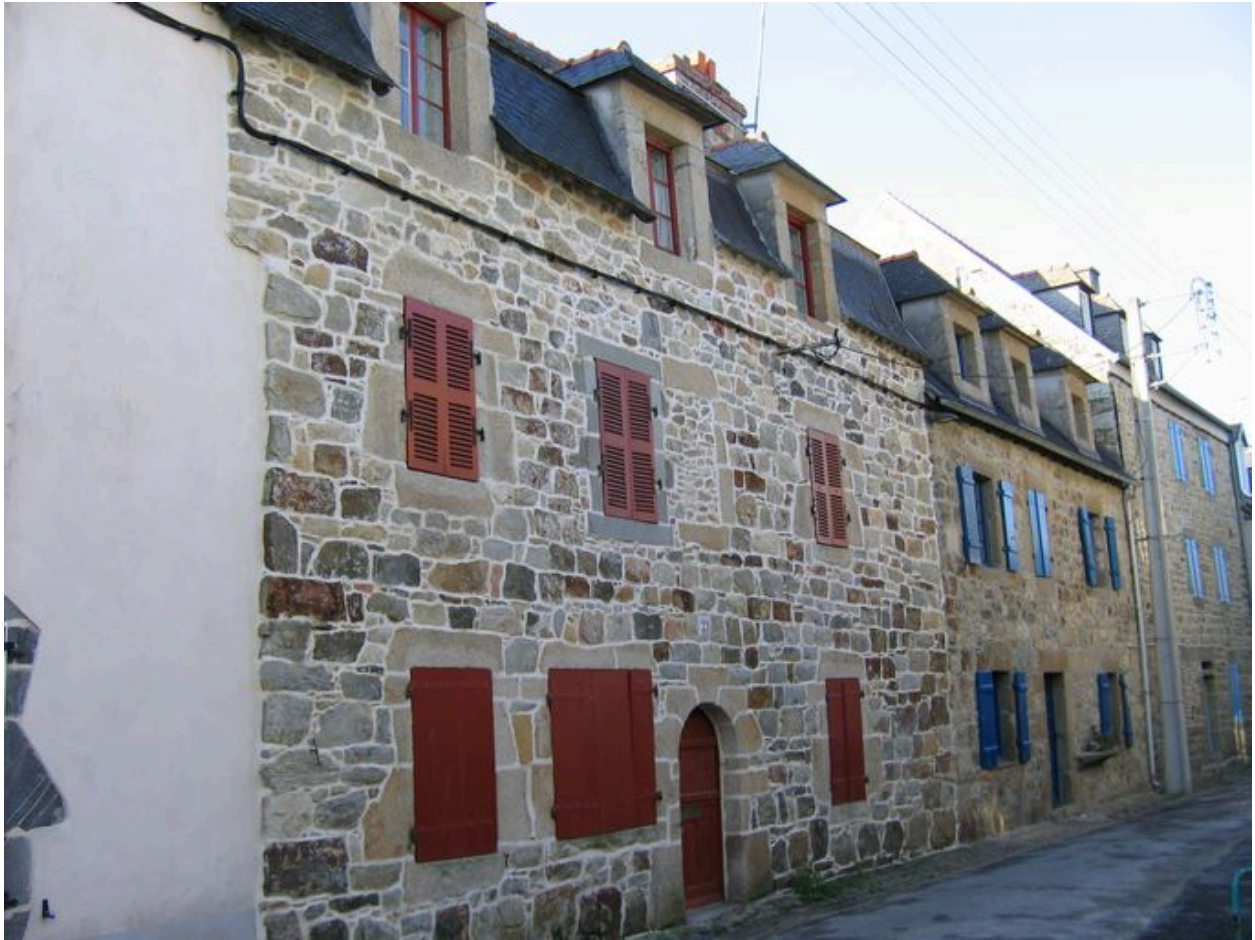
33 rue de Reims
