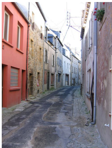
Vue de la rue de Reims Phot. Guillaume Marie IVR53_20062908297NUCA
