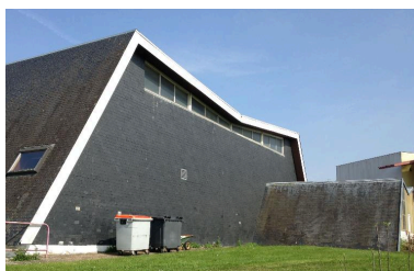
Façade est et extension du gymnase Phot. Simon Vely IVR53_20165605310NUCA
