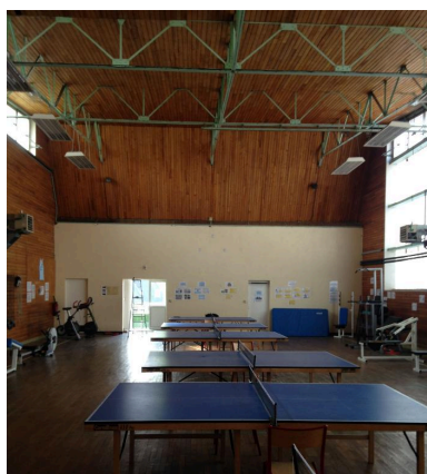
Vue intérieure Phot. Simon Vely IVR53_20165605312NUCA
