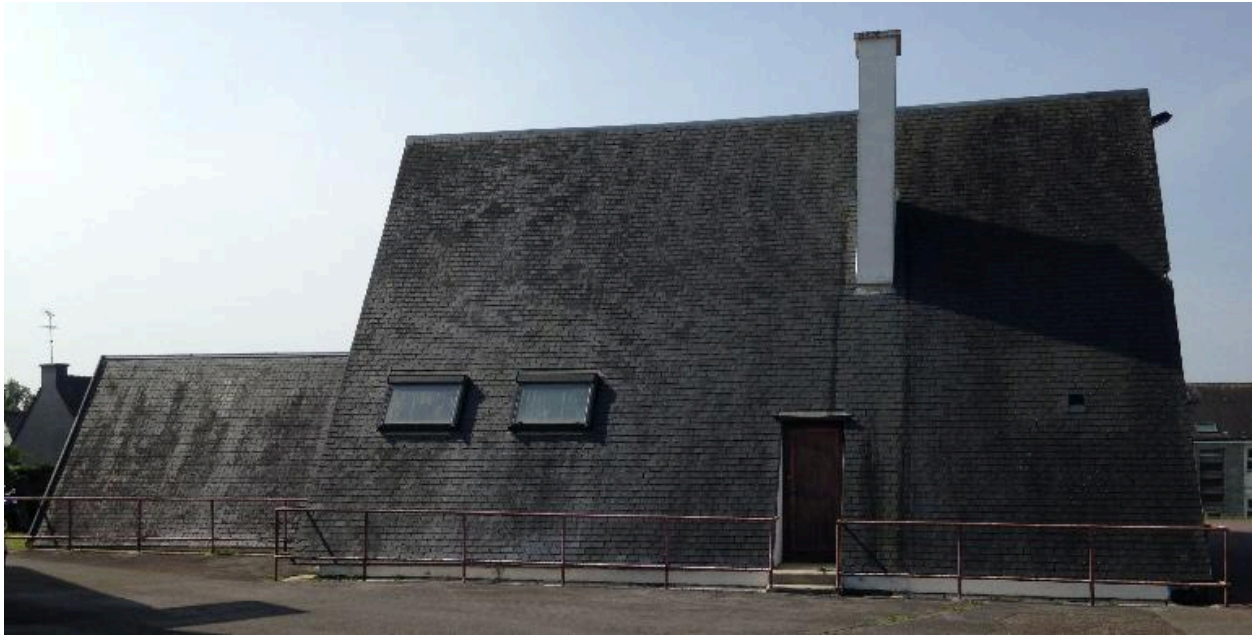
Façade nord et extension du gymnase
