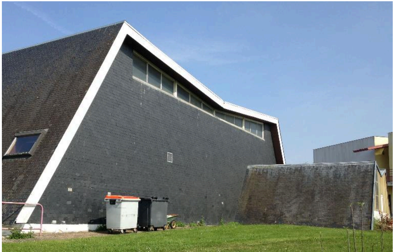
Façade est et extension du gymnase
