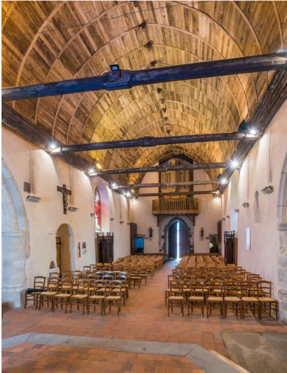
Vue de la nef et de sa voûte lambrissée en chêne en plein cintre
