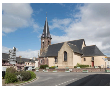
Vue générale de l'église Phot. Charlotte Barraud IVR53_20173500149NUCA
