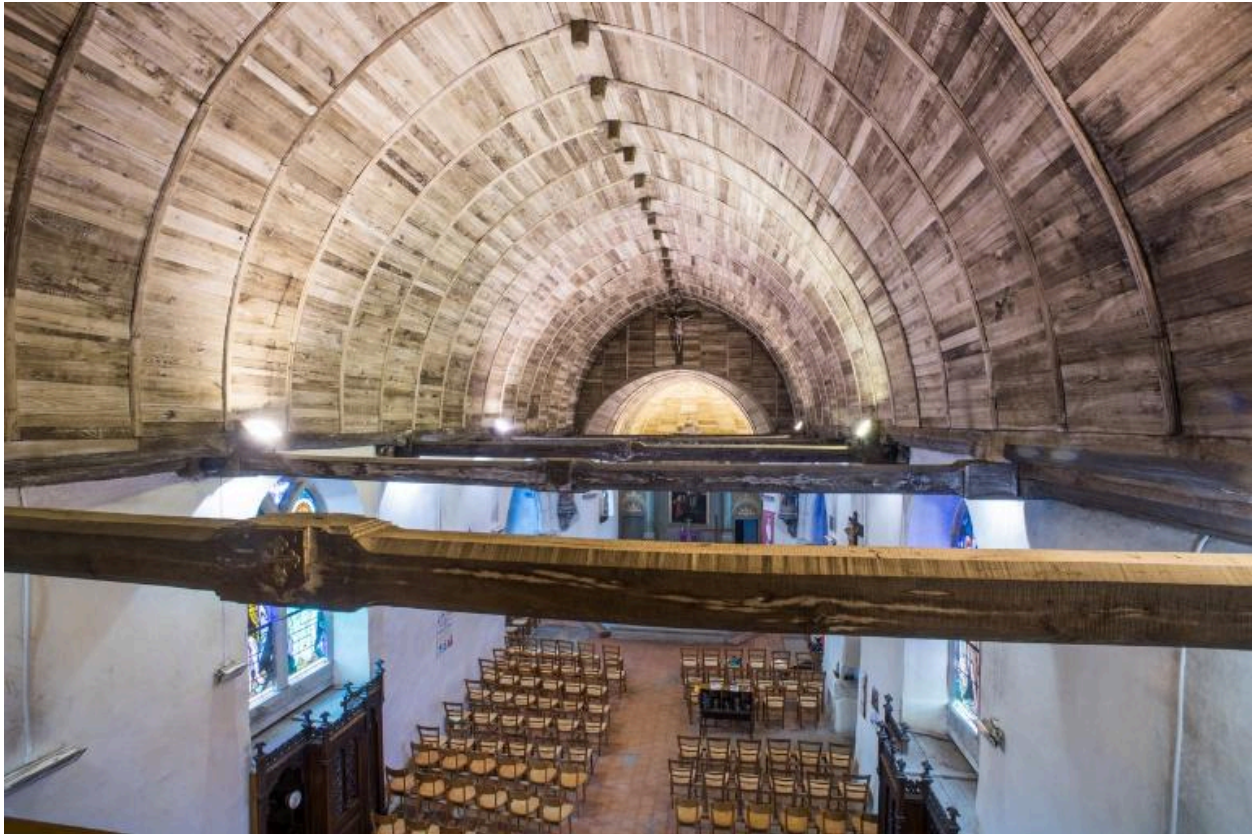
Vue de la voûte lambrissée en chêne en plein cintre depuis l'orgue (vue depuis l'Ouest)
