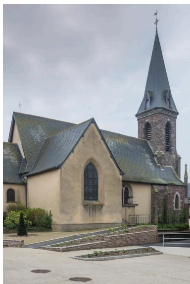
Vue générale de la façade Nord Phot. Charlotte Barraud IVR53_20173500159NUCA
