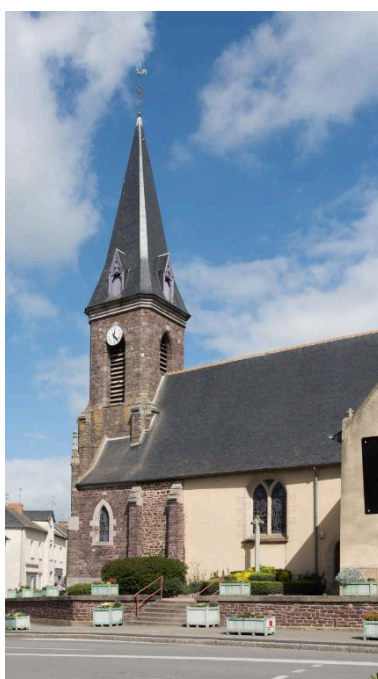
Élévation Sud, vue générale Phot. Charlotte Barraud IVR53_20173500150NUCA
