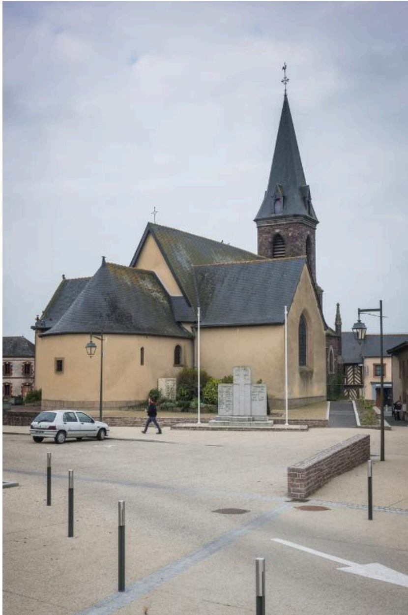
Vue générale de la façade Est
