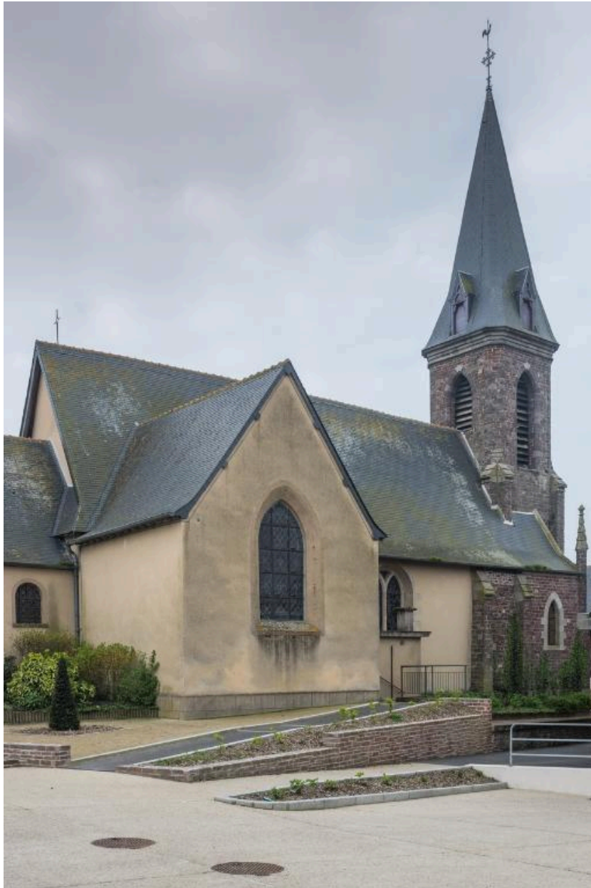
Vue générale de la façade Nord
