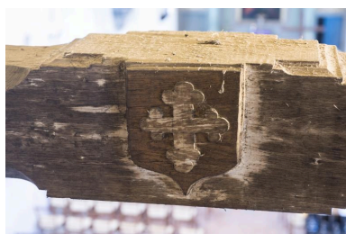
Blason présent sur un entrail Phot. Charlotte Barraud IVR53_20173500120NUCA
