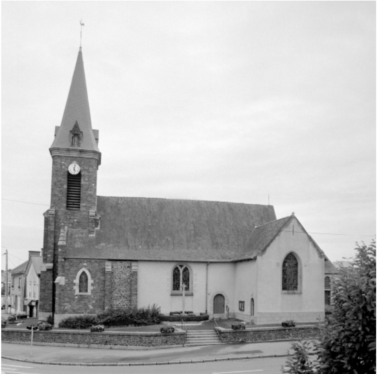
Elévation Sud : vue générale
