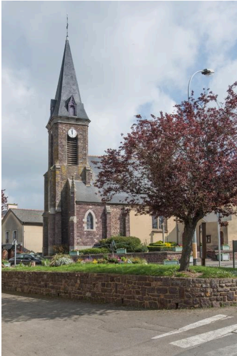
Vue du clocher-porche et de la façade Sud depuis la "commanderie"
