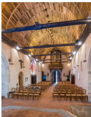
Vue de la nef et de sa voûte lambrissée en chêne en plein cintre Phot. Charlotte Barraud IVR53_20173500105NUCA
