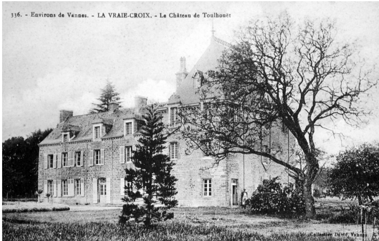
Vue générale de trois quart
