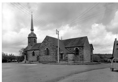
Elévation nord-est : vue générale Phot. Guy Artur IVR53_19683500462V
