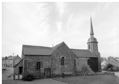
Elévation Nord : vue générale Phot. Guy Artur, Phot. Norbert Lambart IVR53_19943500828X
