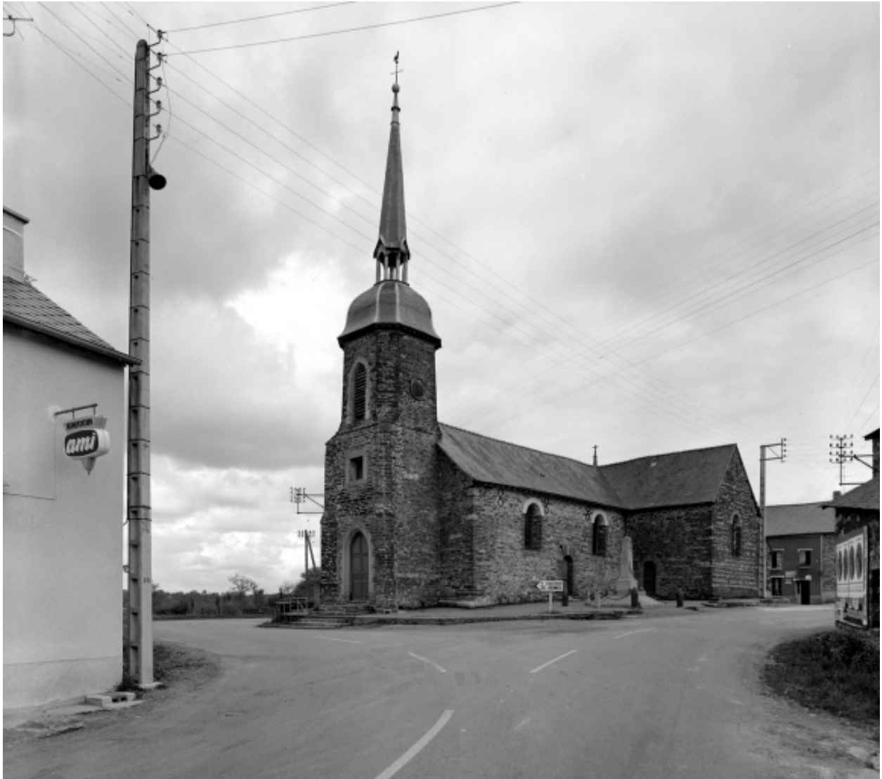
Elévation sud-ouest : vue générale
