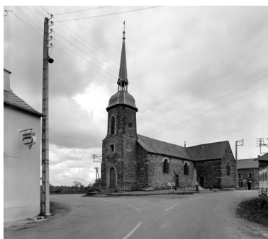
Elévation sud-ouest : vue générale Phot. Guy Artur, Phot. Norbert Lambart IVR53_19683500463V
