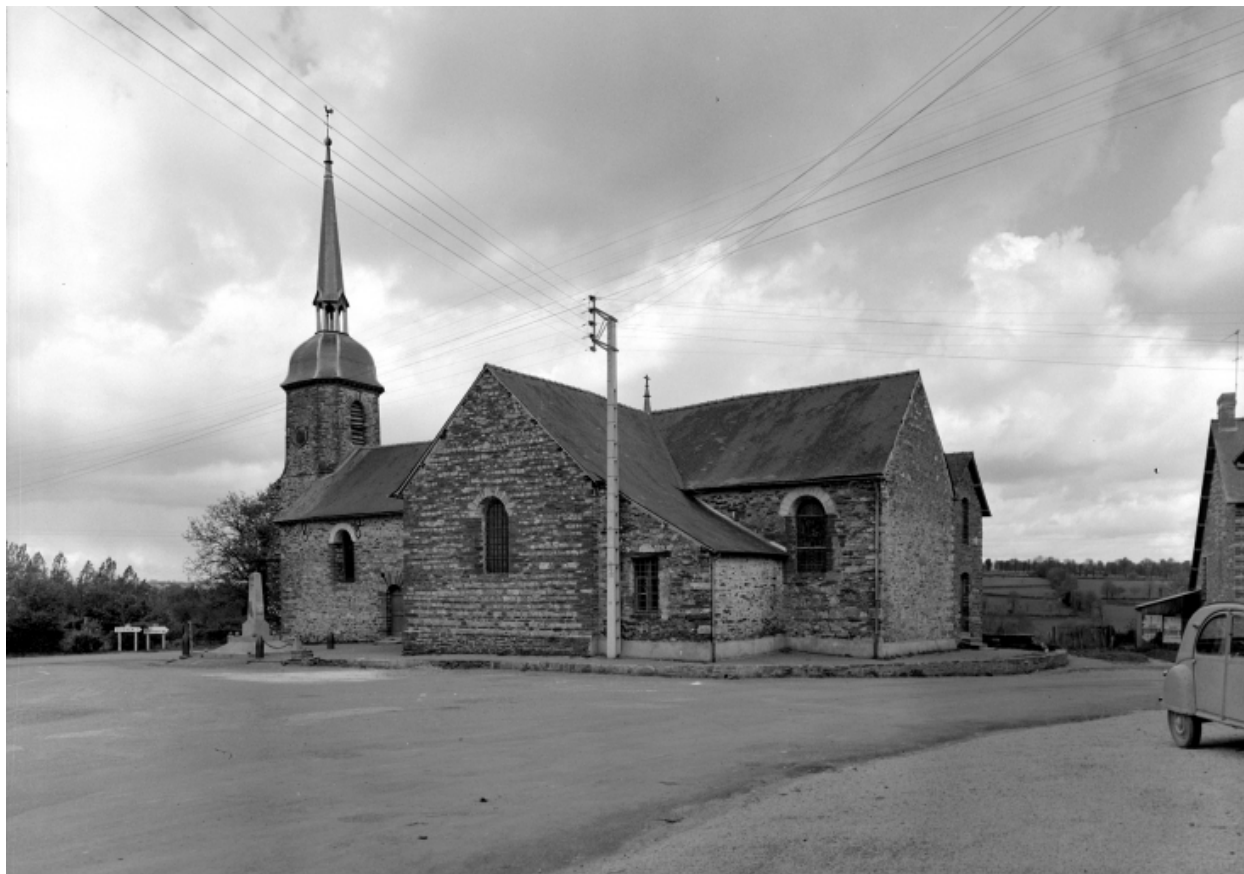
Elévation nord-est : vue générale
