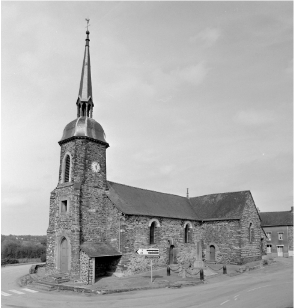
Elévation Sud-Ouest : vue générale
