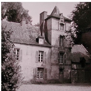
Façade antérieure de l'ancien manoir du Val-Rouxel (1976) Repro. Patrick Pichouron, Autr. Christian Demouveaux IVR53_20032203178NUCB
