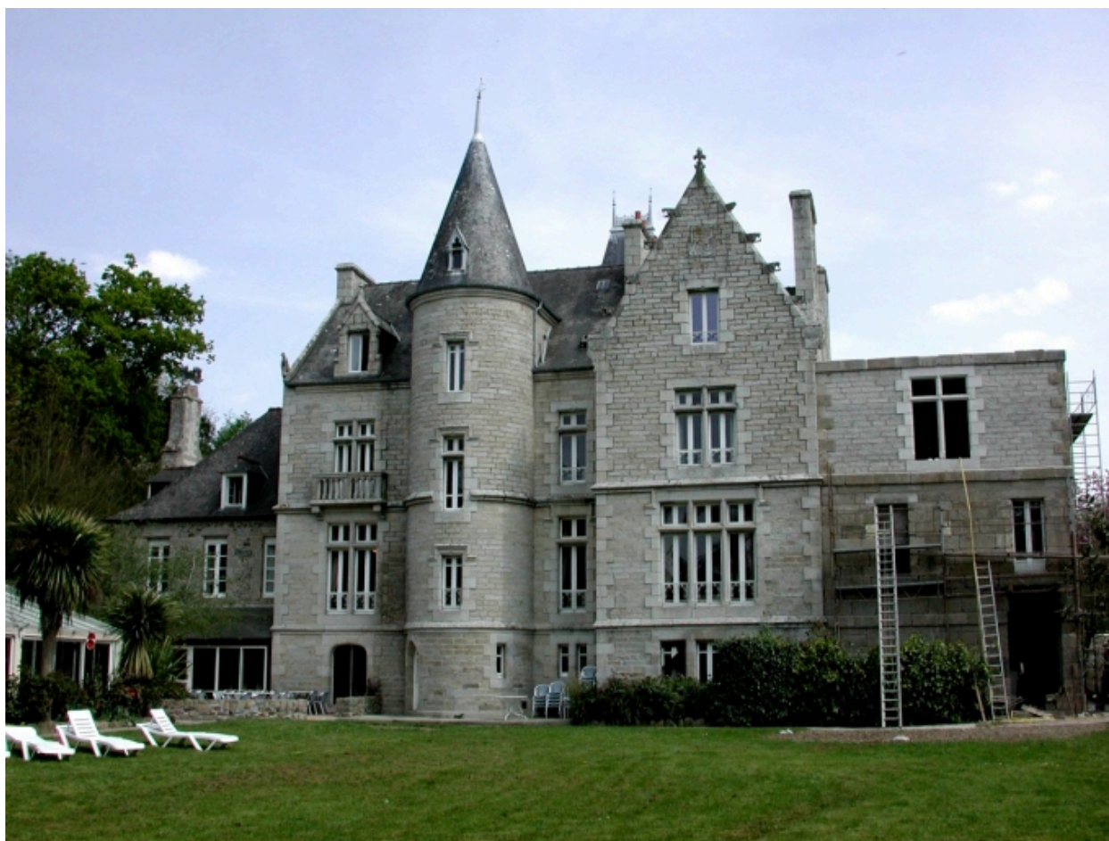
Façade postérieure du corps de logis principal (2003)
