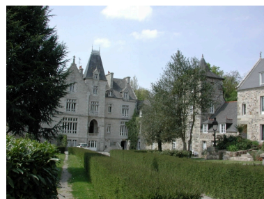
Vue générale du château du Val (2003) Phot. Patrick Pichouron IVR53_20032203185NUCA
