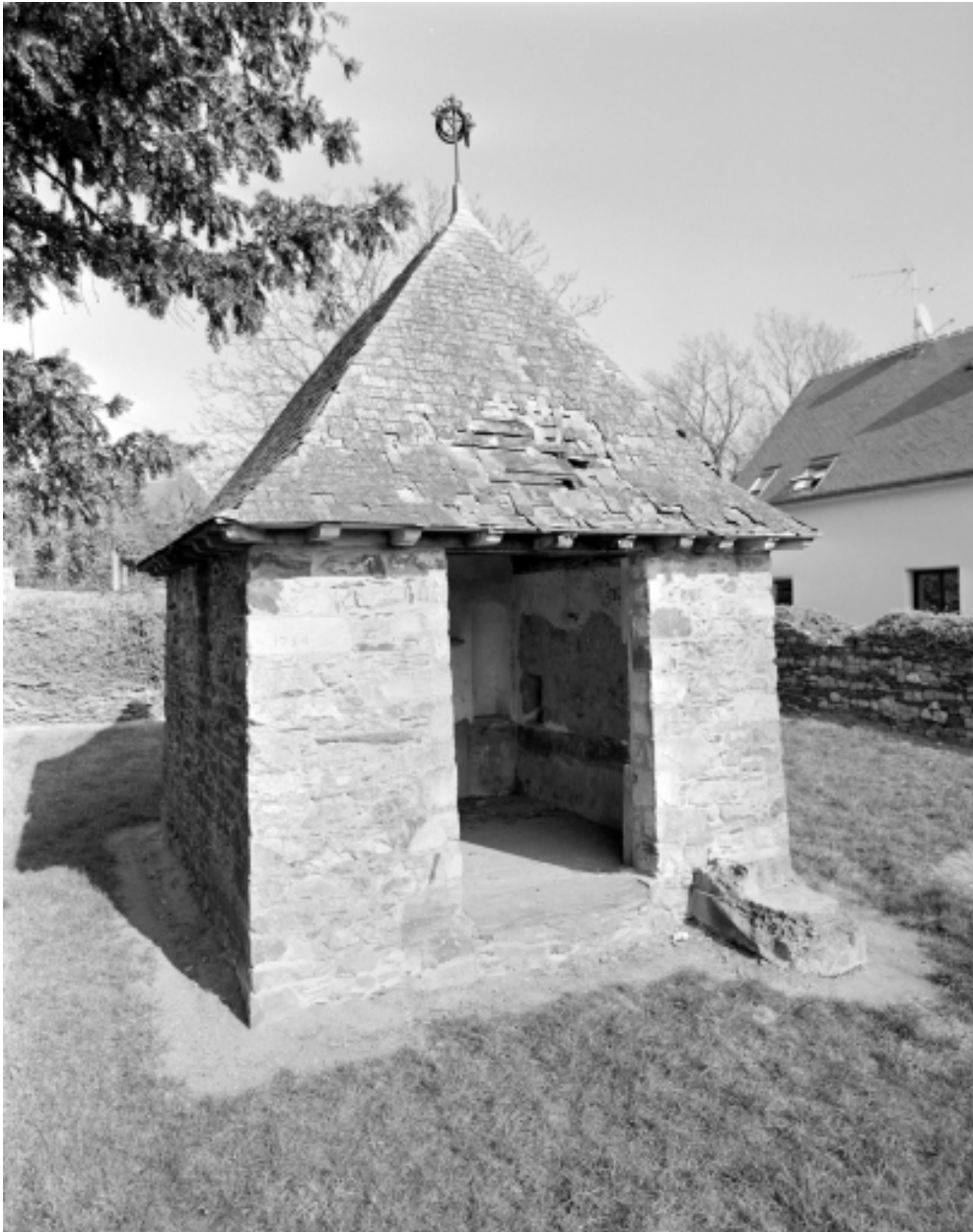
Elévation Sud : vue générale
