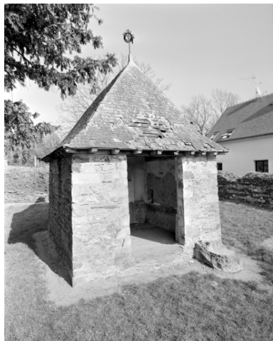
Elévation Sud : vue générale Phot. Bernard Bègne, Phot. M. Loyon IVR53_19933500169X
