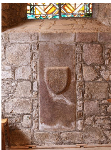
Pierre avec écusson dans le mur Phot. Marine Michel IVR53_20133502121NUCA
