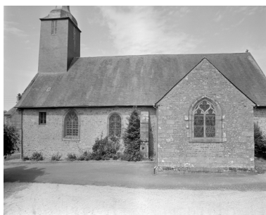
Elévation Sud-Ouest : vue générale Phot. Guy Artur, Phot. Norbert Lambart IVR53_19943501466X
