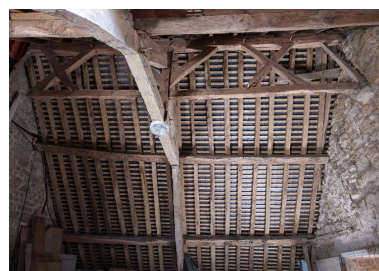
Vue de la charpente Phot. Marine Michel IVR53_20133502131NUCA
