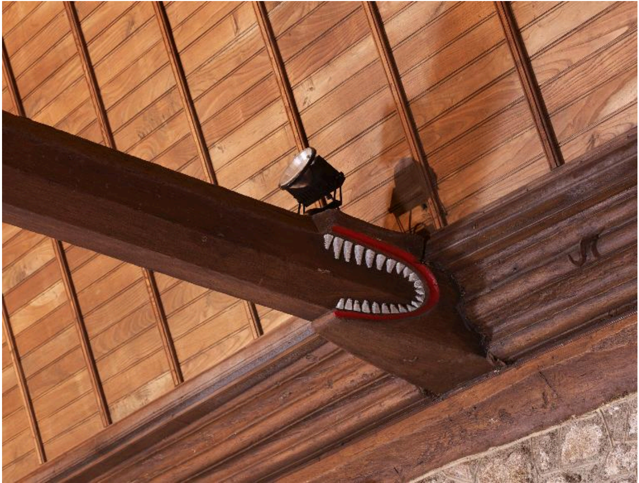
Détail d'une poutre et d'un engoulant
