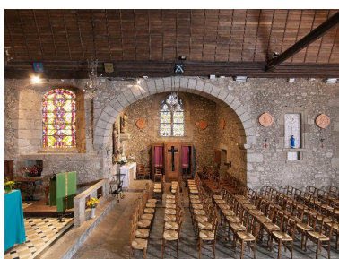
Vue sur le bas-côté Phot. Marine Michel IVR53_20133502115NUCA
