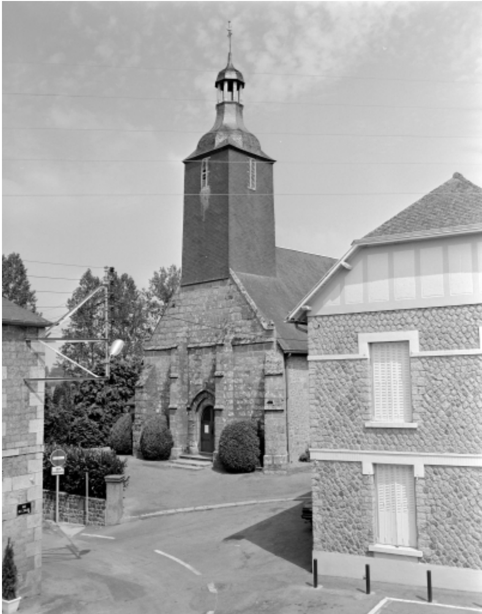
Elévation Ouest : vue générale
