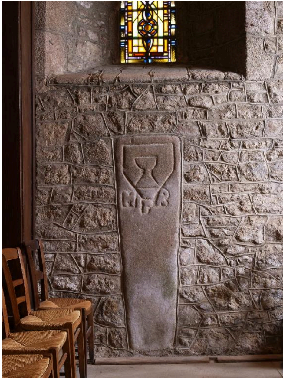
Pierre tombale remployée dans le mur
