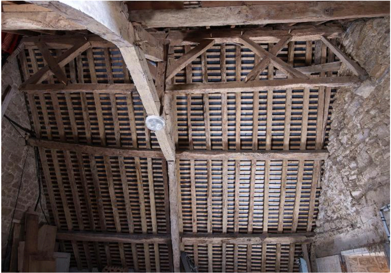
Vue de la charpente
