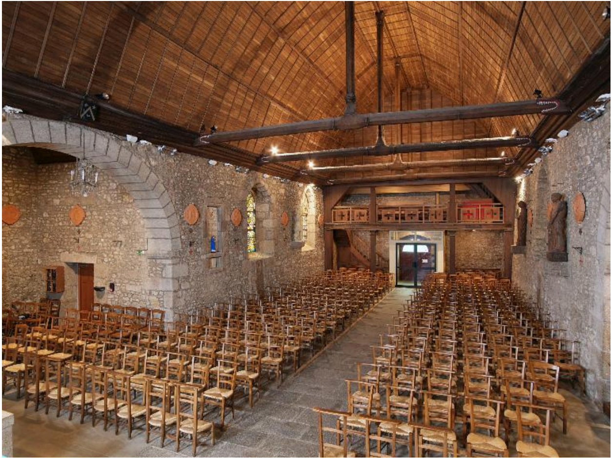
Vue intérieure vers la porte principale
