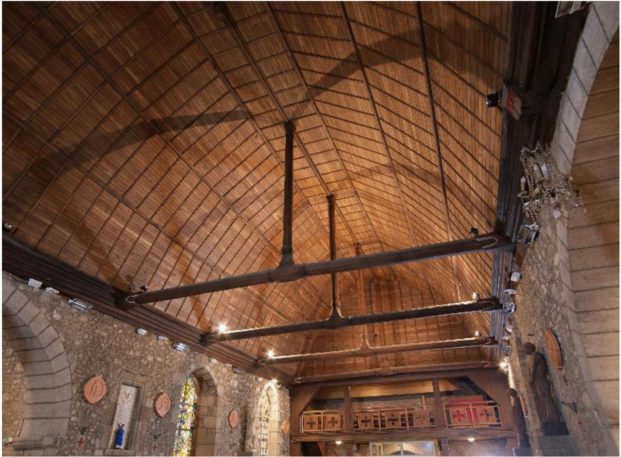
Vue générale du plafond
