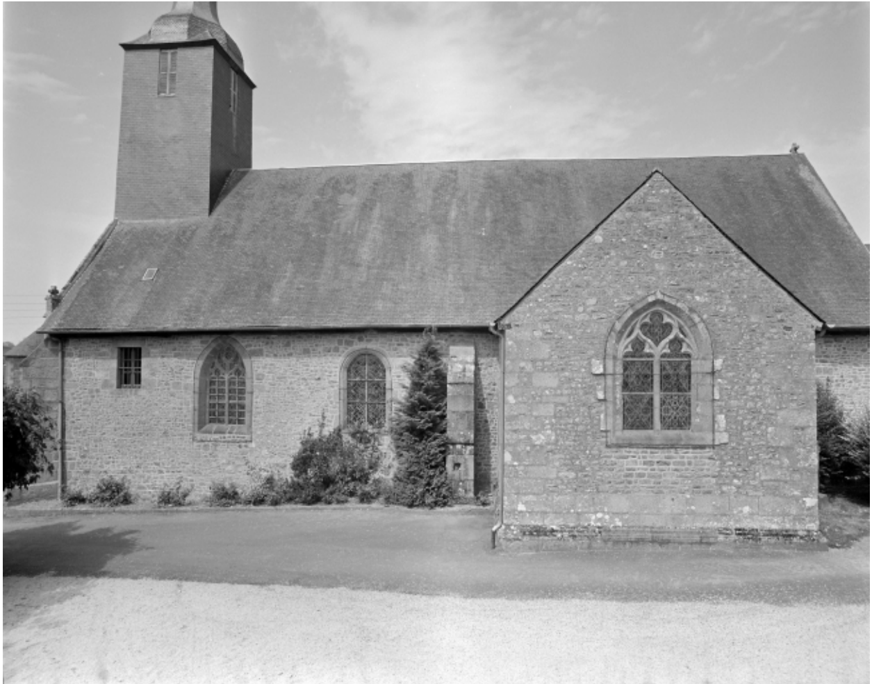
Elévation Sud-Ouest : vue générale
