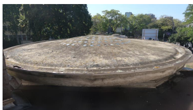
Le toit de la rotonde (G-R. Lefort, architecte, 1936-1938) Phot. Thierry Goyet IVR53_20182206161NUCA
