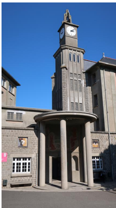
Détail sur la rotonde et le beffroi (G-R. Lefort architecte, 1936-1938). Phot. Thierry Goyet IVR53_20182206178NUCA
