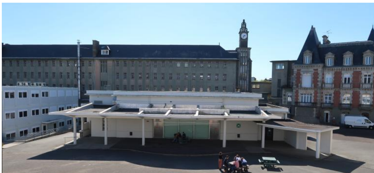
Vue d'ensemble prise depuis le bâtiment A (à gauche, les préfabriqués du chantier du nouveau réfectoire).
