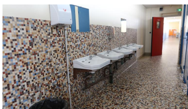
Lavabos et sanitaires aménagés dans un couloir du bâtiment A. Phot. Thierry Goyet IVR53_20182206175NUCA
