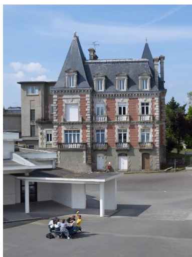
Le bâtiment administratif et logement du proviseur, anciennement Villa Baratoux, façade nord-est. Phot. Bernard Bègne IVR53_20192200560NUCA
