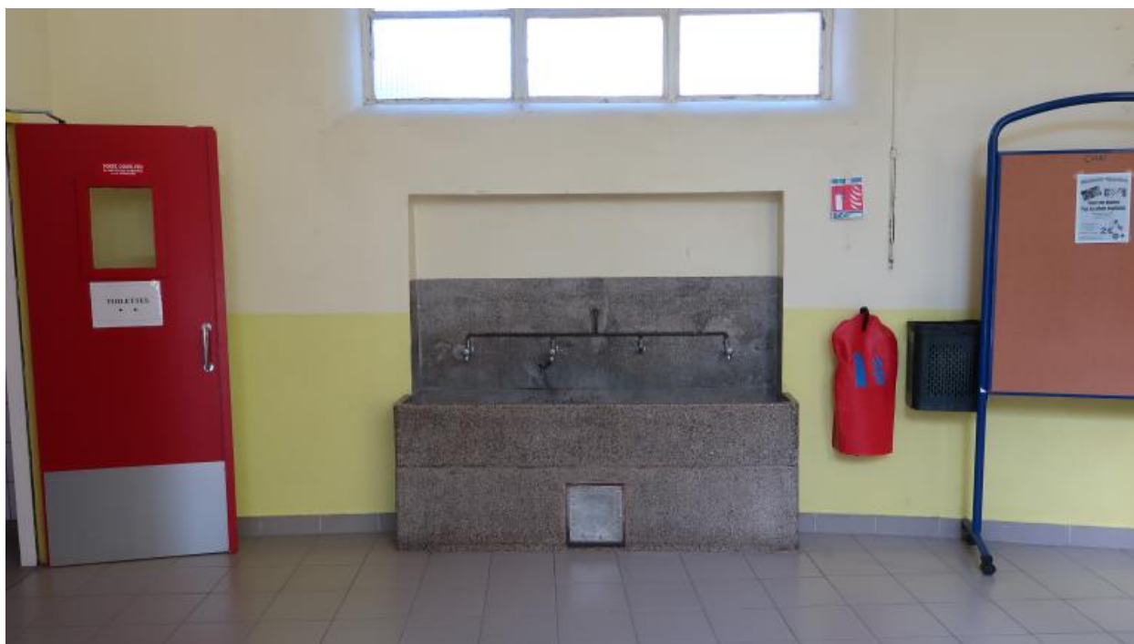
Un lavabo collectif dans le bâtiment A.
