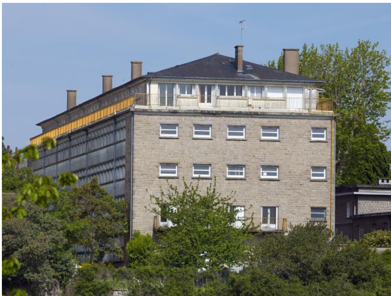
Bâtiment D, internat de 1961 (L. Arretche, Jean et Yann Fauny, architectes), également externat aujourd'hui : pignon sud-est. Vue prise de la rive opposée de la vallée du Gouédic.
