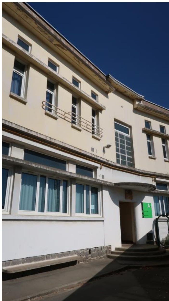
Une entrée du bâtiment A (externat ; G-R. Lefort, architecte, 1934), à l'origine entrée située dans la cour du secondaire.
