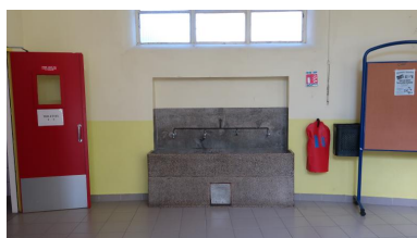
Un lavabo collectif dans le bâtiment A. Phot. Thierry Goyet IVR53_20182206171NUCA
