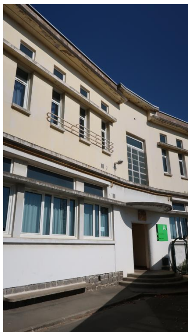
Une entrée du bâtiment A (externat ; G-R. Lefort, architecte, 1934), à l'origine entrée située dans la cour du secondaire. Phot. Thierry Goyet IVR53_20182206154NUCA
