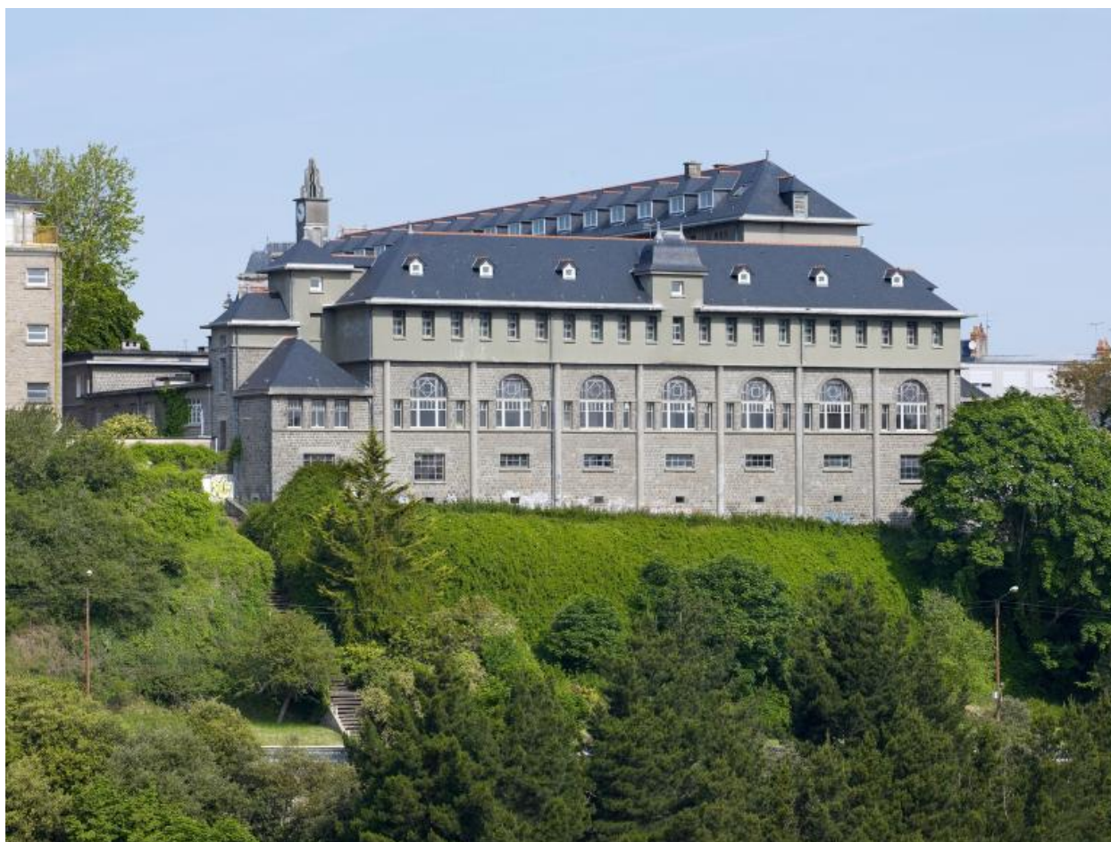
Vue du réfectoire, façade sud-est, prise de la rive opposée de la vallée du Gouédic.
