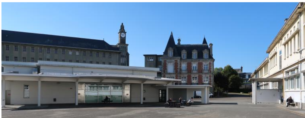
Vue d'ensemble depuis la cour. Au premier plan le gymnase (G-R. Lefort, architecte, 1934).
