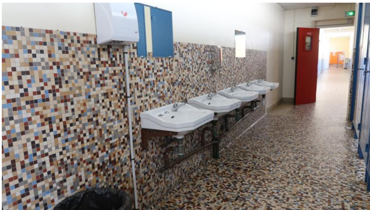
Lavabos et sanitaires aménagés dans un couloir du bâtiment A.
