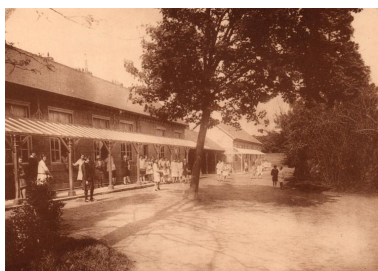
Cour de récréation, bâtiments et galeries dans les années 1920 (aujourd'hui disparus).
