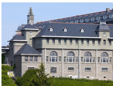
Vue du réfectoire, façade sud- est, prise de la rive opposée de la vallée du Gouédic. A l'arrière plan, toiture de l'internat et beffroi. Phot. Bernard Bègne IVR53_20192200576NUCA
