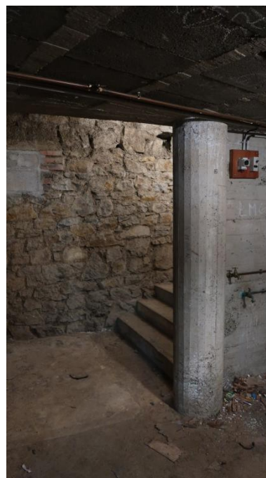
Sous-sol du bâtiment A (G-R. Lefort architecte, 1934) : des soubassements en pierre sous les murs, et en béton sous les planchers. Phot. Thierry Goyet IVR53_20182206170NUCA
