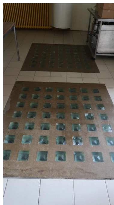
Système d'éclairage des caves de la cuisine : béton et pavés de verre (G- R. Lefort, architecte, 1936-1938). Phot. Thierry Goyet IVR53_20182206185NUCA
