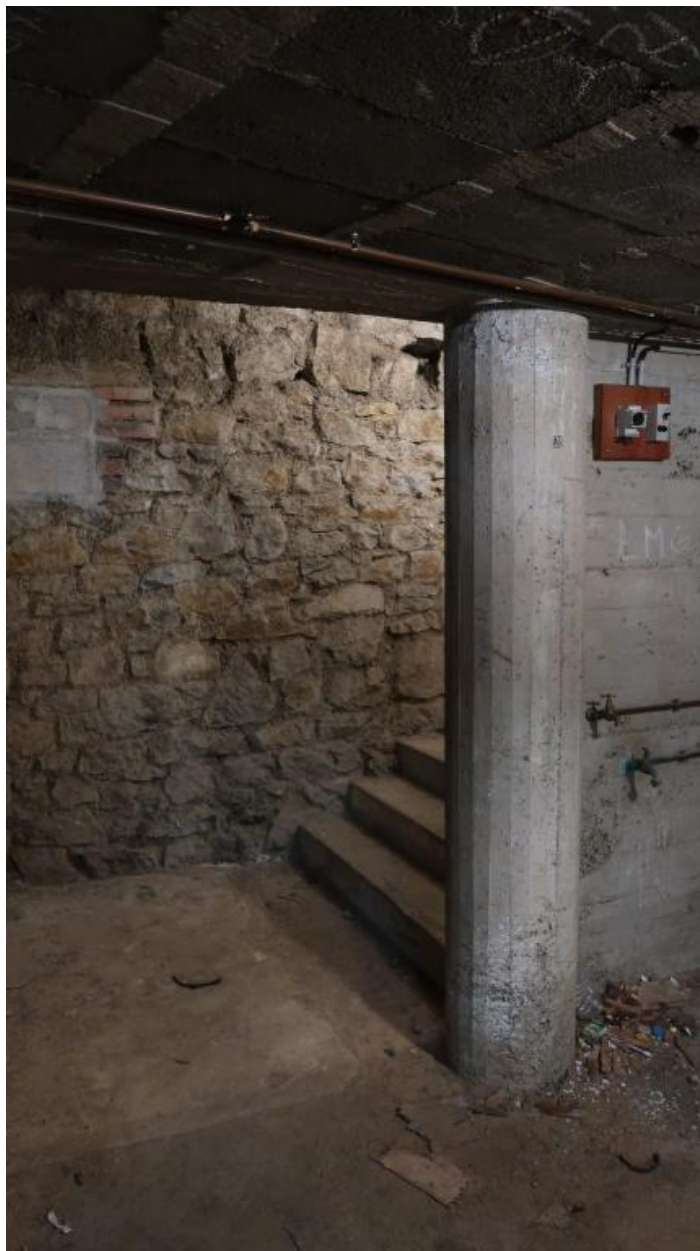
Sous-sol du bâtiment A (G-R. Lefort architecte, 1934) : des soubassements en pierre sous les murs, et en béton sous les planchers.
