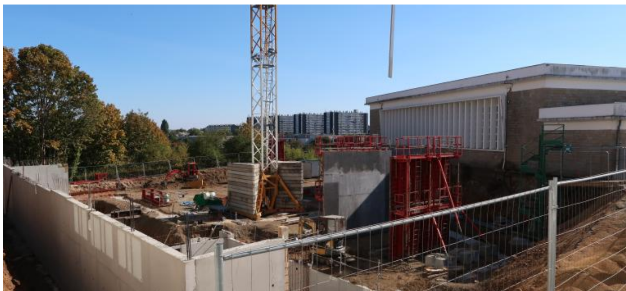
Le nouveau réfectoire en cours de construction. A l'arrière plan le gymnase des années 1960.
