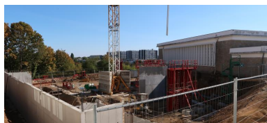
Le nouveau réfectoire en cours de construction. A l'arrière plan le gymnase des années 1960. Phot. Thierry Goyet IVR53_20182206168NUCA
