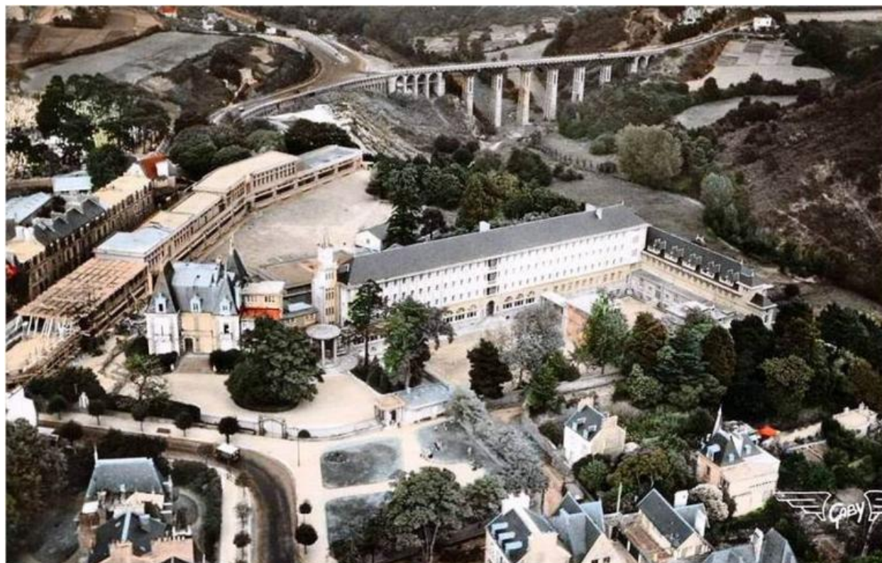
Vue aérienne du lycée, au cour de la construction de l'extention et de la surélévation du début des années 1950.
