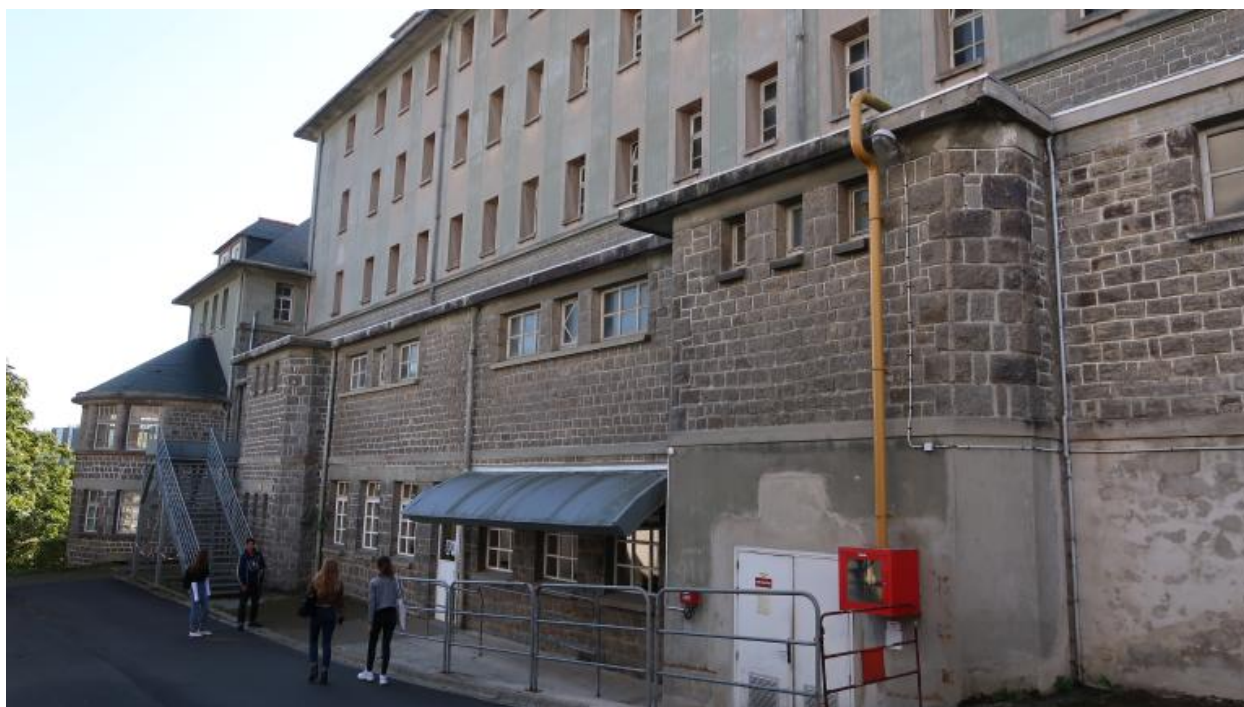
Façade arrière de l'internat (G-R. Lefort, architecte, 1936-1938). A l'arrière plan, "l'abside" du réfectoire.
