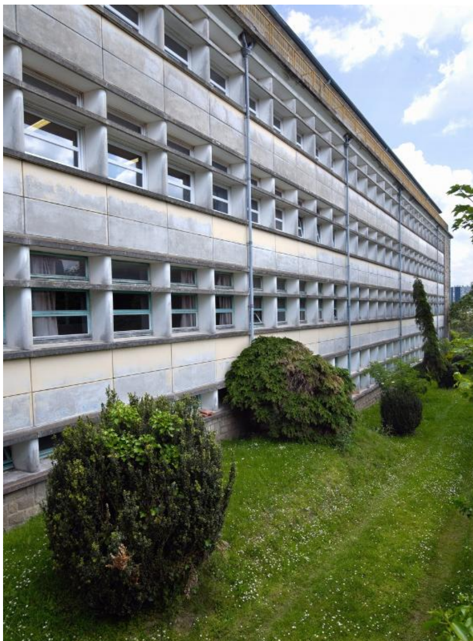
Bâtiment D, internat de 1961 (L. Arretche, Jean et Yann Fauny, architectes), également externat aujourd'hui : façade sud. Le bandeau horizontal, rappelant les fenêtres à meneaux, casse la verticalité de la trame.
