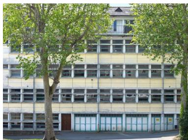
Bâtiment D, internat de 1961 (L. Arretche, Jean et Yann Fauny, architectes), également externat aujourd'hui : détail de la façade nord-est. Phot. Bernard Bègne IVR53_20192200536NUCA
