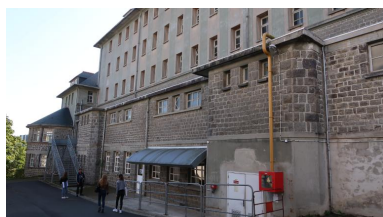
Façade arrière de l'internat (G-R. Lefort, architecte, 1936-1938). A l'arrière plan, "l'abside" du réfectoire. Phot. Thierry Goyet IVR53_20182206152NUCA
