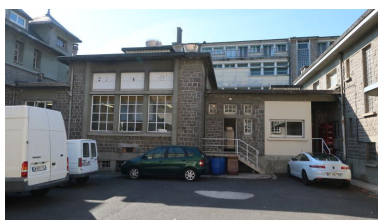
Façade sur cour des cuisines (G- R. Lefort, architecte, 1936-1938), à l'arrière plan, l'internat des 1962. Phot. Thierry Goyet IVR53_20182206150NUCA
