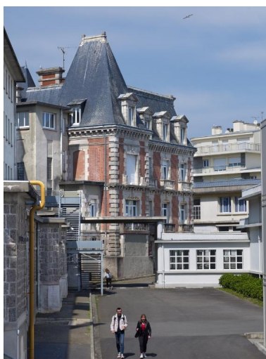
Galerie de liaison entre l'internat et le gymnase (actuel amphithéâtre) et ancienne Villa Baratoux (bâtiment administratif + logement du proviseur). Vue prise depuis le sud-est. Phot. Bernard Bègne IVR53_20192200561NUCA
