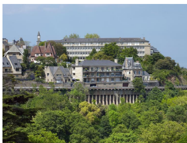
Dans un cadre urbain et naturel exceptionnel, la façade sud-ouest du bâtiment D, prise depuis un pont urbain, sur la vallée du Gouédic.
