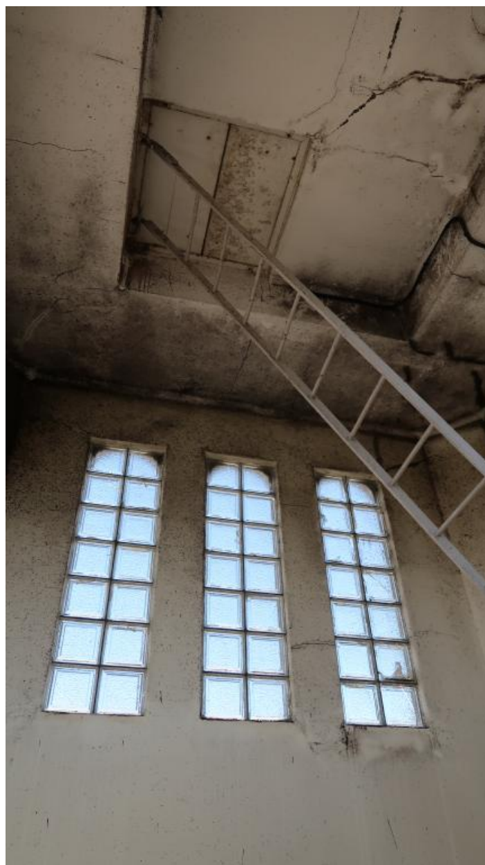
Vue intérieure de la tour (G-R. Lefort architecte, 1936-1938).
