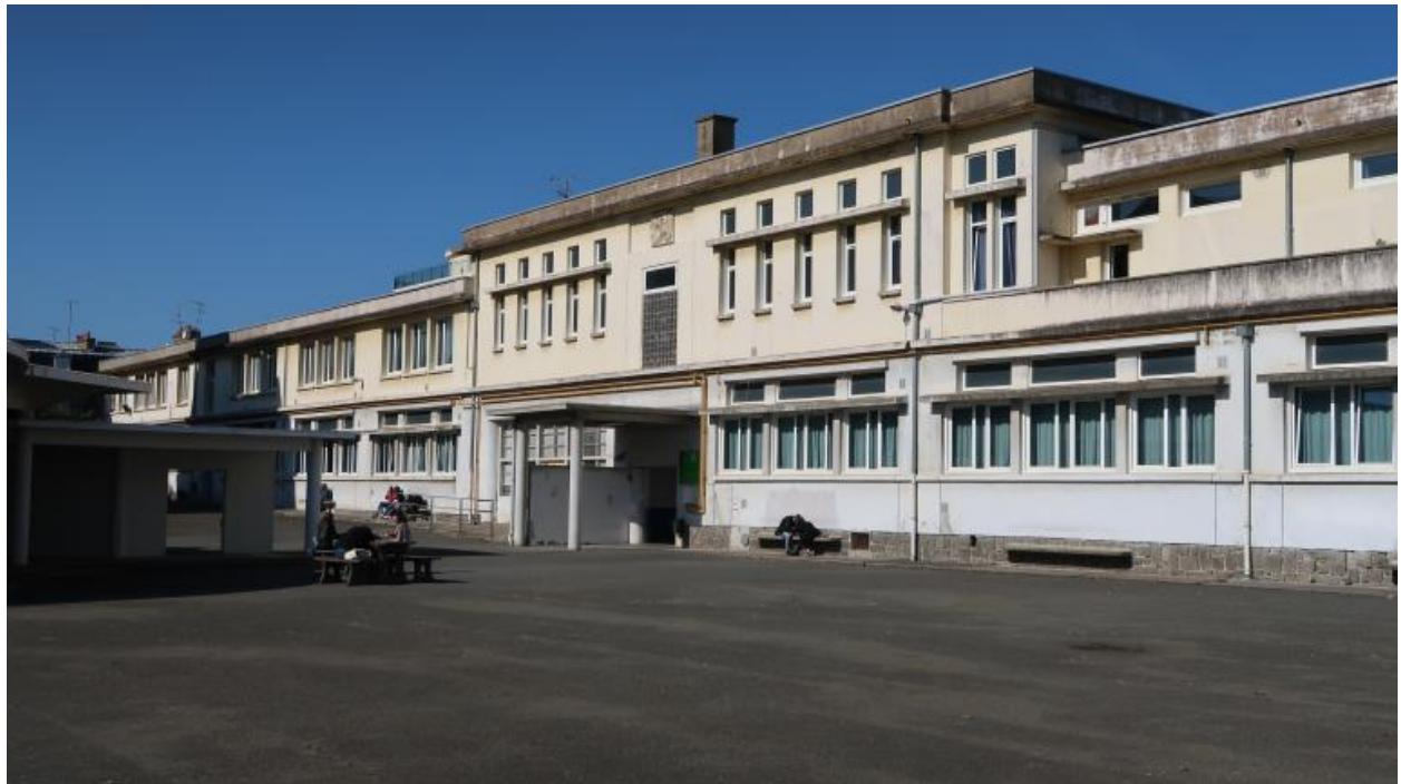
Façade sur cour de l'externat (bâtiment A ; G-R. Lefort, architecte, 1934) : un vocabulaire rationaliste et moderne : béton, pavés de verre... Au centre, l'entrée située, à l'origine, entre les cours primaire et secondaire. à l'origine).
