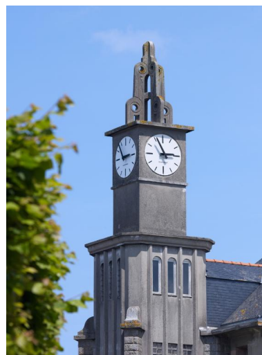
Le beffroi : détail (G-R. Lefort, architecte, 1936-1938). Phot. Bernard Bègne IVR53_20192200550NUCA
