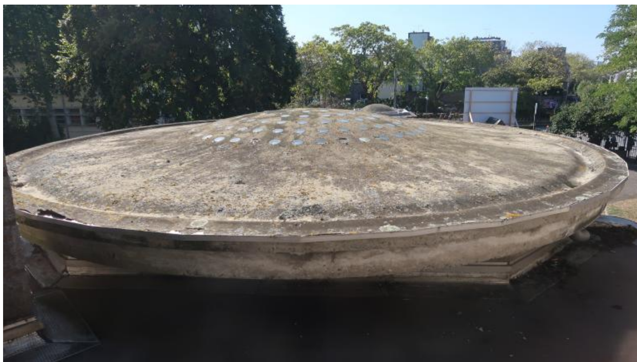
Le toit de la rotonde (G-R. Lefort, architecte, 1936-1938)
