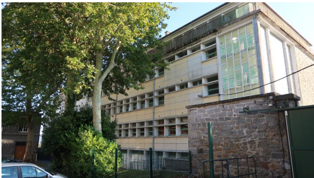
Bâtiment D, internat de 1961 (L. Arretche, Jean et Yann Fauny, architectes), également externat aujourd'hui : façade nord et verrière de l'escalier nord-ouest.
